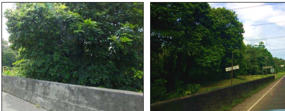
Figura 8.8. Estado de la cobertura vegetal presente en algunos puentes y las zonas de protección de los ríos y quebradas sobre la ruta 32; marzo, 2016.
