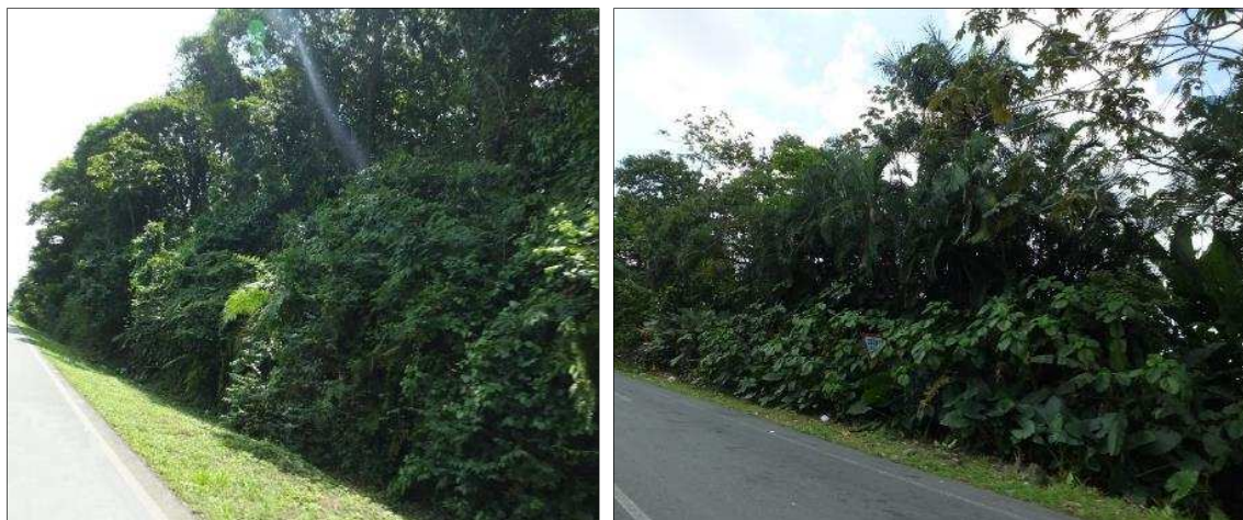
Figura 8.4. Estado de la cobertura vegetal del actual derecho de la vía Ruta 32, áreas de matorrales arbolados en secciones aledañas a zonas agrícolas y en taludes de fincas sin actividad económica activa; marzo, 2016.
