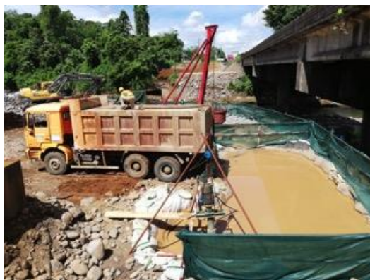
Figura 20. Carga de sedimentos utilizando bomba y vagoneta sellada, río Guácimo.
