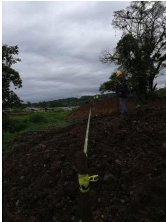
Figura 1. Delimitación de zona de protección de quebrada en escombrera del kilómetro 52.
