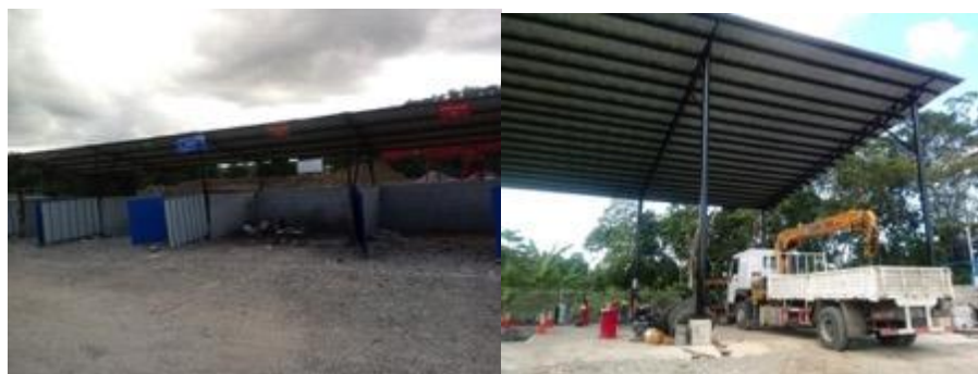
Figuras 10 y 11. Sitio de acopio y taller mecánico.
