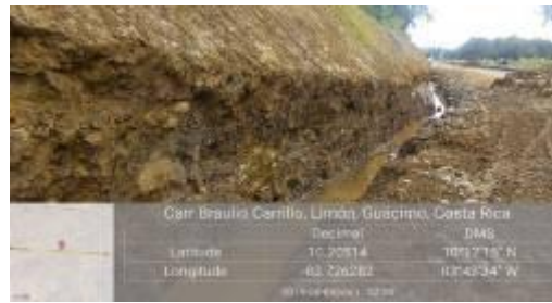
Definición del talud y limpieza de desagües
