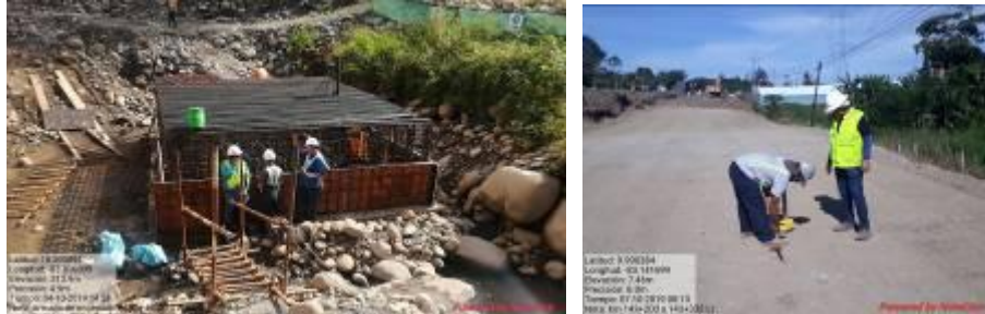
Trabajos en puentes y verificación de calidad. En estos casos no hay emisiones.
