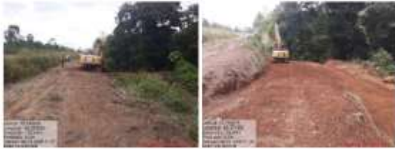
Figura 32. Excavación de acceso para nueva alcantarilla en el km 98.
