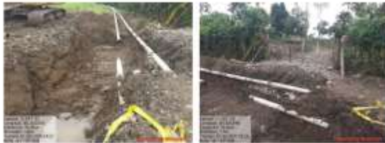
Figura 13. Excavación para cambio de tubería de servicios públicos.
