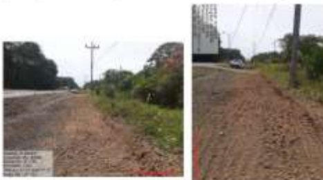
Figura 17. Limpieza de capa vegetal.
