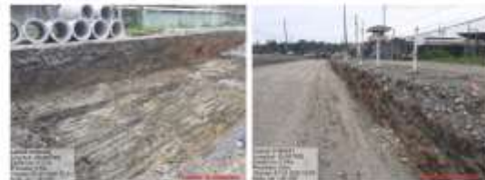
Figura 18. Excavación para sustracción de materiales.
