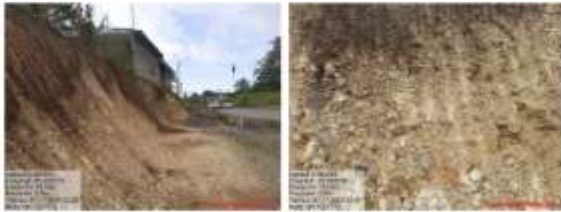
Figura 20. Revisión de perfil de excavación.
