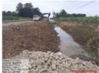
Figura 34. Excavación para colocación de marcos de gaviones.
