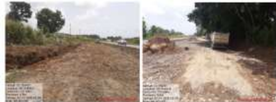
Figura 9. Limpieza del derecho de vía
