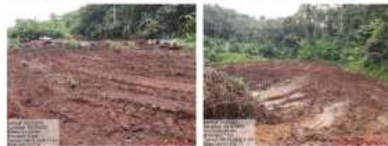
Figura 32. Ampliación de la esplanada km 97.
