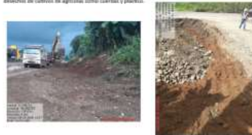
Figura 8. Conformación y sustitución en el 86 km.
