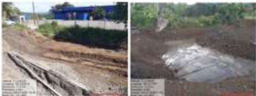
Figura 35. Excavación del derecho de vía km 133.
