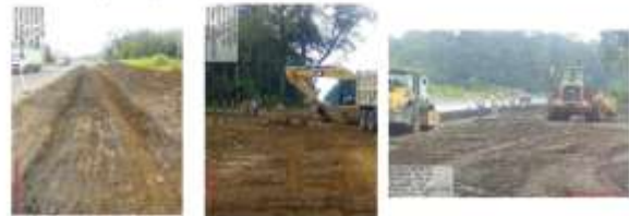
Figura 3. Obras en los km68- 69 LI
