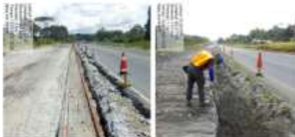
Figura 8. Inspección del área donde se construye puente peatonal
