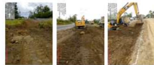
Figura 6. Trabajos en KM 73 LI
