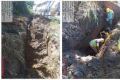
Figura 17. Colocación de tablero del AYA.
