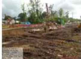
Figura 7. Se excava una área de movimiento de tierra para construcción de puente peatonal
