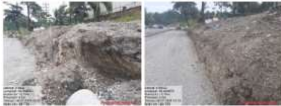
Figura 18. Revisión de perfiles de excavación.
