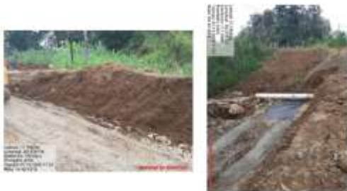
Figura 11. Limpieza y excavación para acceso a alcantarilla.
