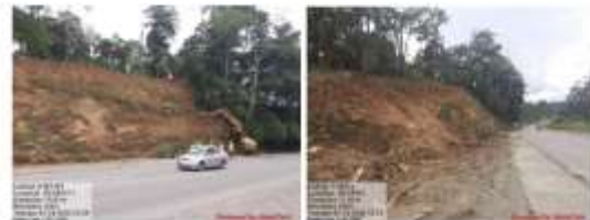
Figura 19. Limpieza de capa vegetal.
