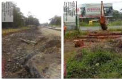
Figura 2. Corte de árboles, relleno y compactación de vía
