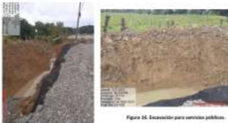
Figura 16. Excavación para servicios públicos.
