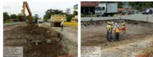
Figure 6. Se observan los escombros en este punto del km 67+800 y no hay afectación de evidencia arqueológica.
