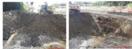
Figura 12. Excavación de nueva alcantarilla para paso del río Heredia.
