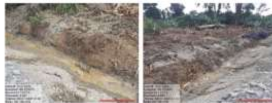
Figura 36. Excavación para marco de gaviones.
