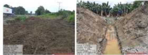
Figura 15. Excavación y sustracción del lado derecho.
