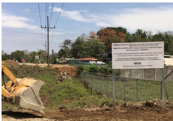
Figura 27. Instalación de rotulo de proyecto.
