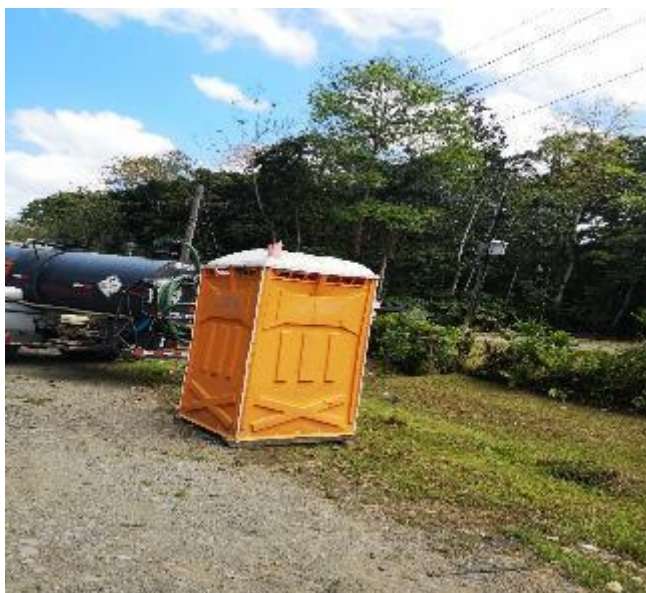
Figura 20. Limpieza de casetilla sanitaria.
