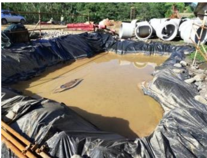
Figura 30. Pila de sedimentos cubierta de plástico en Río Toro Amarillo.
