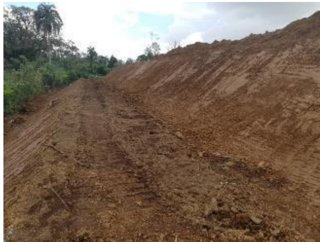
Figura 1. Conformación de taludes en escombrera K70.
