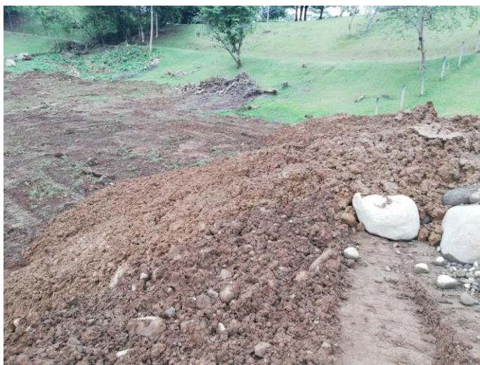
Figura 6. Escombrera K59 con tierra colocada de afuera hacia adentro.
