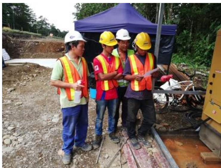
Figura 31. Capacitación de personal en alcantarilla K60 sobre uso de biorremediador.
