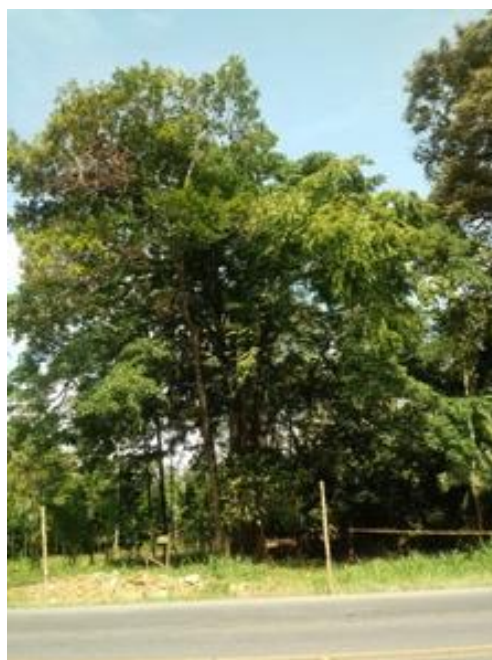
Figura 17. Paso de fauna elevado km 112+899.
