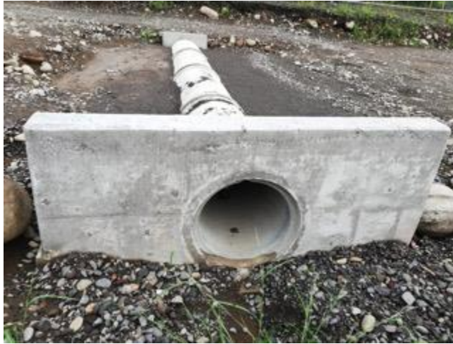
Figura 4. Alcantarilla K54+960, paso inferior redondo para reptiles.
