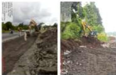
Figura 3. Extracción de asfalto/ excavación y colocación de material
