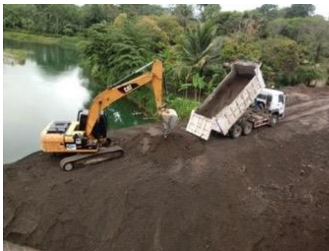
Figura 35. Movimiento de material de excavación para labores en el mismo Chirripó.
