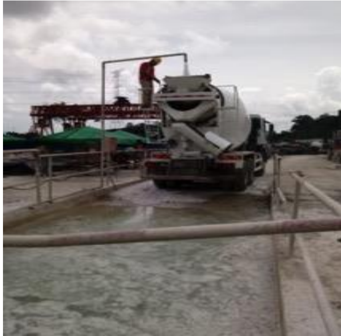
Figura 21. Recirculacion de agua en pila de lavado.
