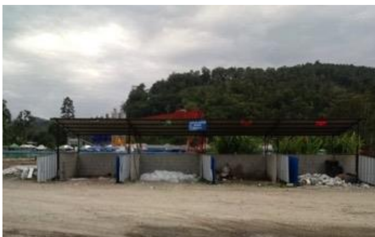
Figura 16. Centro de acopio campamento K115.
