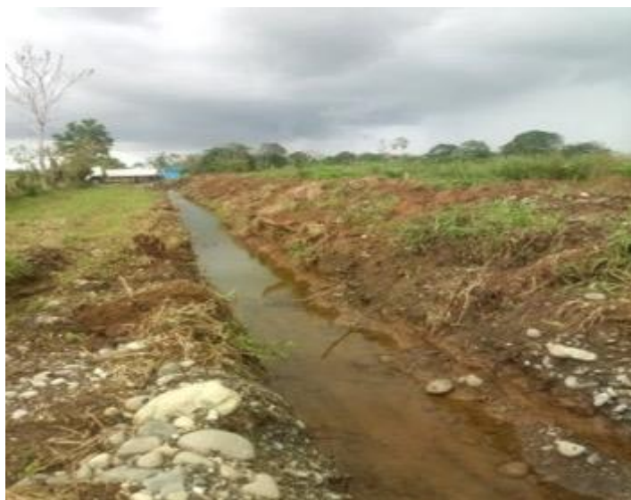
Figura 14. Manejo de aguas en escombrera km 132.
