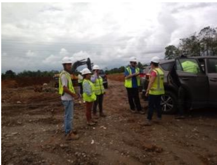
Figura 15. Visita de SETENA a escombreras.
