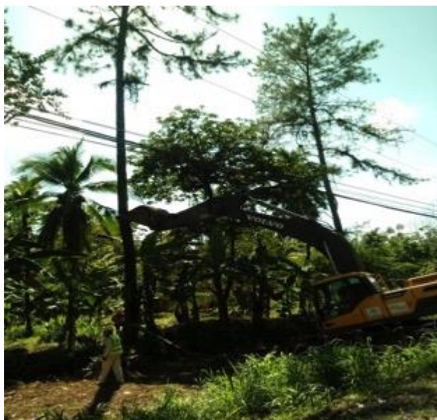
Figura 13. Corta de arboles km 129
