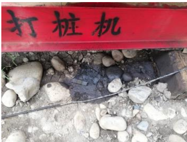
Figura 38. Derrame de aceite en suelo por fuga en perforadora en Río Reventazón.
