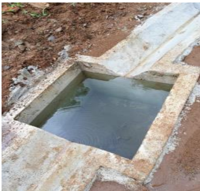
Figura 8. Sedimentador construido en escombrera K97.
