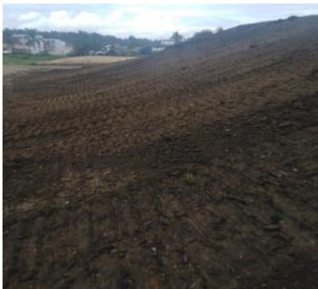
Figura 29. Compactación de talud escombrera 145.
