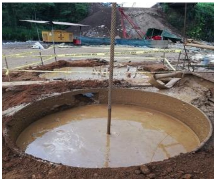
Figura 37. Drenaje de lodos proveniente de un pilote que pasa sobre otro pilote terminado, Río Toro Amarillo.
