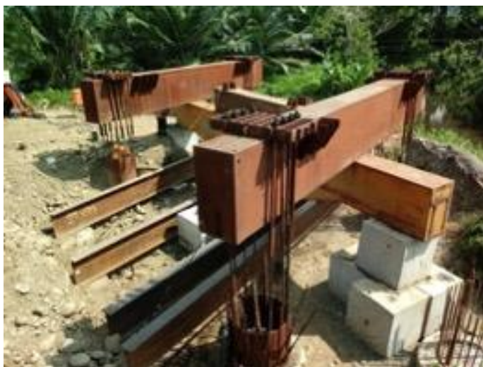
Figura 36. Trabajo en soldadura en río Aguas Claras.
