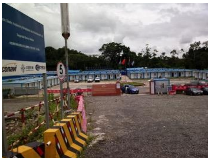
Figura 2. Estado acceso al campamento k115.
