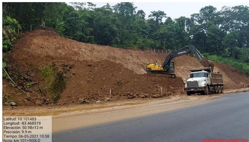
**Figura 12. Excavación de terrazas en el km 101.**
