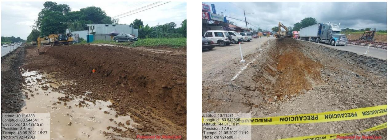
**Figura 8. Excavación de la vía del lado izquierdo, km 92**
