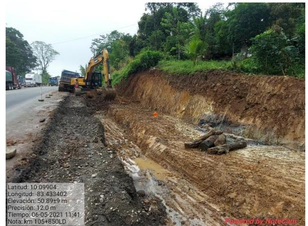
**Figura 14. Excavación y terraseo del talud del lado derecho.**
