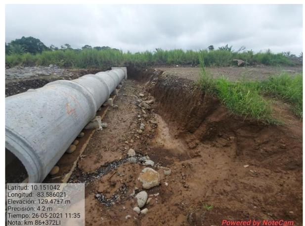
Figura 6. Revisión de perfiles de excavación.
