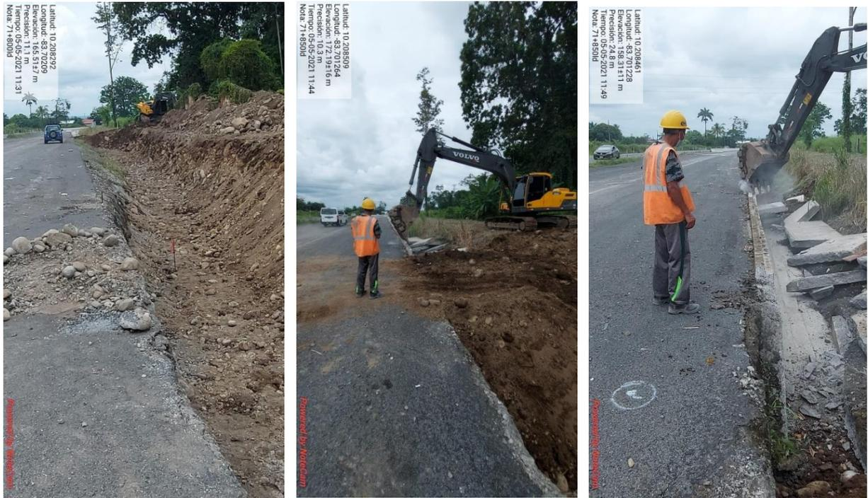
**Figura 4. Limpieza y excavación para construcción de cunetas.**
