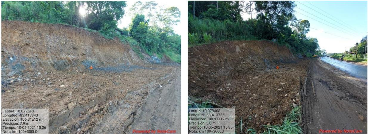
**Figura 15. Excavación del talud km 109.**
