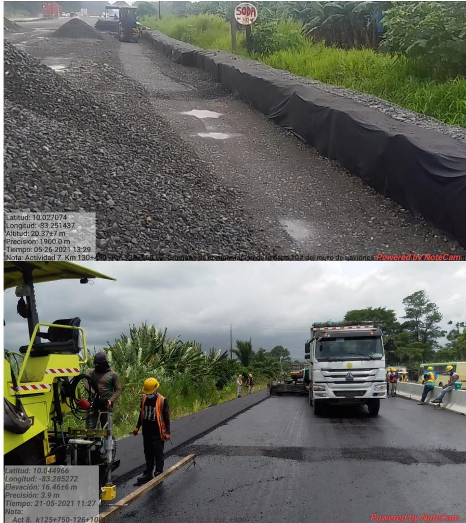
Figura 17. Construcción de gaviones y colocación de pavimento.
