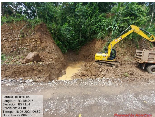
Figura 15. Excavación de alcantarilla km 99.
