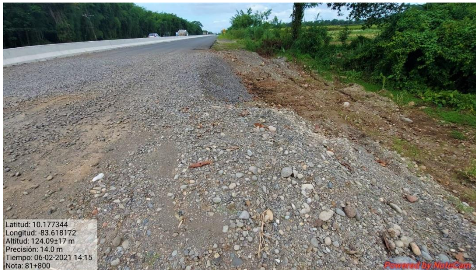
Figura 7. Área de paso de fauna y posteriormente cerrada.
