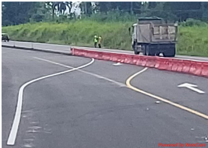
Figura 1. Demarcación de la vía Km 50+530 y posterior llenado de barrera
