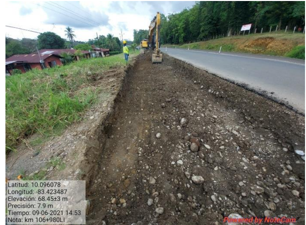
Figura 20. Excavación del talud y de la vía 106.
