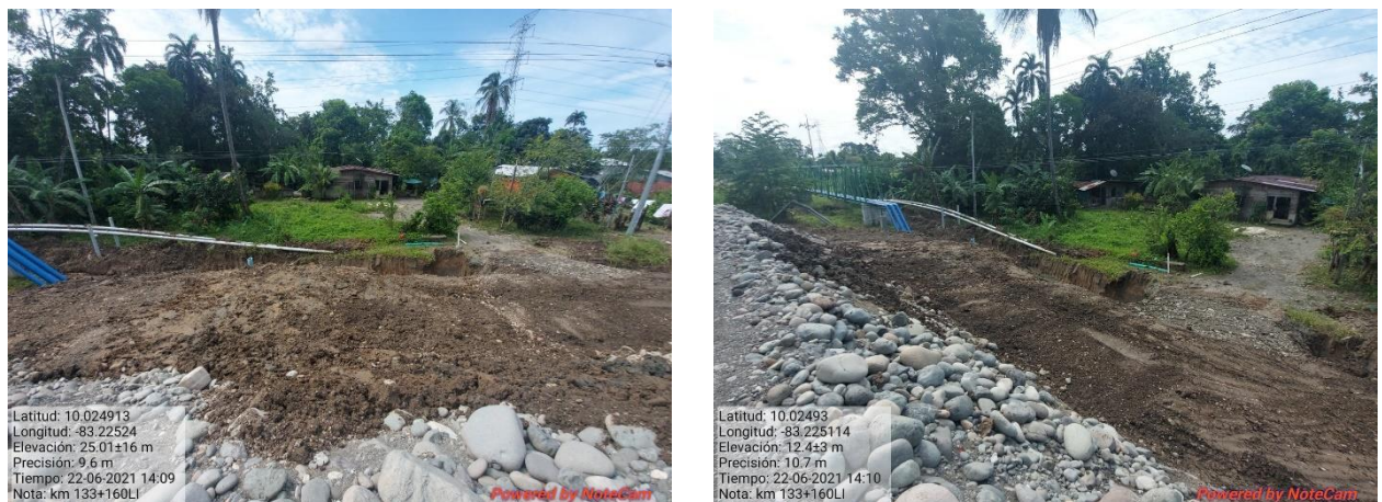
Figura 23. Limpieza de alcantarilla en el km 133.
