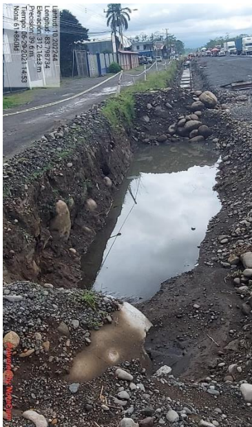
Figura 3. Trabajos en cunetas y desagües en km 61 y 62
