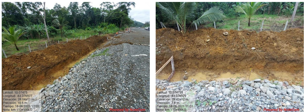
Figura 22. Zanjeo para colocar muros de gaviones.
