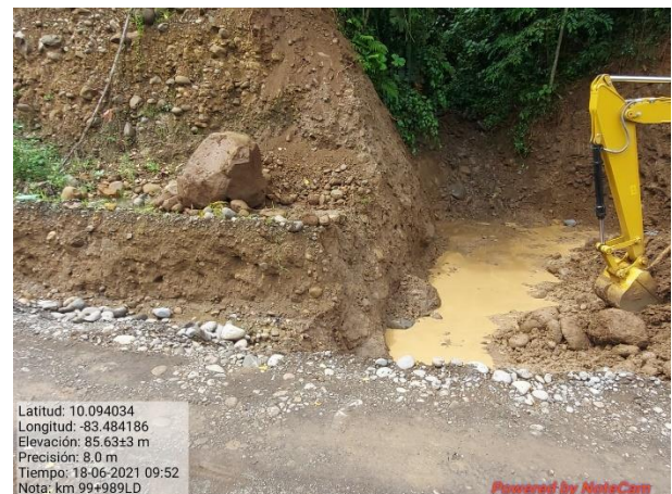
Figura 15. Excavación de alcantarilla km 99.
