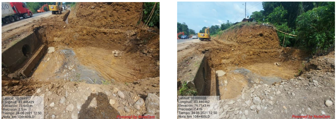
Figura 19. Excavación de alcantarilla km 104.
