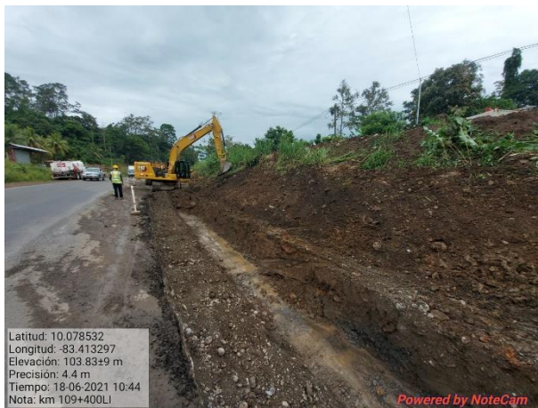
Figura 21. Excavación del talud y de la vía 106.
