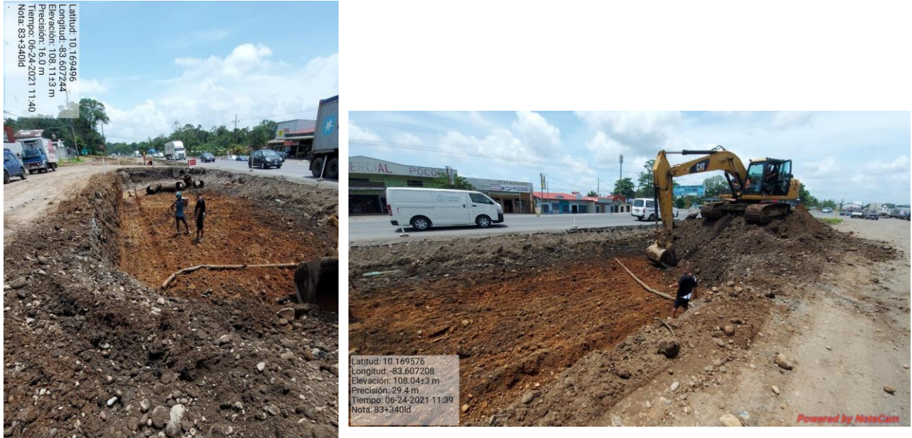
Figura 9. Personas dentro de área de excavación mientras maquinaria trabaja
