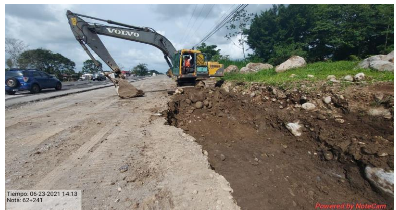
Figura 3. Trabajos en cunetas y desagües en km 61 y 62
