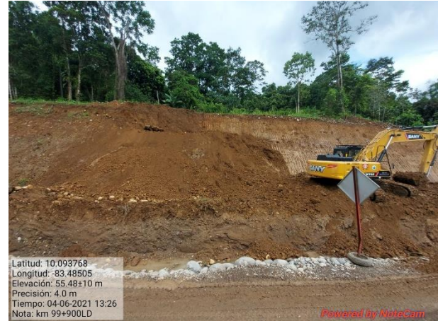
Figura 14. Excavación del talud km 99.
