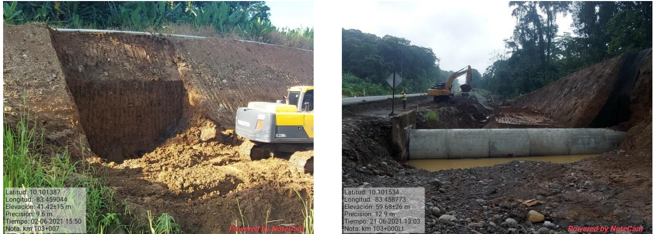
Figura 18. Excavación y terrazo para colocar alcantarilla km103.
