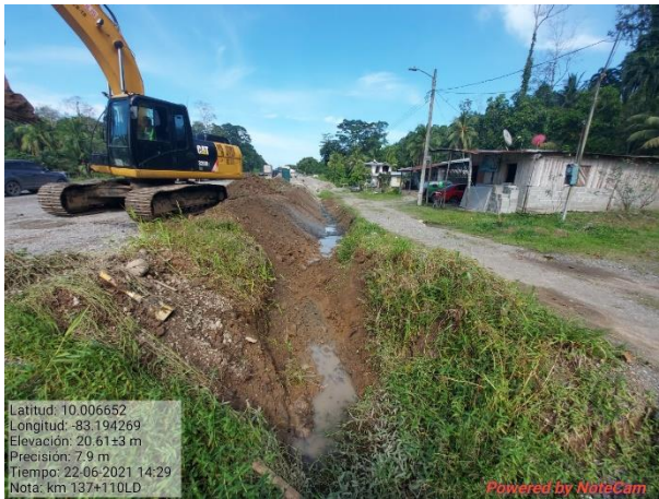
Figura 24. Limpieza de drenaje de alcantarilla
