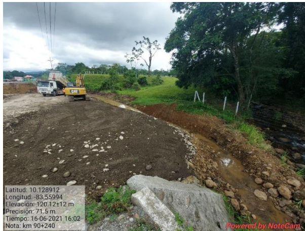
Figura 12. Excavación de alcantarilla lado derecho km 90.
