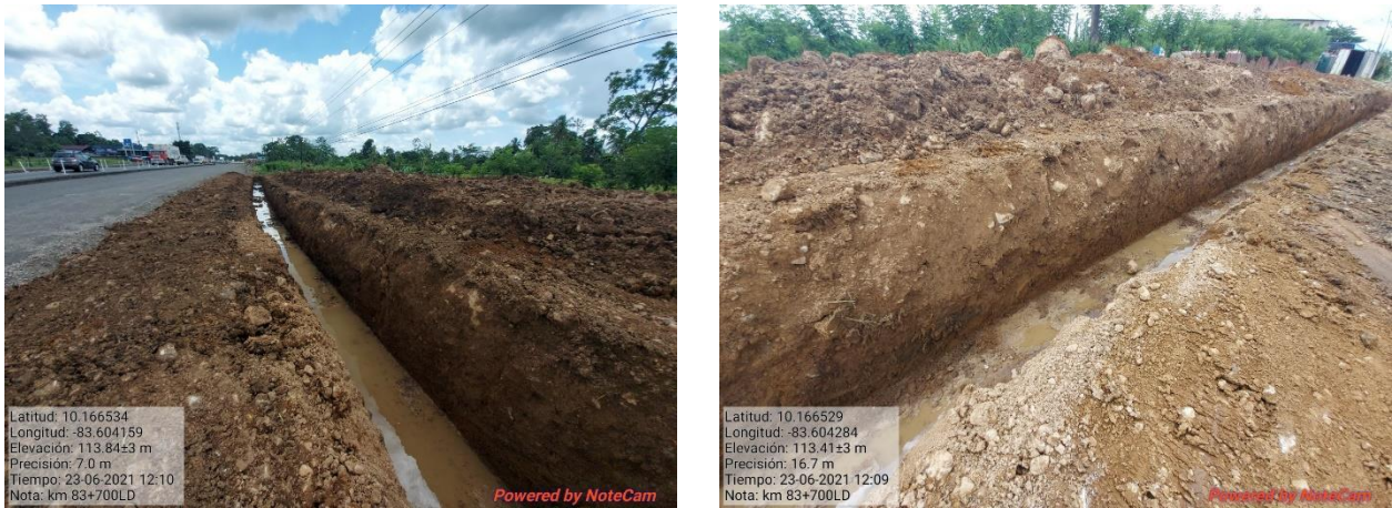
Figura 10. Zanjeo para colocación de servicios públicos.
