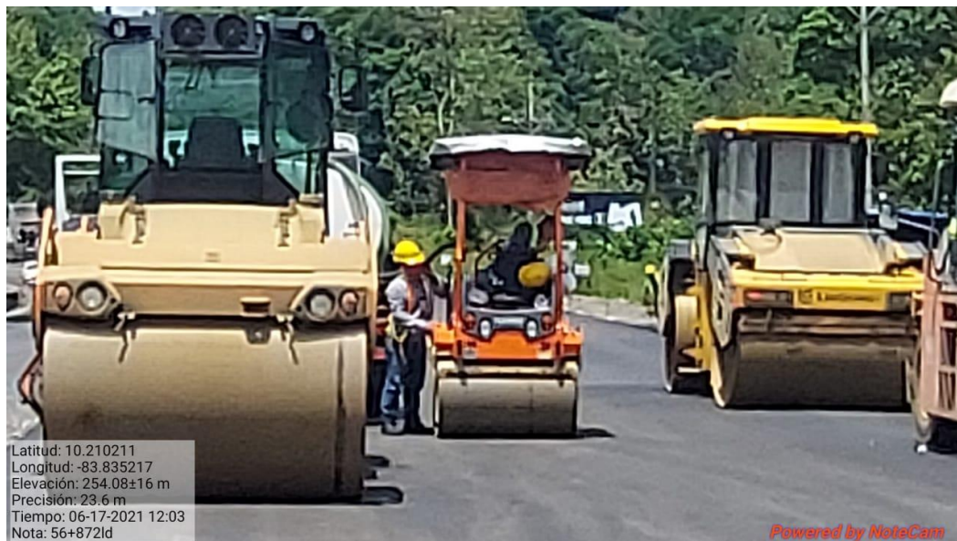
Figura 2. Compactación y trabajos finales en el sector del km 56
