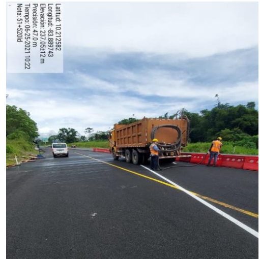
Figura 1. Demarcación de la vía Km 50+530 y posterior llenado de barrera
