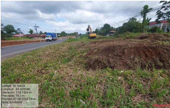
Figura 6. Levantamiento de la capa vegetal en km83+680/800LD
