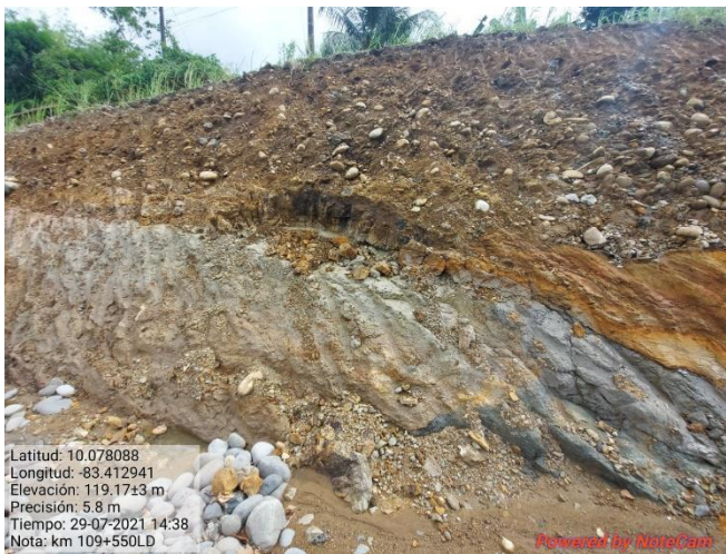
Figura 12. Excavación de talud km 109+550.
