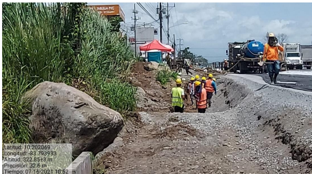
Figura 3. Trabajos en cunetas y desagües en km 61.
