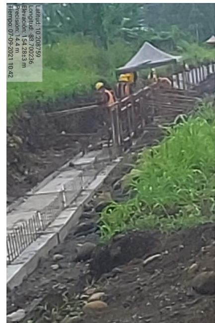
Figura 4. Km 71+400 LD, construcción de cuneta rectangular.
