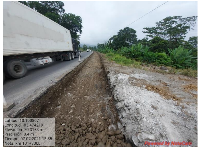
Figura 9. Excavación de ciclovía.
