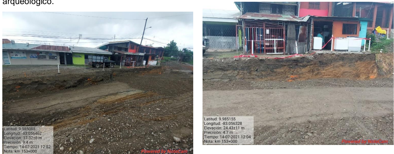
Figura 19. Excavación de la vía, km 153.
