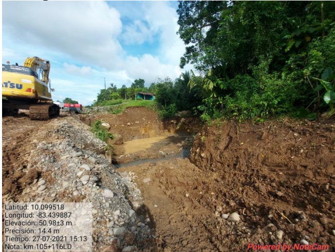
Figura 11. Excavación de alcantarilla km 105.
