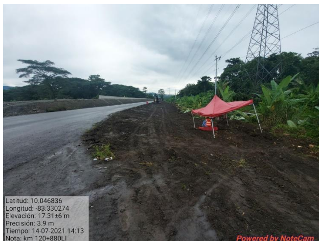
Figura 17. Limpieza de la capa vegetal km 120.
