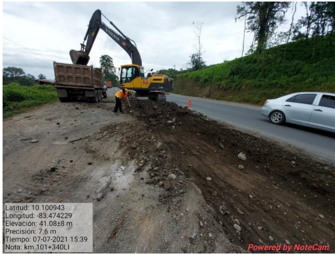
Figura 9. Excavación de ciclovía.
