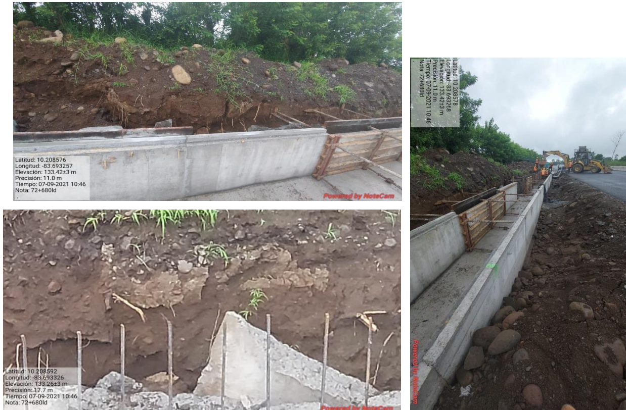
Figura 5. Km 72+680 LD, construcción de cuneta rectangular.
