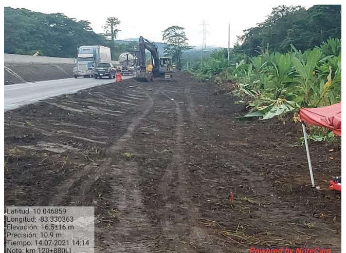
Figura 17. Limpieza de la capa vegetal km 120.
