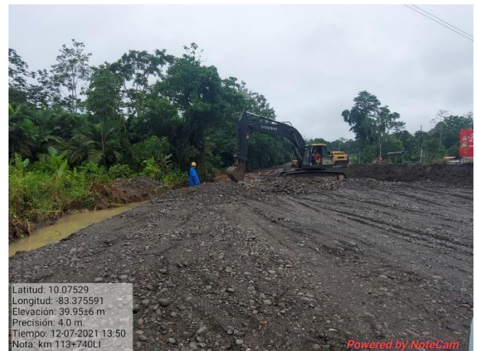
Figura 15. Excavación para colocar muros de gaviones en el km 113.
