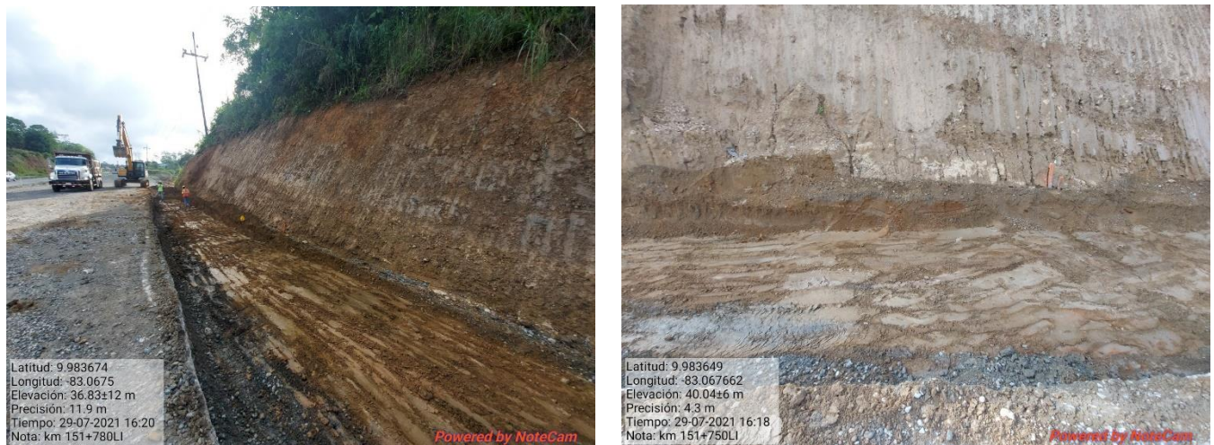
Figura 18. Excavación del talud en el km 151.
