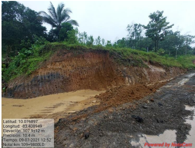
Figura 13. Excavación de talud km 109+990.
