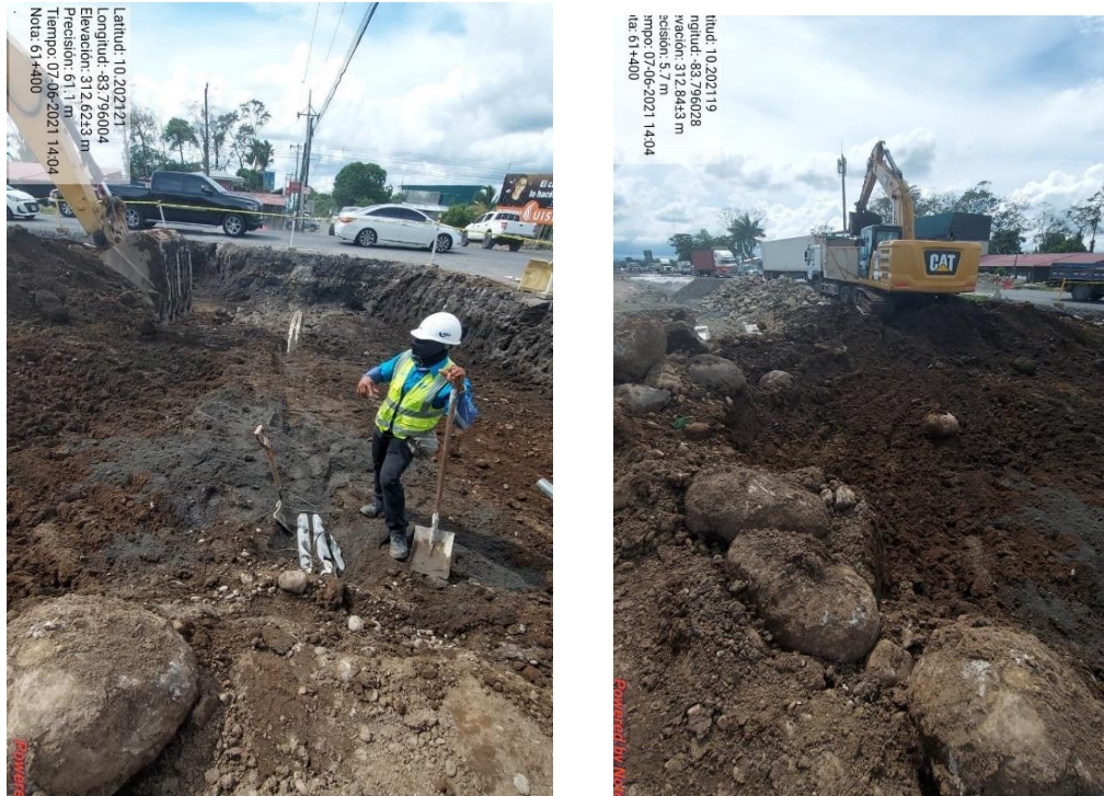
Figura 2. Excavación con conexiones subterráneas del ICE presentes.
