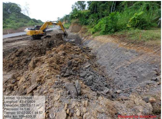
Figura 13. Excavación de talud km 109+990.
