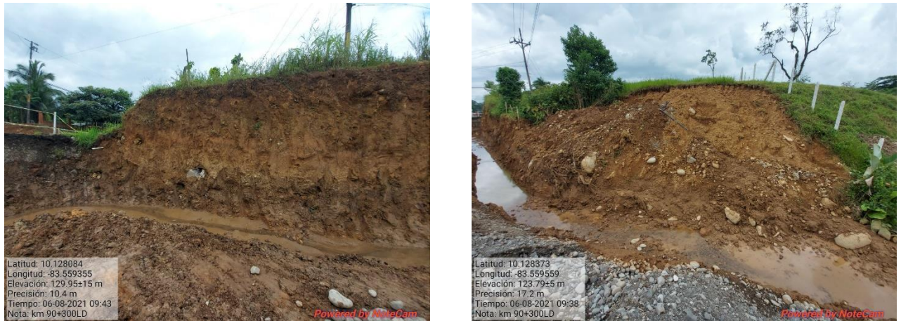
Figura 14. Excavación del talud km 90+300.
