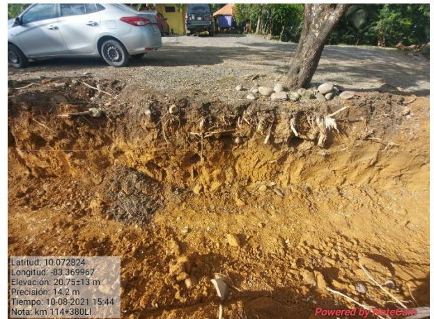
Figura 19. Zanqueo para construcción de cunetas.
