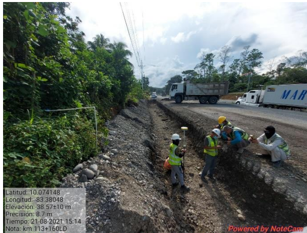
Figura 18. Zanqueo para construcción de cunetas.
