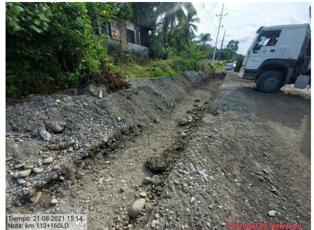
Figura 18. Zanqueo para construcción de cunetas.
