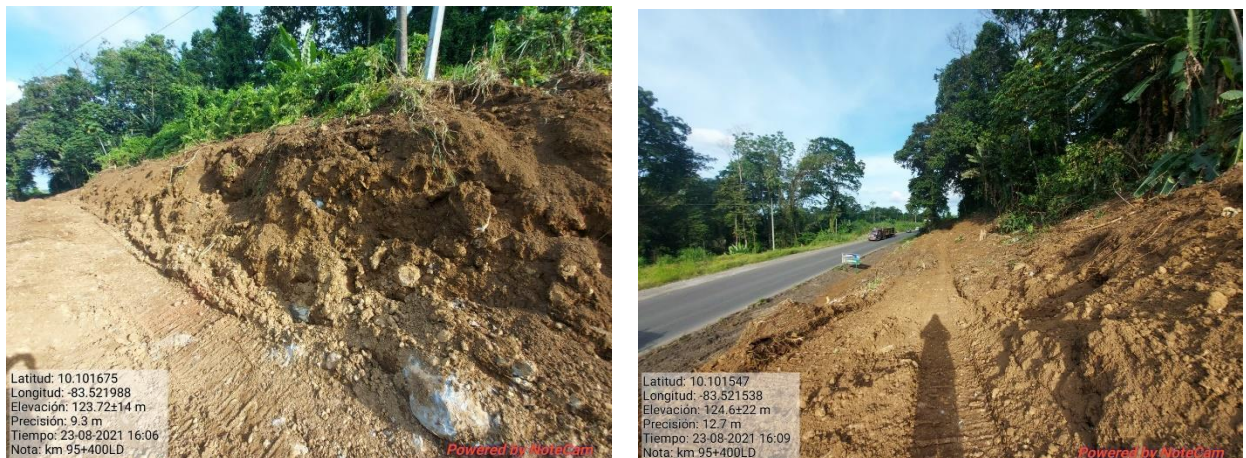
Figura 15. Inspección de talud km 95.
