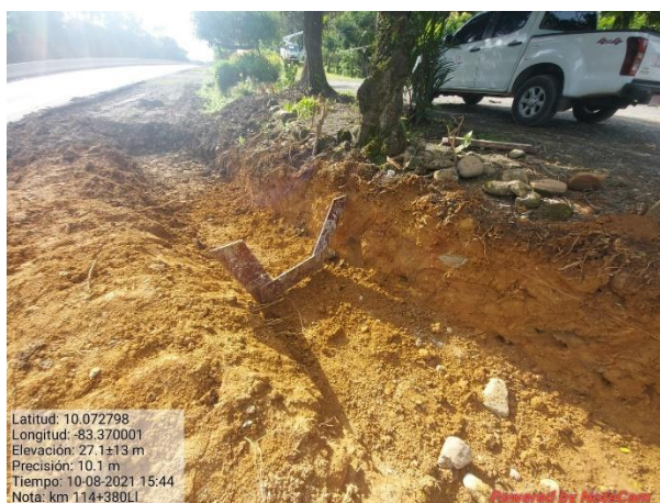
Figura 19. Zanqueo para construcción de cunetas.
