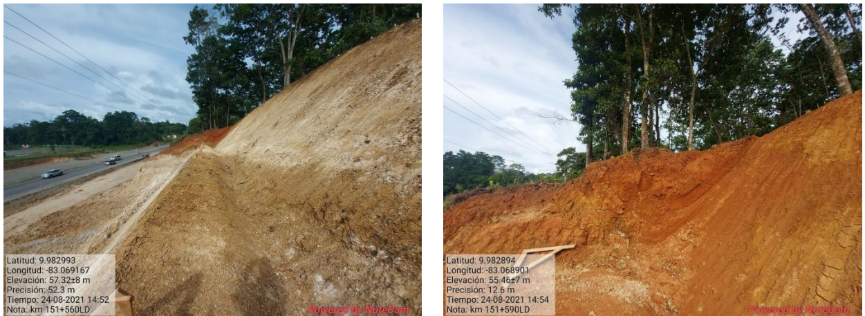
Figura 20. Excavación del talud, km 151.
