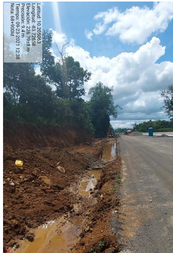
Figura 7. Km68+900 sector de construcción de desagües
