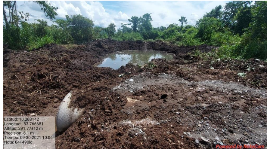
Figura 4. Inicia limpieza en terreno para PSV en área del Km 64+500.
