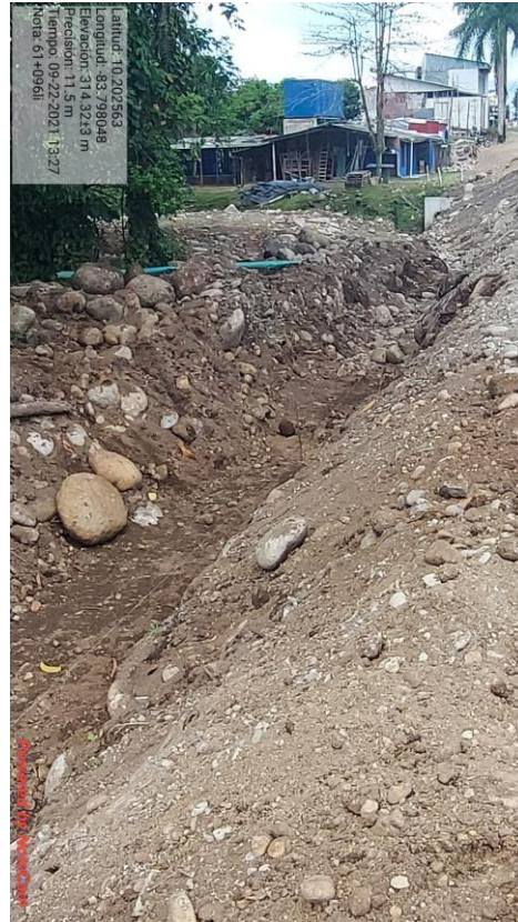
Figura 3. Trabajos en construcción de cunetas y desagües en km 61+096 LI.
