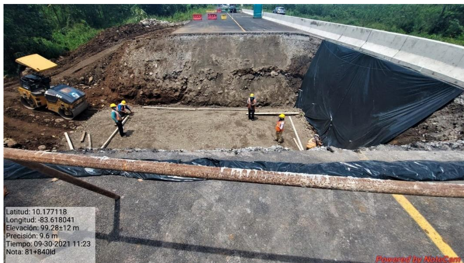
Figura 10. Km 81+840LD Se retoma construcción de paso de fauna
