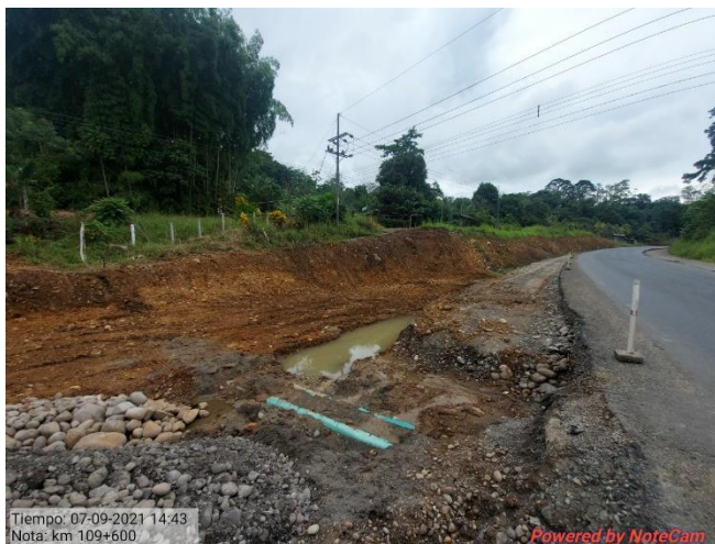
Figura 19. Excavación del talud km 109.
