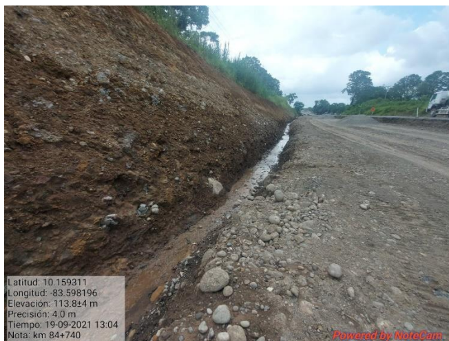
Figura 11. Revisión de zanqueo de talud.
