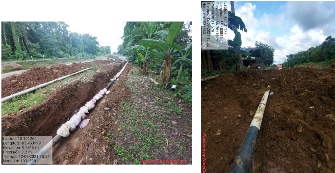
Figura 16. Trabajos de zanjeo en el km 103.
