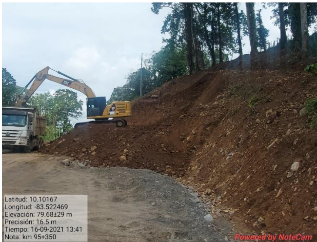
Figura 12. Excavación del talud km 95.
