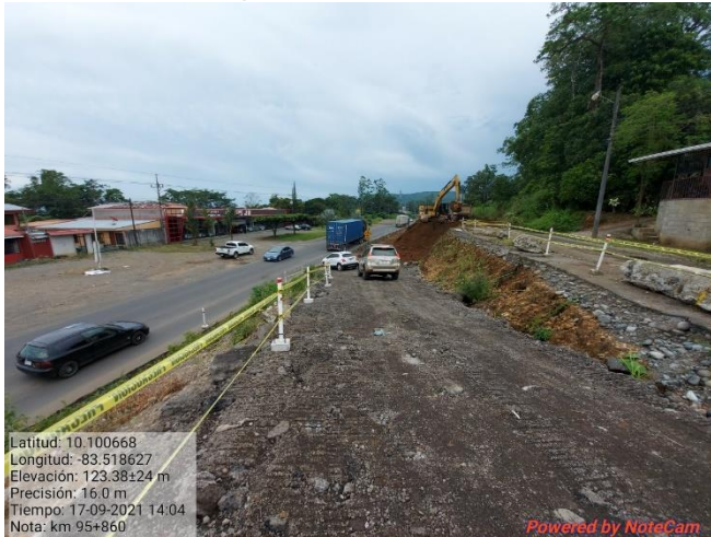
Figura 14. Excavación del talud km 95+850.
