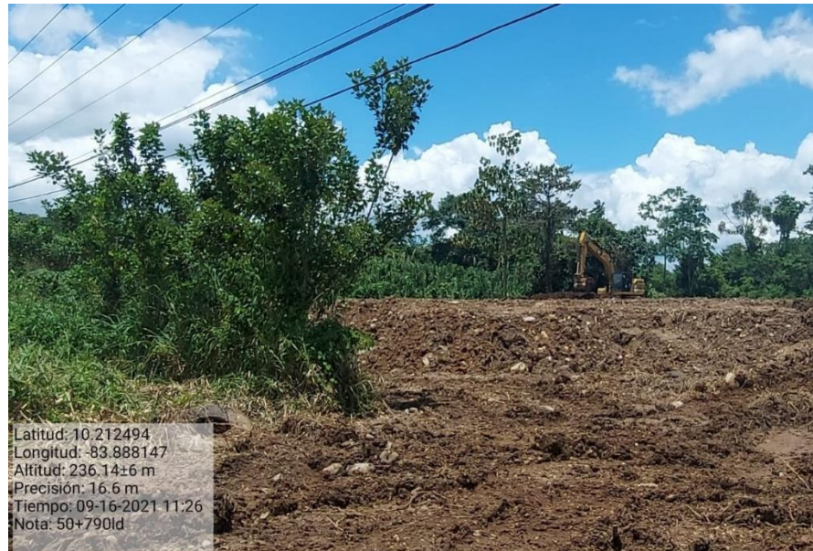
Figura 1. Supervisión en km 50+790LD Trabajos para cierre técnico Escombrera 50.
