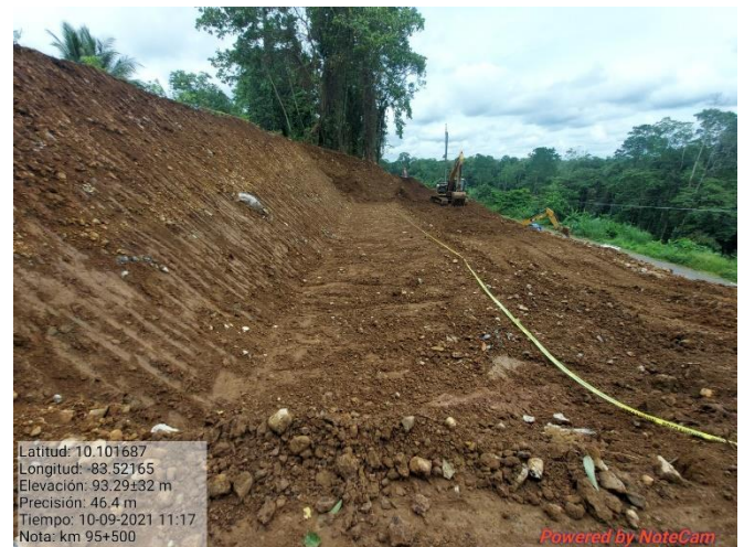
Figura 12. Excavación del talud km 95.
