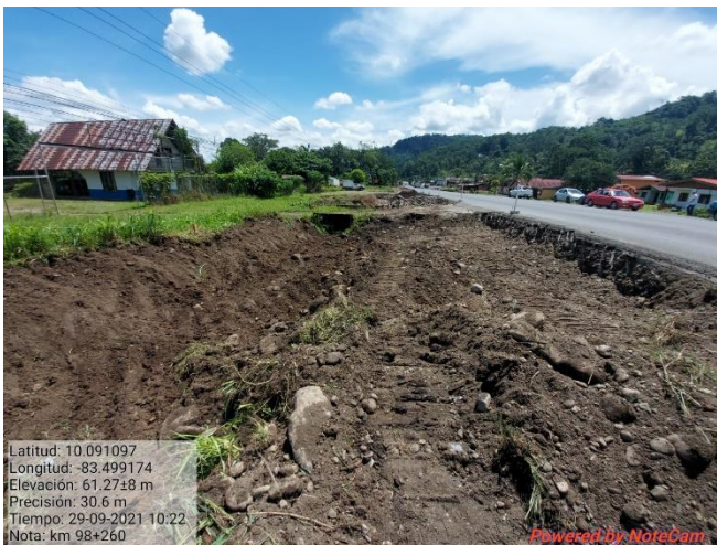
Figura 15. Excavación del talud km 109.
