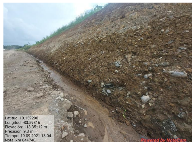
Figura 11. Revisión de zanqueo de talud.
