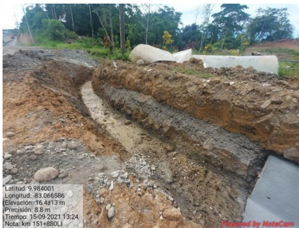
Figura 23. Zanjeo para cuneta del lado izquierdo, km 151.
