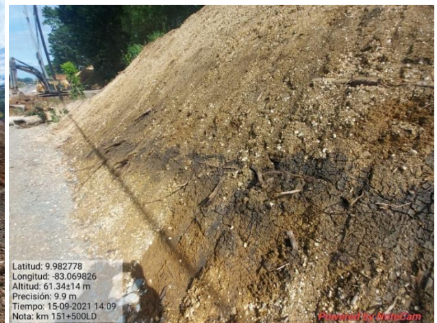
Figura 22. Excavación del talud, km 151.
