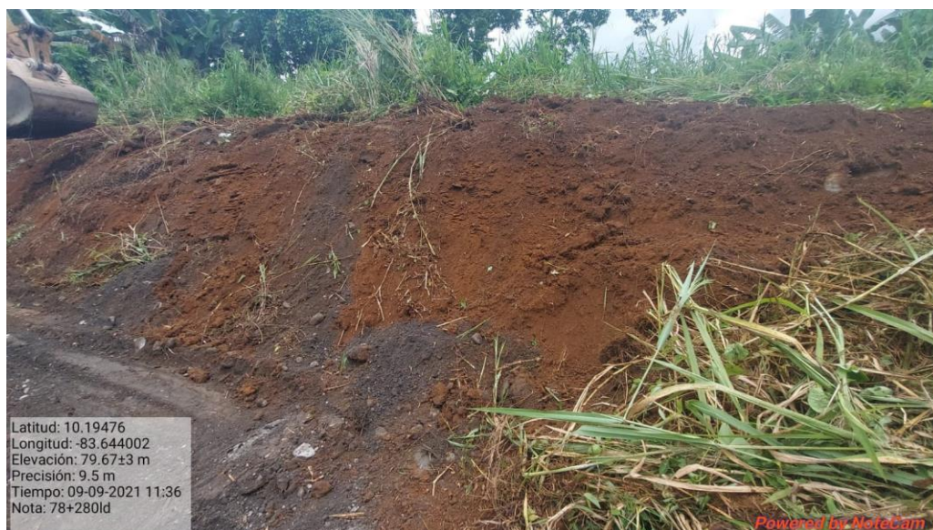
Figura 8. Trabajos de excavación km78+280LD
