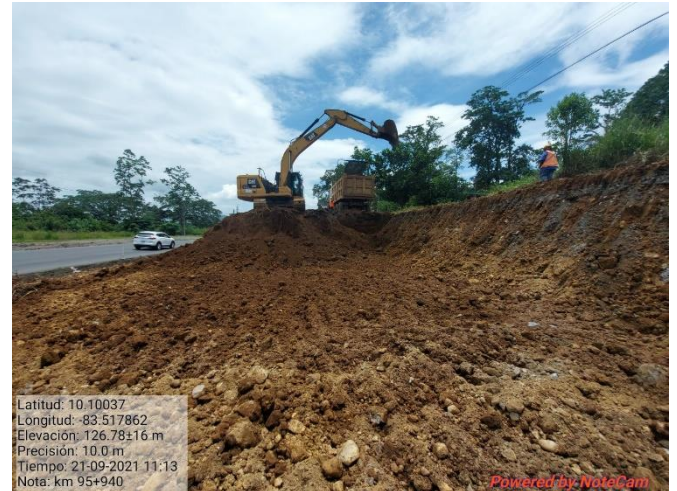
Figura 14. Excavación del talud km 95+850.
