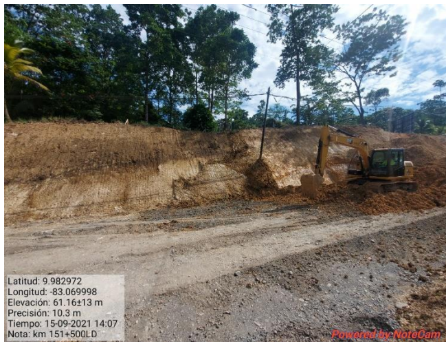
Figura 22. Excavación del talud, km 151.
