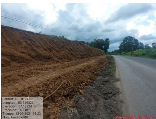
Figura 13. Limpieza de talud km 95+700.
