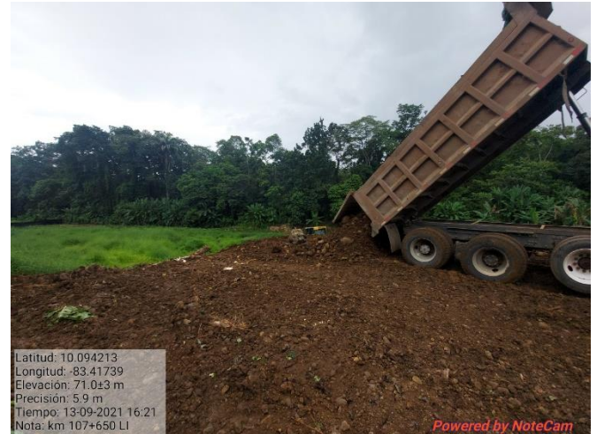
Figura 18. Apertura de escombrera km 107.
