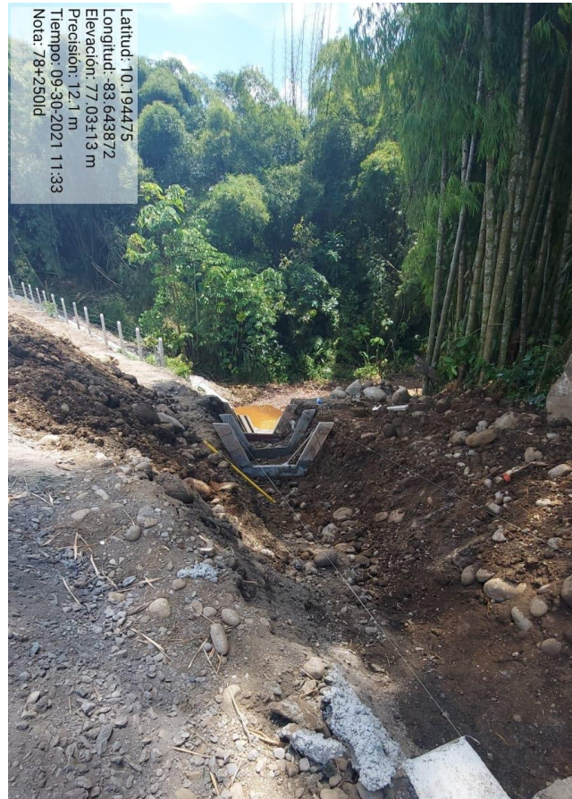
Figura 9. Km 78+250 LD construcción de desagüe y alcantarilla
