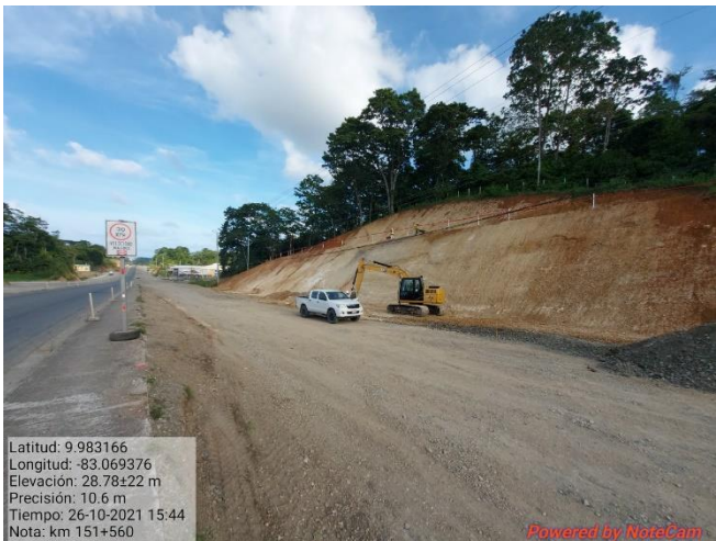
Figura 22. Excavación del talud, km 151.
