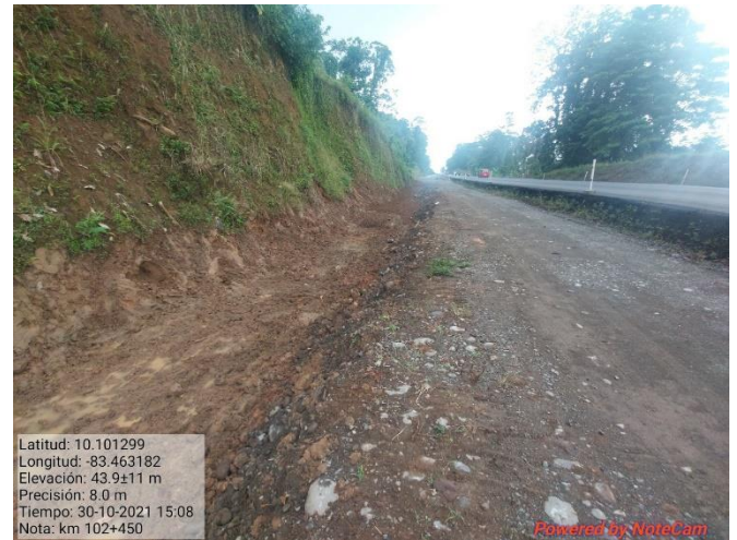
Figura 18. Conformación de taludes, km 102.
