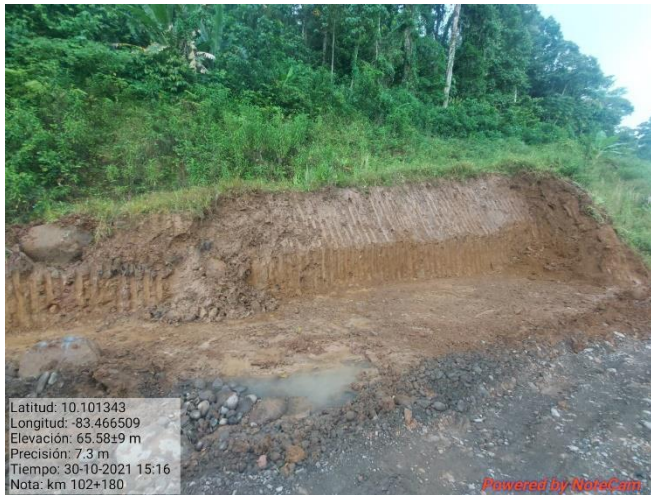
Figura 18. Conformación de taludes, km 102.
