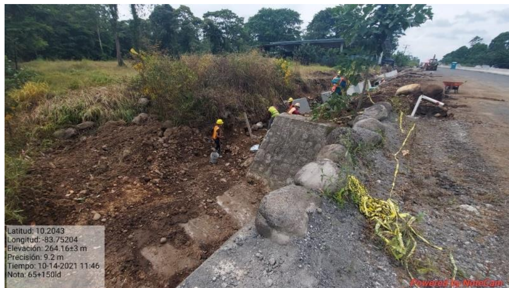
Figura 6. Se monitorean trabajos en canal de desagüe km 65+150LD
