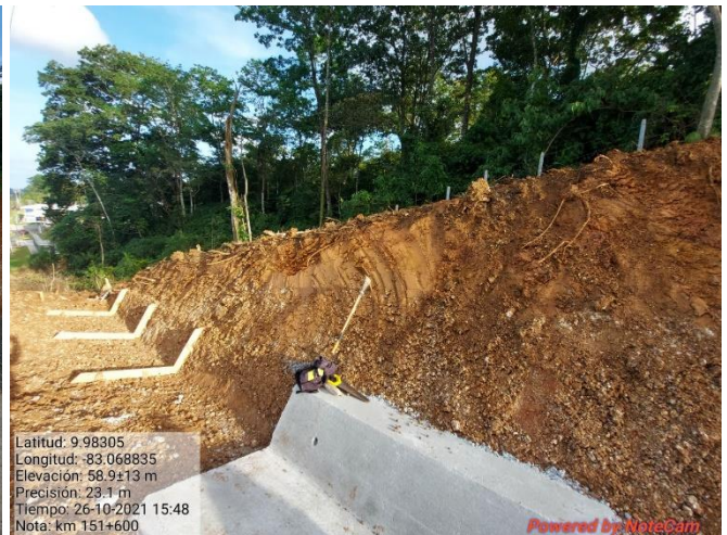
Figura 22. Excavación del talud, km 151.
