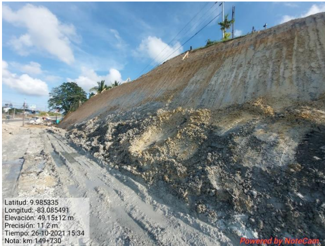
Figura 21. Excavación del talud, km 149.
