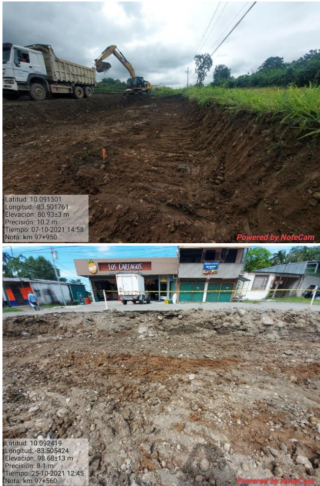
Figura 15. Excavación del derecho de vía, km 97.
