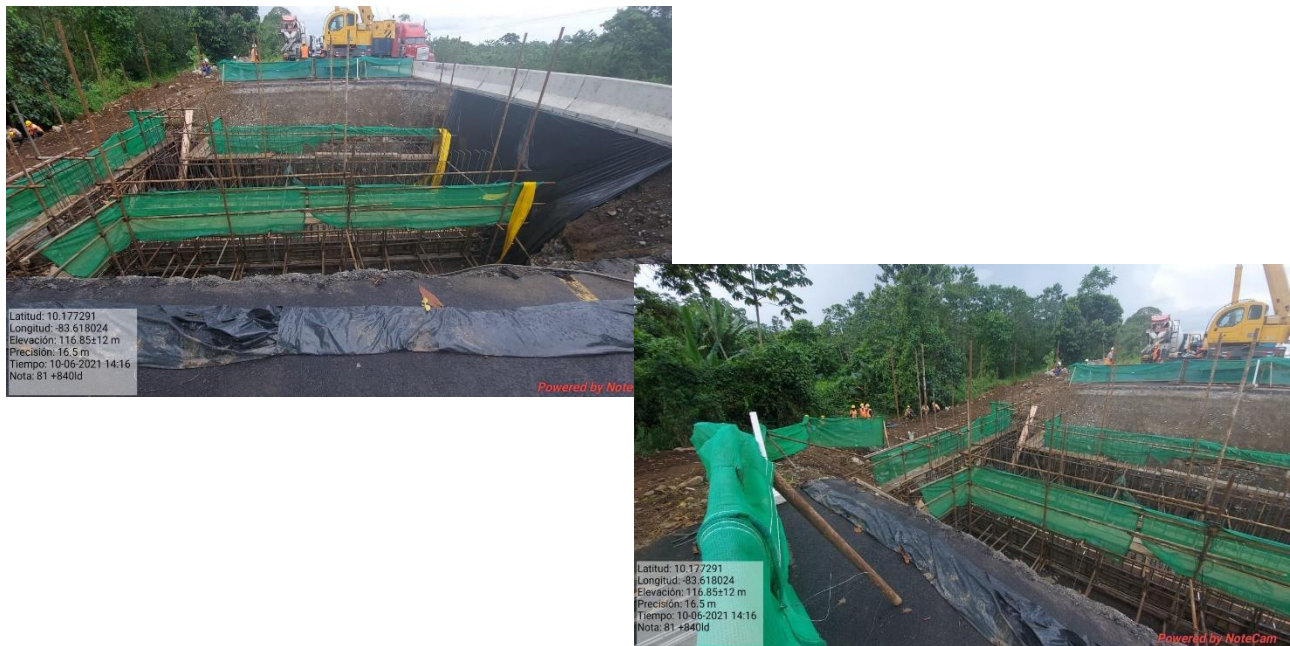
Figura 10. Área de construcción de paso de fauna km82+840LD
