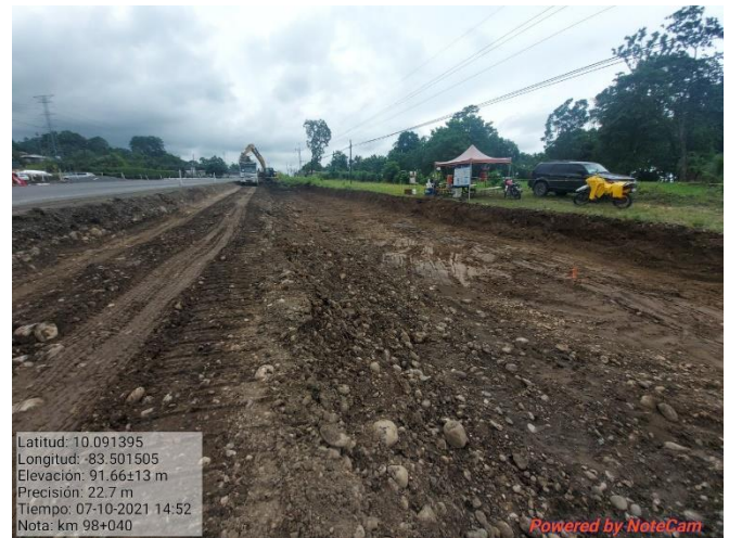
Figura 16. Excavación de la vía en el km 98.
