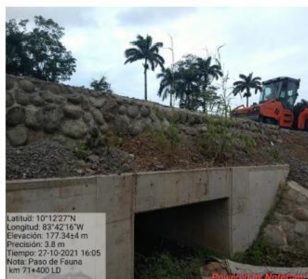
Margen izquierda de paso de fauna
