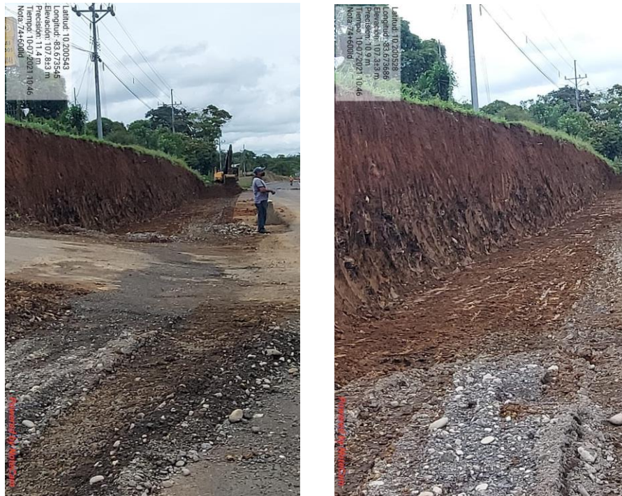
Figura 9. Se monitorean trabajos en talud
