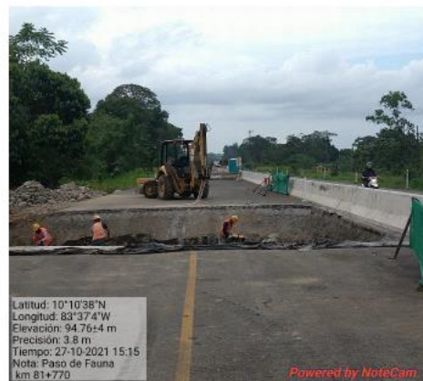
Zona de trabajo acceso paso de fauna 81+770
