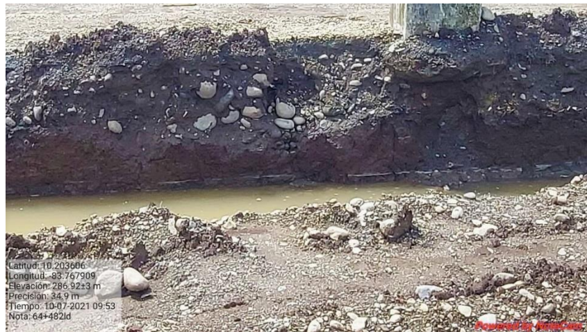
Figura 4. Inicia limpieza en terreno para PSV en área del Km 64+481LD
