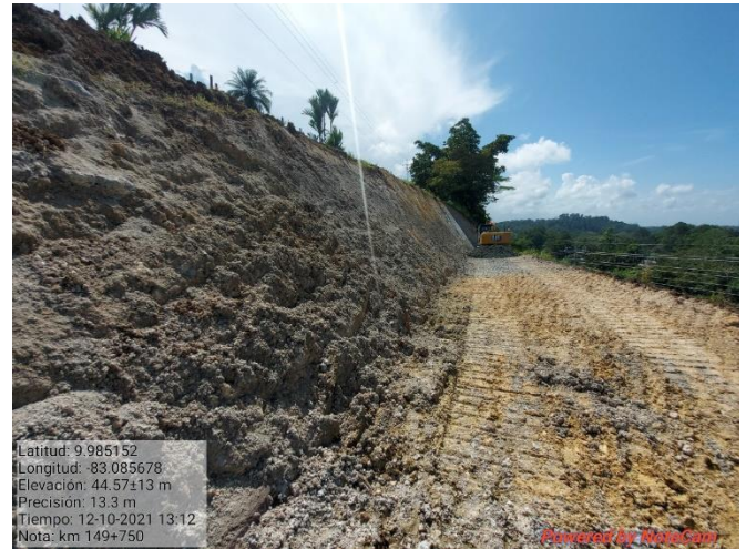
Figura 21. Excavación del talud, km 149.
