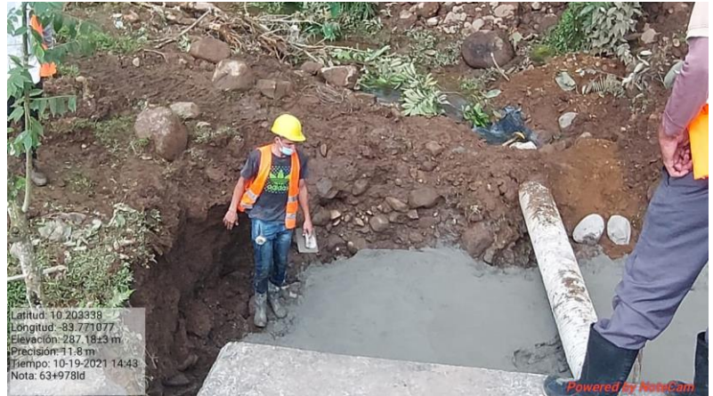
Figura 3. Trabajos en construcción de cunetas y desagües en km63 LD
