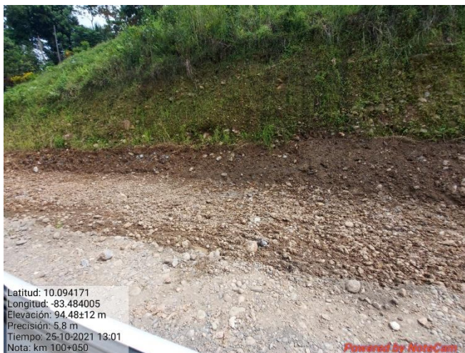
Figura 17. Conformación de taludes, km 100.
