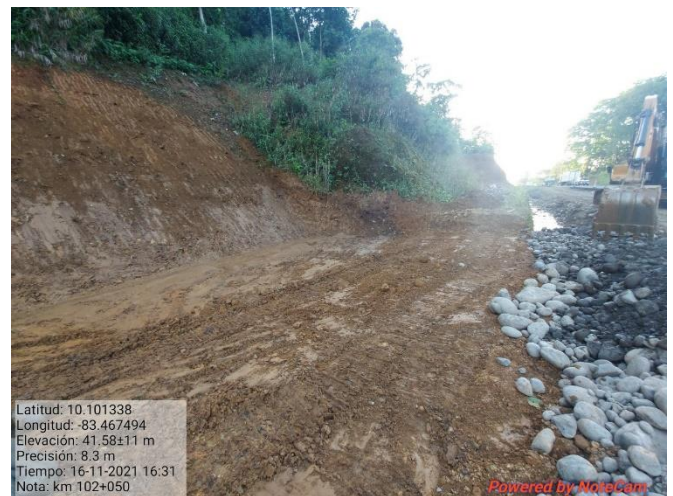
Figura 15. Excavación del talud, km 102.
