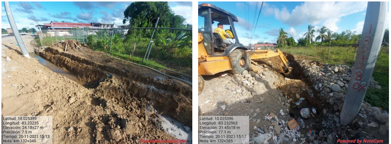
Figura 16. Excavación de zanjeo para cunetas, km 132.
