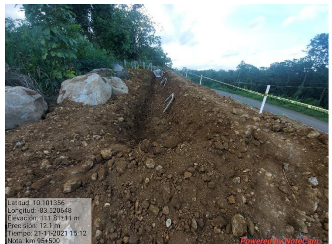
Figura 13. Excavación del talud y zanjo para cunetas en el km 95.
