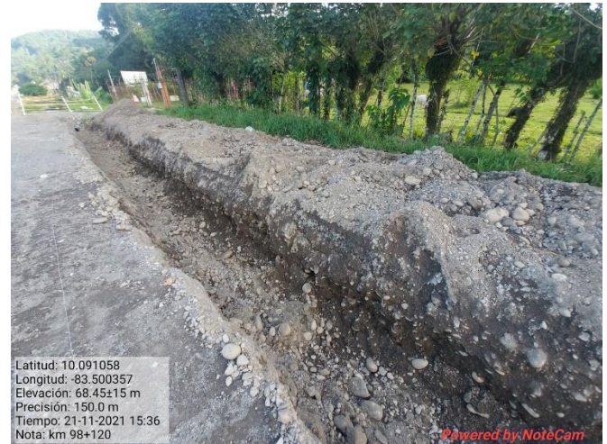
Figura 14. Excavación para cunetas, km 98.
