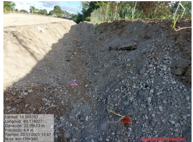
Figura 17. Excavación de zanjeo para cunetas, km 139.
