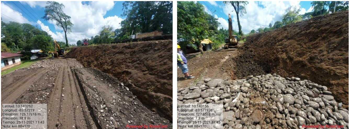
Figura 10. Limpieza del talud km 88.
