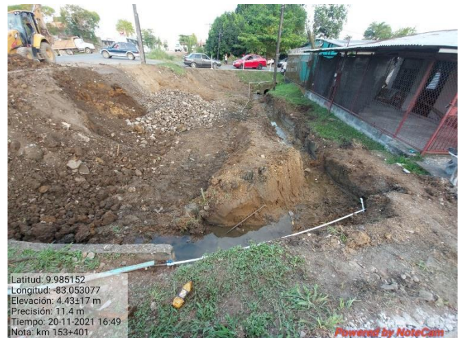
Figura 18. Excavación de la vía, km 153.
