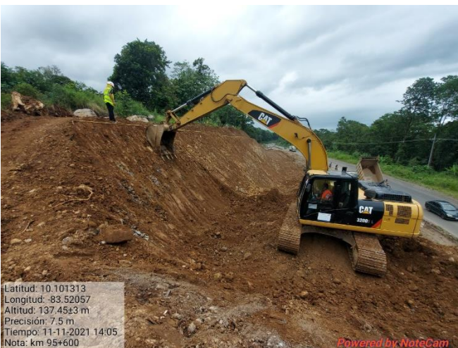
Figura 13. Excavación del talud y zanjo para cunetas en el km 95.
