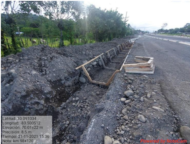
Figura 14. Excavación para cunetas, km 98.
