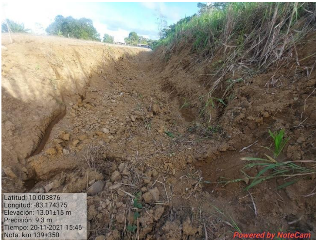
Figura 17. Excavación de zanjeo para cunetas, km 139.
