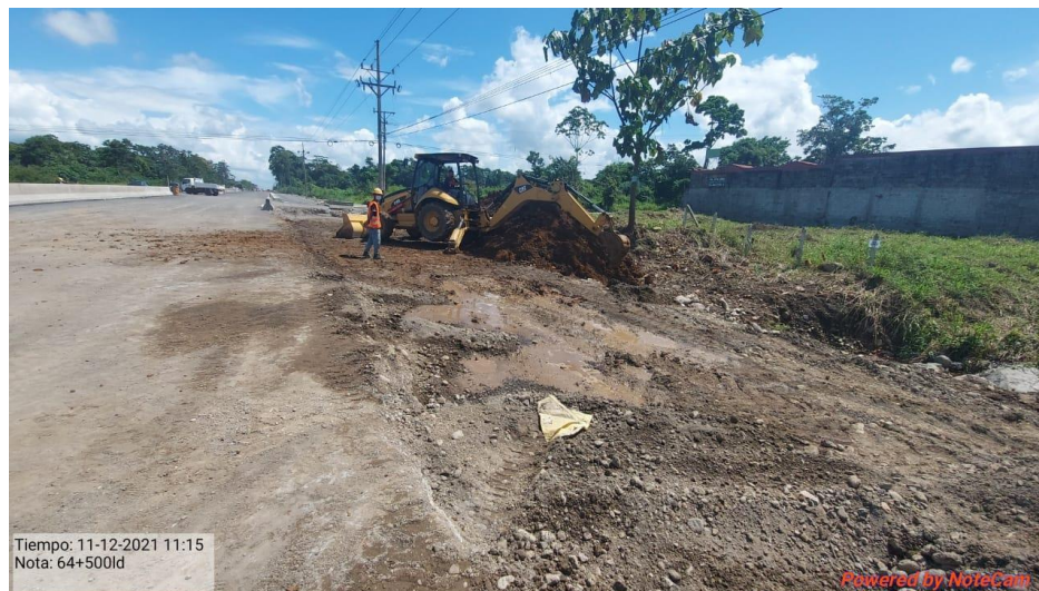
Figura 3. Monitoreo en excavación sin evidencia arqueológica
