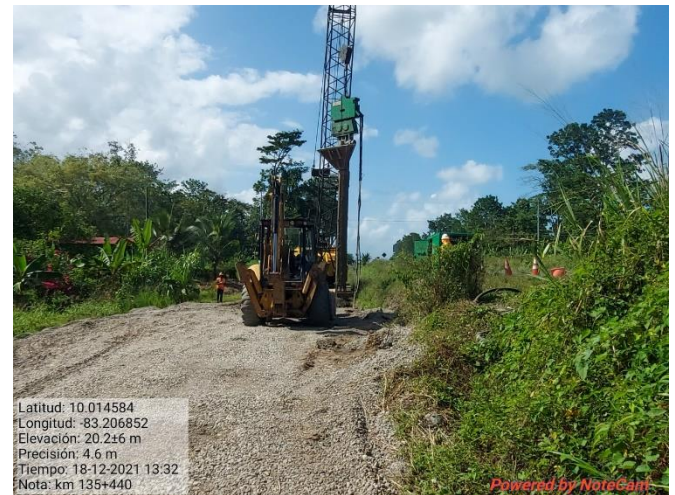
Figura 22. Excavación tipo slot drain, km 135.
