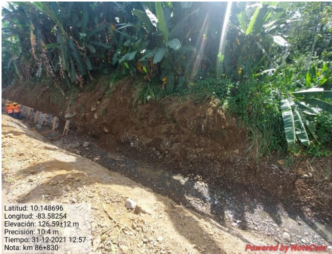
Figura 12. Excavación para alcantarilla km 86.
