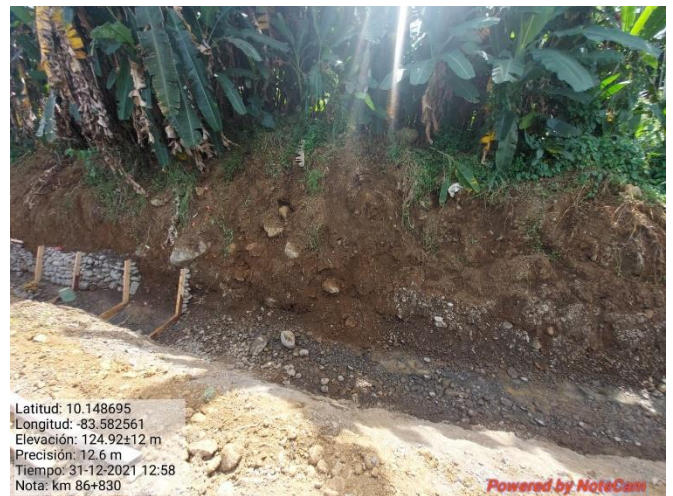
Figura 12. Excavación para alcantarilla km 86.
