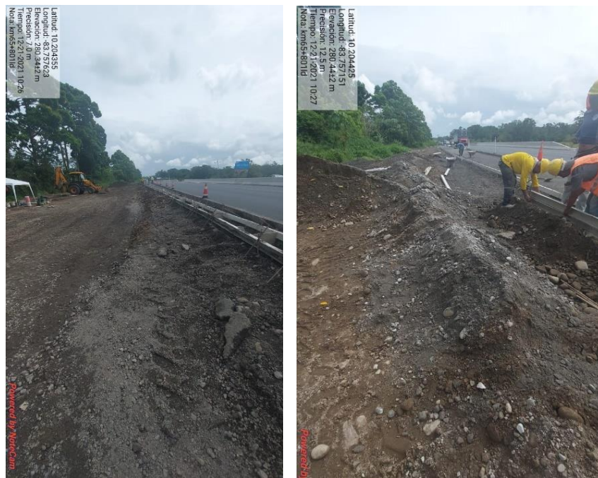
Figura 4. Seguimiento a trabajos en Km 65+800
