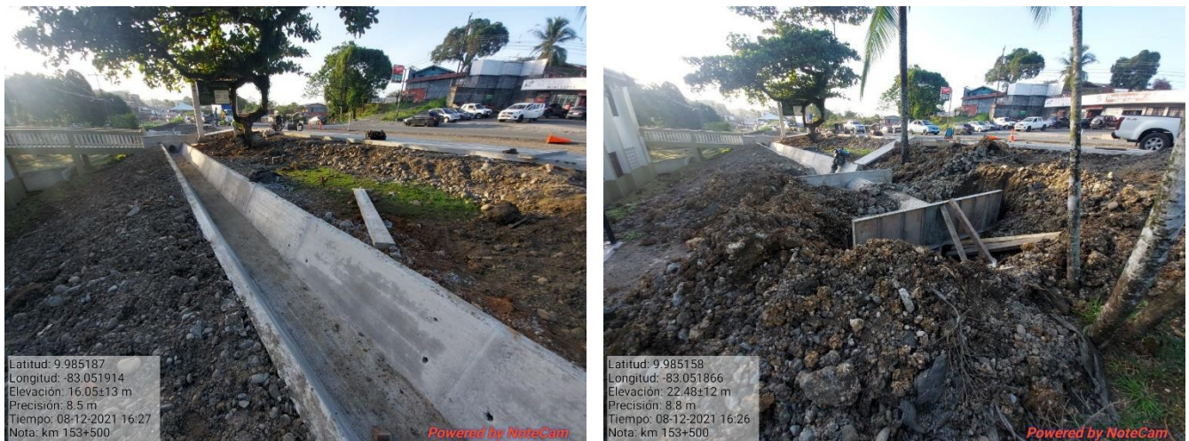
Figura 24. Excavación para cunetas, km 153+500.
