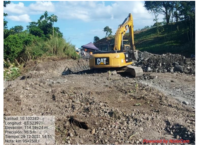
Figura 16. Limpieza y excavación de la vía, km 95+000 a 95+100, lado izquierdo.
