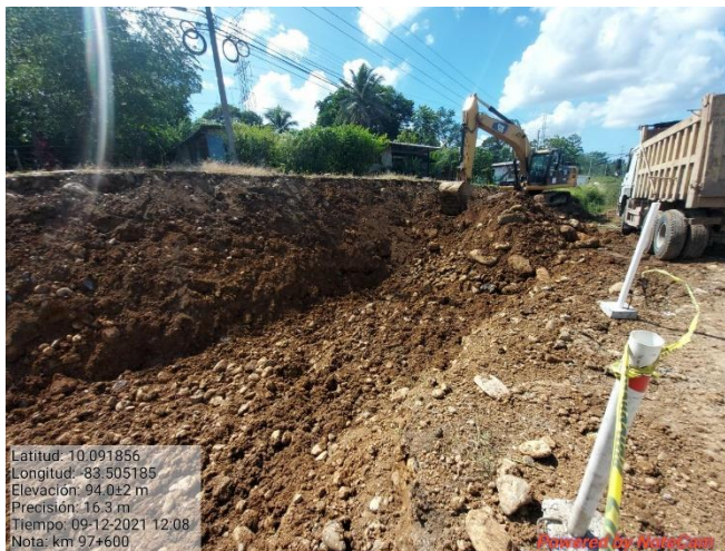
Figura 17. Excavación de la vía en el km 97+600 al 650, lado derecho.
