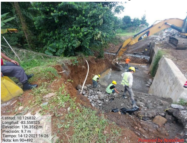
Figura 13. Limpieza de alcantarilla, km 90.
