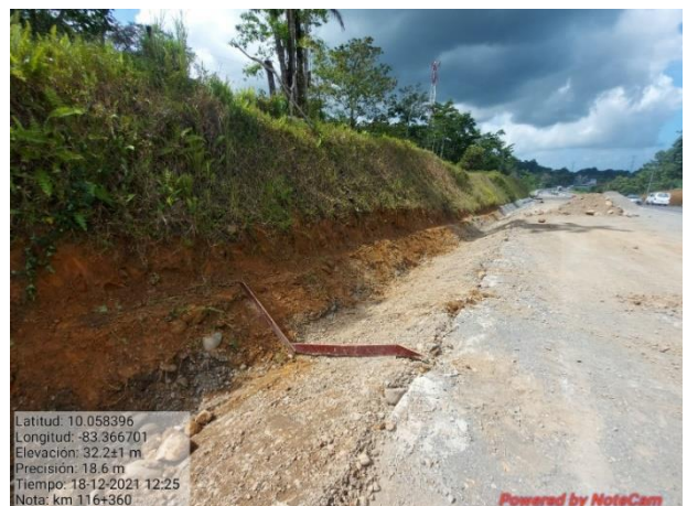
Figura 21. Excavación para cunetas, km 116.
