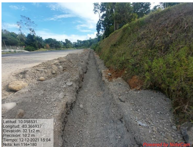
Figura 21. Excavación para cunetas, km 116.
