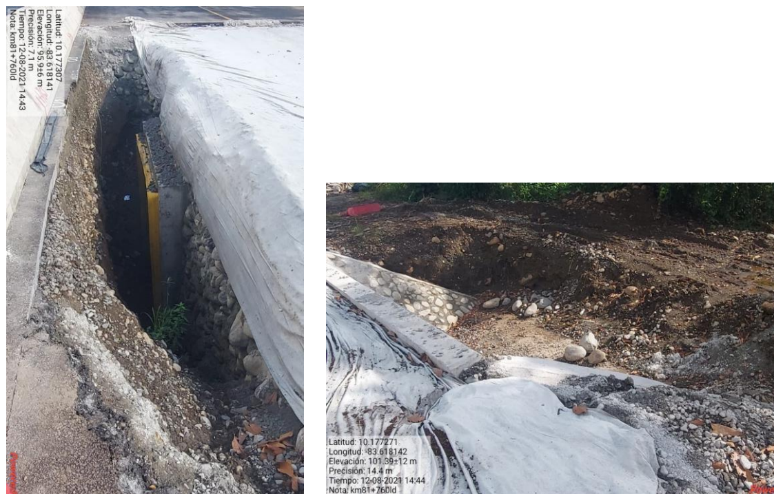
Figura 8. Se da seguimiento a la construcción de paso de fauna
