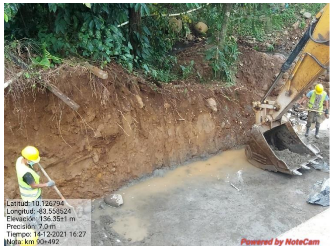
Figura 13. Limpieza de alcantarilla, km 90.
