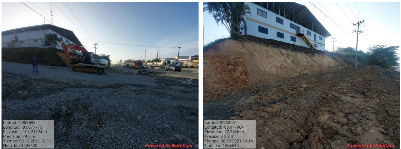
Figura 23. Excavación del talud, km 150.
