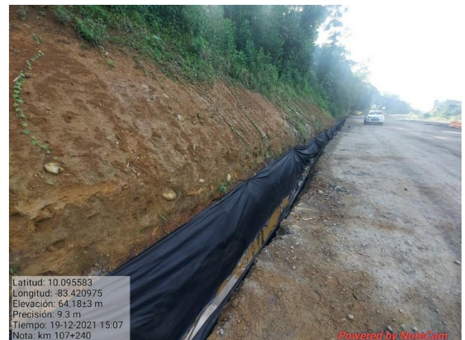
Figura 20. Excavación para cuneta revestida, km 107.
