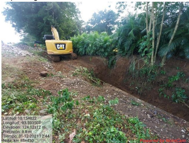
Figura 11. Limpieza de alcantarilla km 85.
