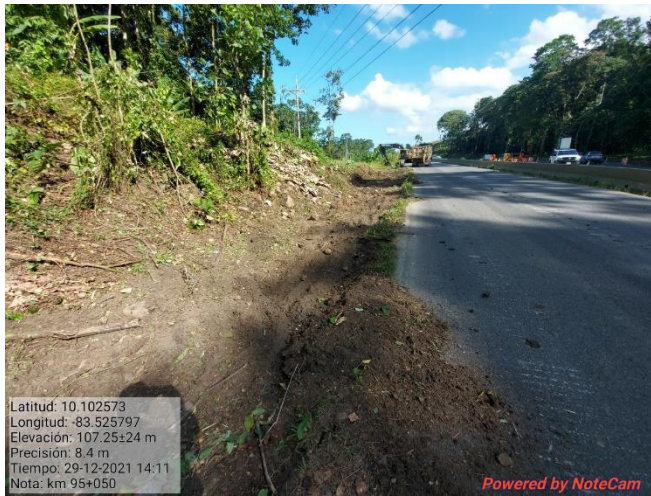
Figura 16. Limpieza y excavación de la vía, km 95+000 a 95+100, lado izquierdo.
