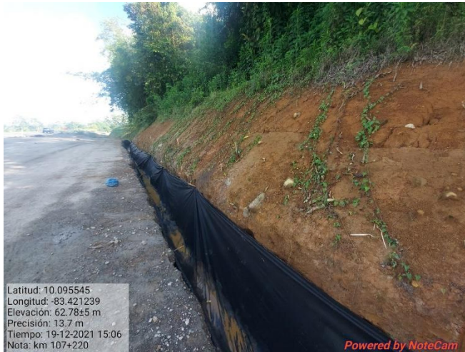
Figura 20. Excavación para cuneta revestida, km 107.
