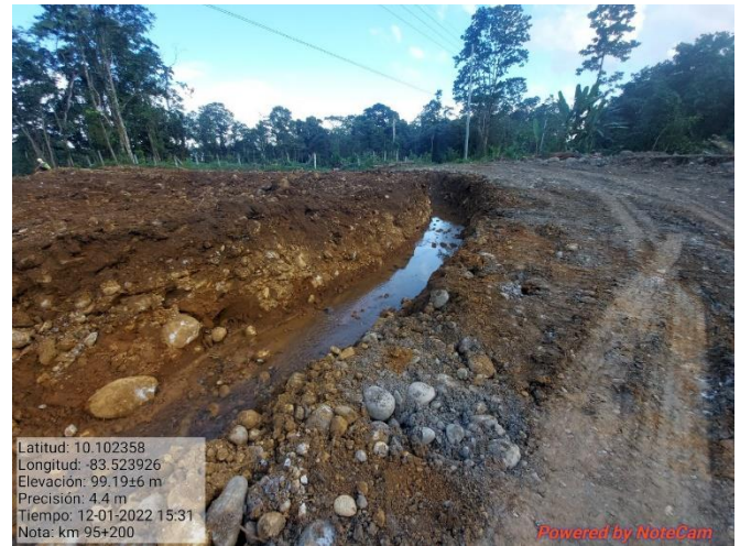
Figura 13. Limpieza del talud, km 90+900.
