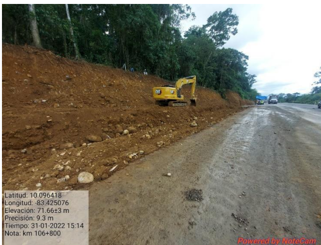
Figura 16. Excavación del talud, km 106.
