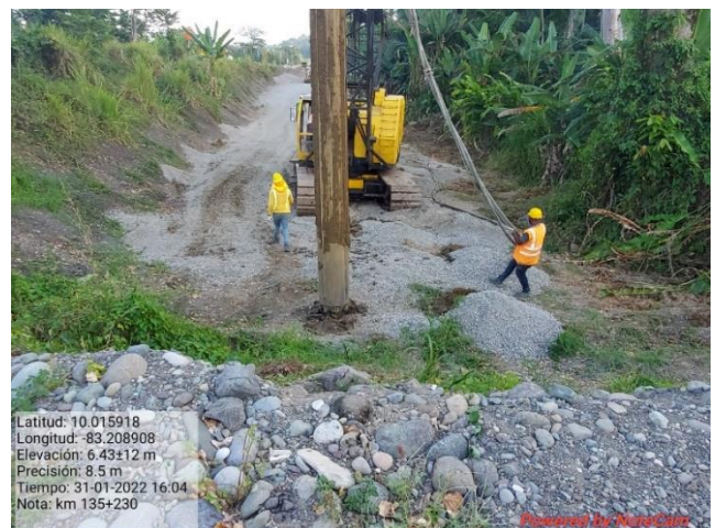
Figura 20. Excavación tipo slot drain, km 135.
