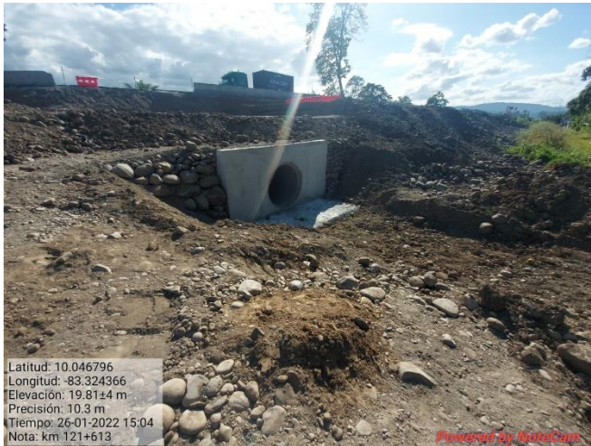
Figura 19. Colocación de paso de fauna, km 121.
