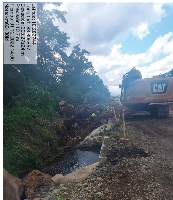
Figura 2. Monitoreo en área de construcción de
