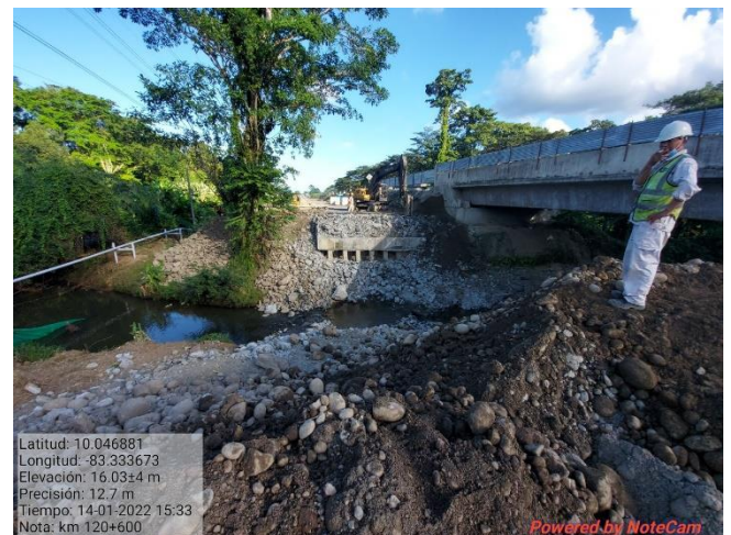
Figura 18. Limpieza para alcantarillas, km 120.
