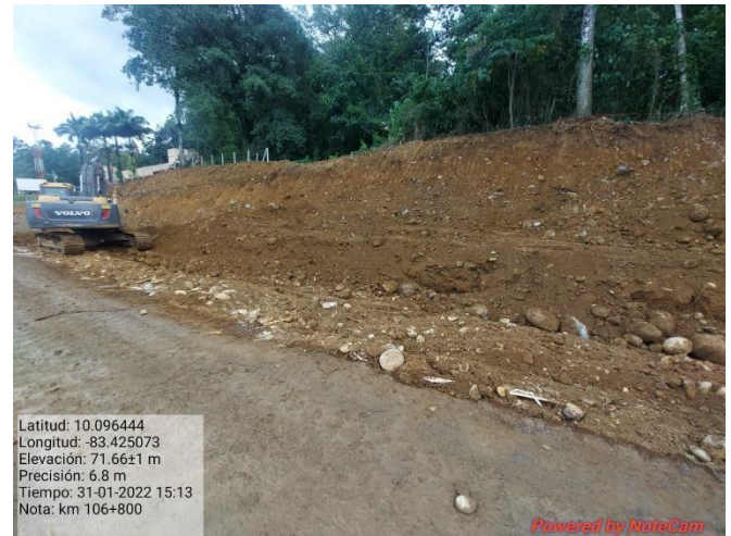
Figura 16. Excavación del talud, km 106.
