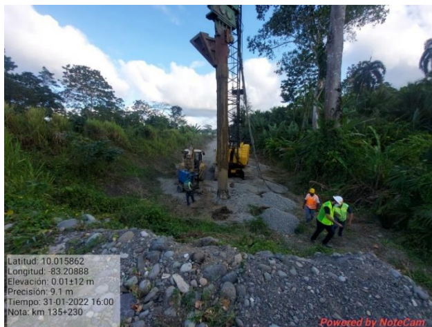
Figura 20. Excavación tipo slot drain, km 135.
