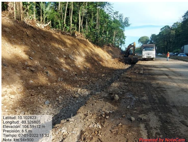
Figura 12. Excavación del Talud, km 94.
