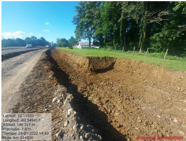
Figura 11. Excavación del talud km 86.
