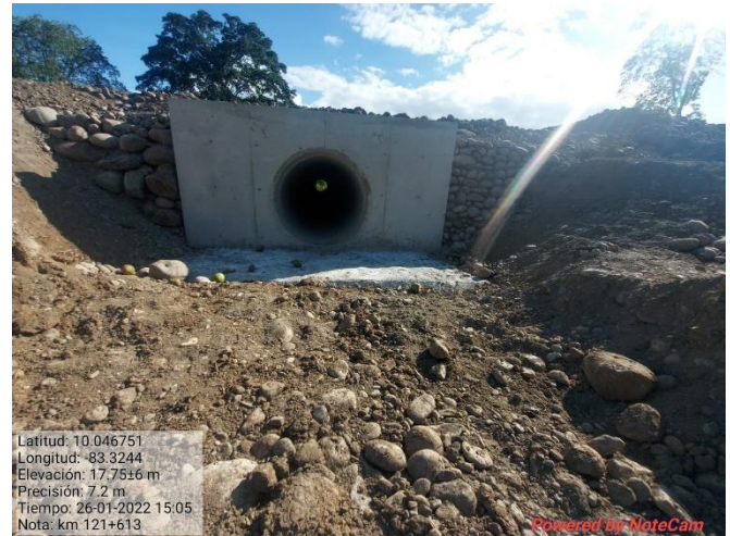
Figura 19. Colocación de paso de fauna, km 121.
