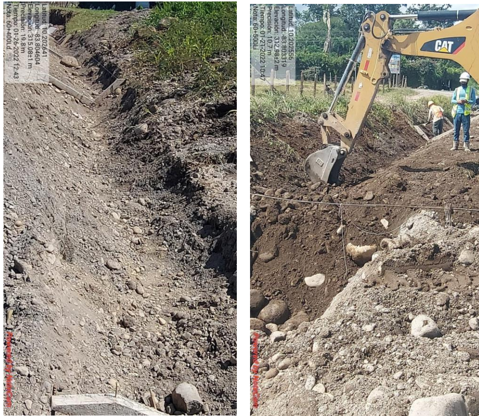
Figura 3. Observación en zona de construcción de desagüe y
