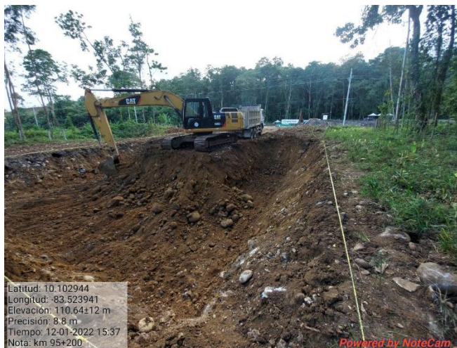
Figura 14. Excavación de acceso a PSV, km 95.
