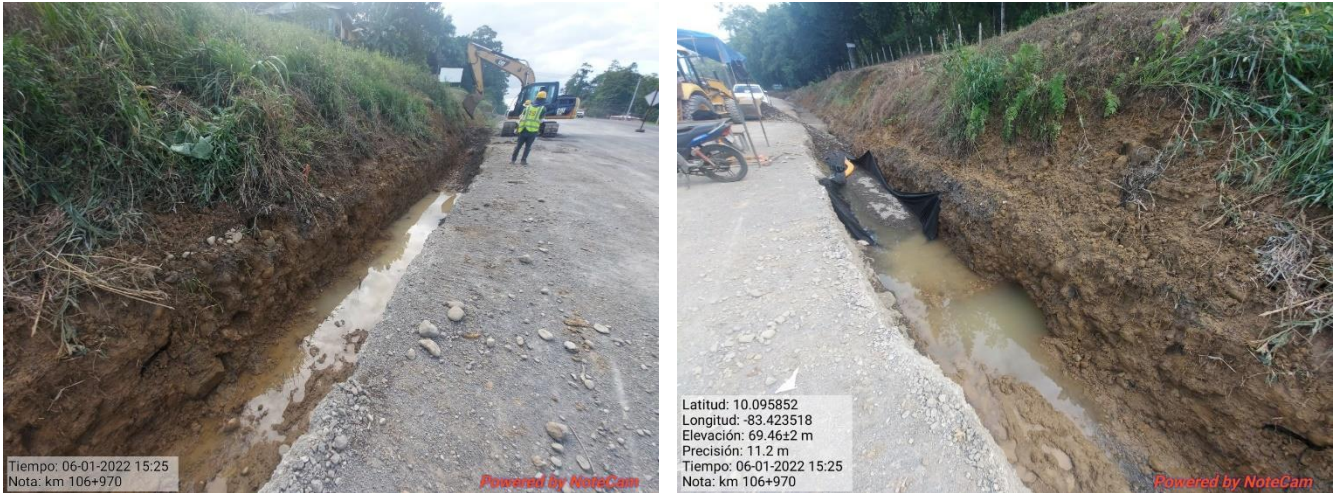
Figura 17. Excavación para cunetas, km 106.
