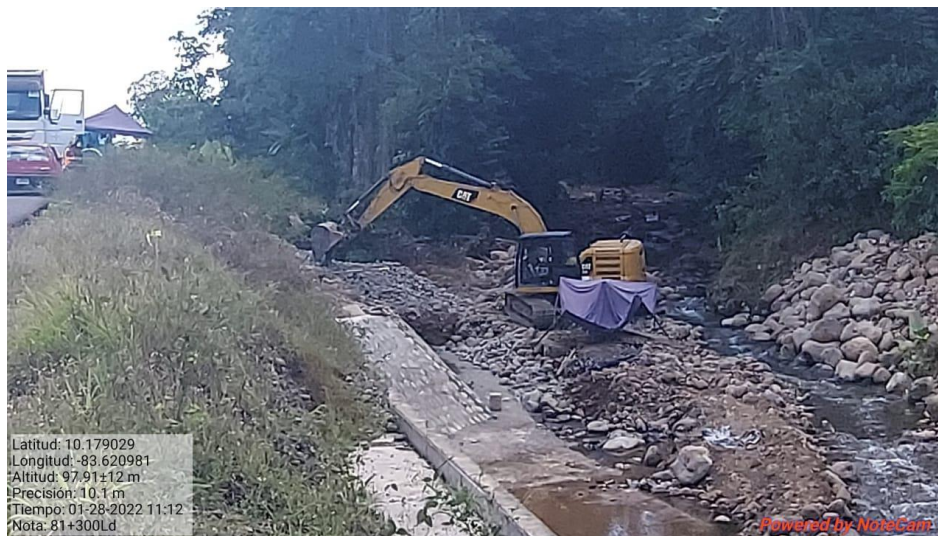
Figura 7. Se inspeccionó esta zona del km 81
