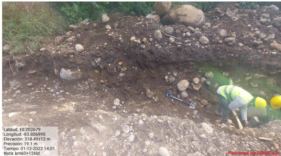
Figura 1. Se inspecciona zona de trabajo, no se observó evidencia
