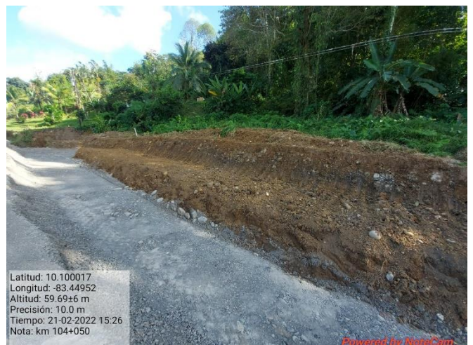
Figura 14. Excavación para cunetas, km 104.
