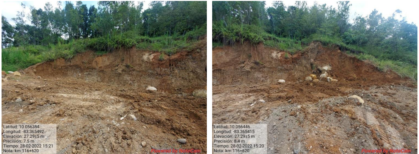
Figura 16. Limpieza del talud, km 116.
