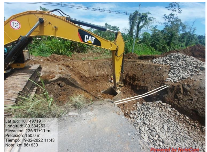
Figura 7. Conformación de paso de fauna km 86.
