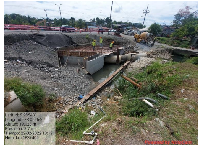
Figura 20. Construcción de alcantarilla, km 153.
