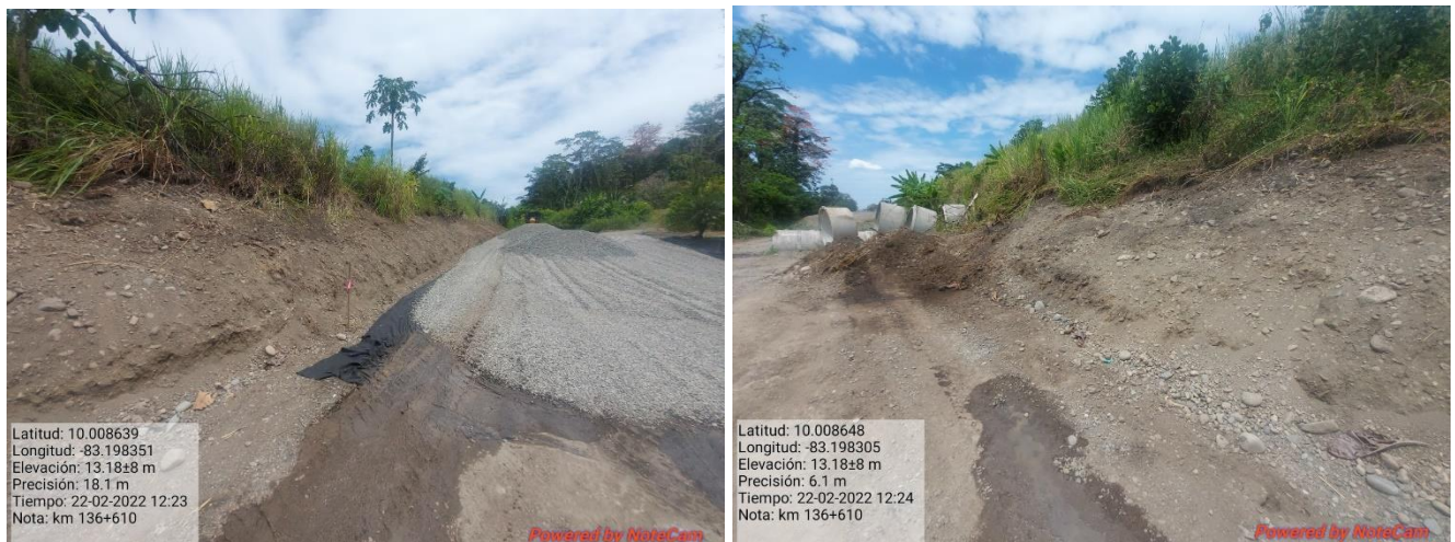
Figura 18. Limpieza del talud, km 136.
