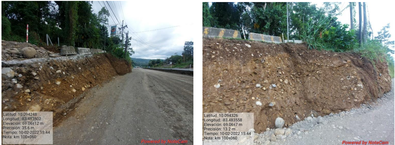
Figura 11. Excavación del talud, km 101+060.
