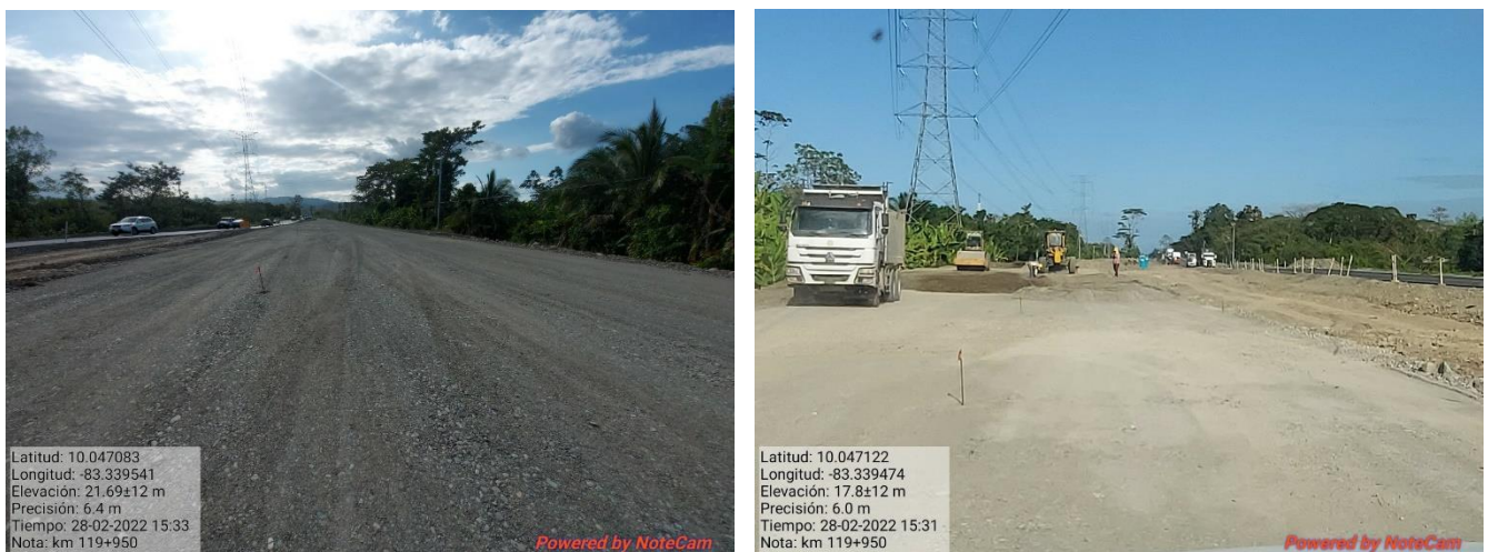
Figura 17. Rehabilitación de vía antigua, km 119.
