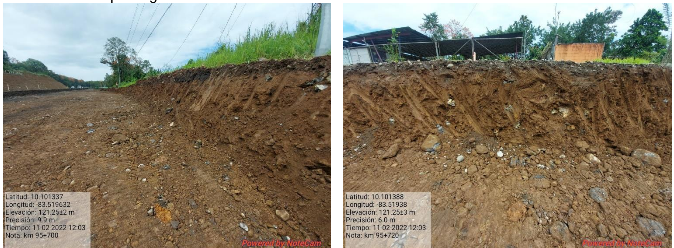
Figura 10. Excavación de la vía, km 95.
