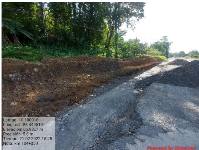
Figura 14. Excavación para cunetas, km 104.
