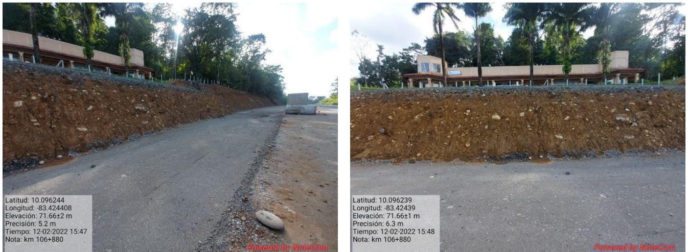
Figura 15. Excavación del talud, km 106.
