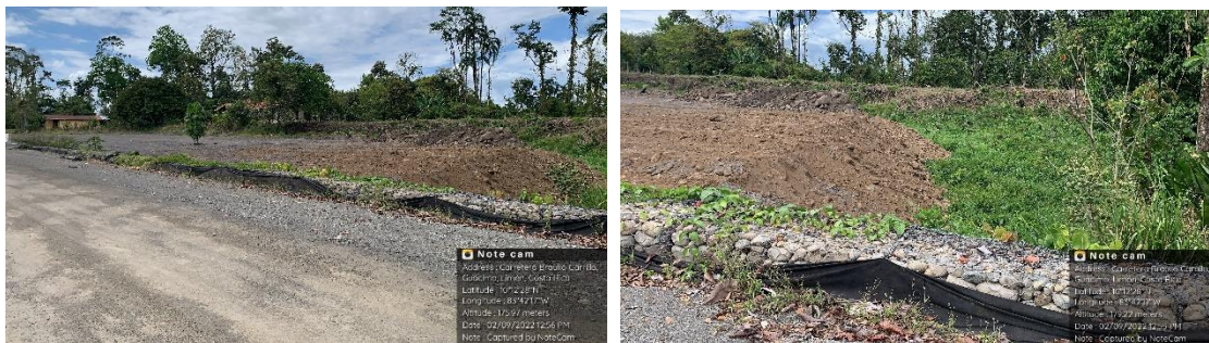
Fotografías 1 y 2: Relleno que realiza CHEC cerca de la escombrera k71.
