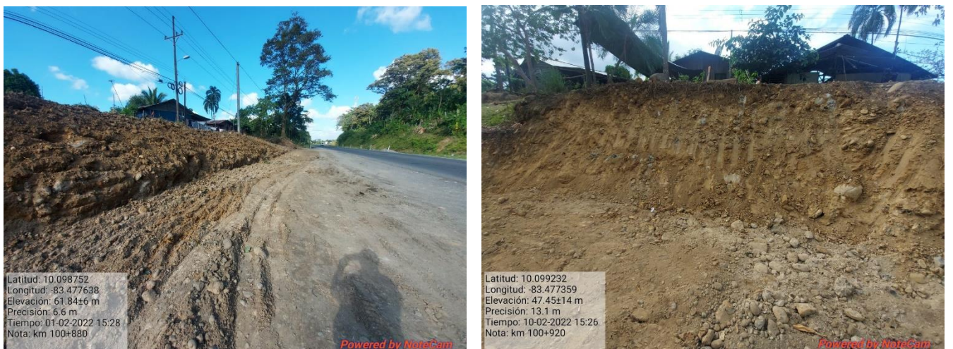
Figura 12. Excavación de la vía, km 100+800, lado izquierdo.
