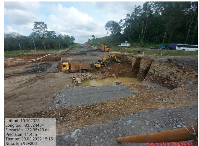
Figura 13. Conformación del PSV, km 95.
