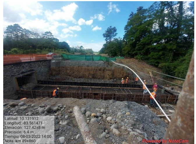
Figura 11. Construcción de alcantarilla para paso de fauna km 89.
