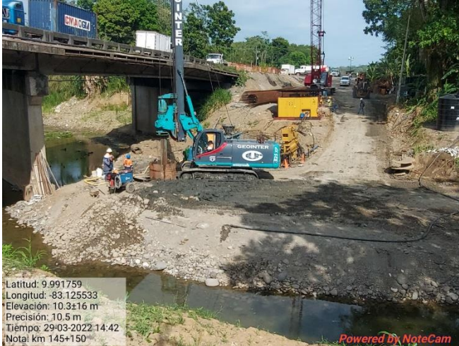
Figura 19. Perforación de pilotes, km 145
