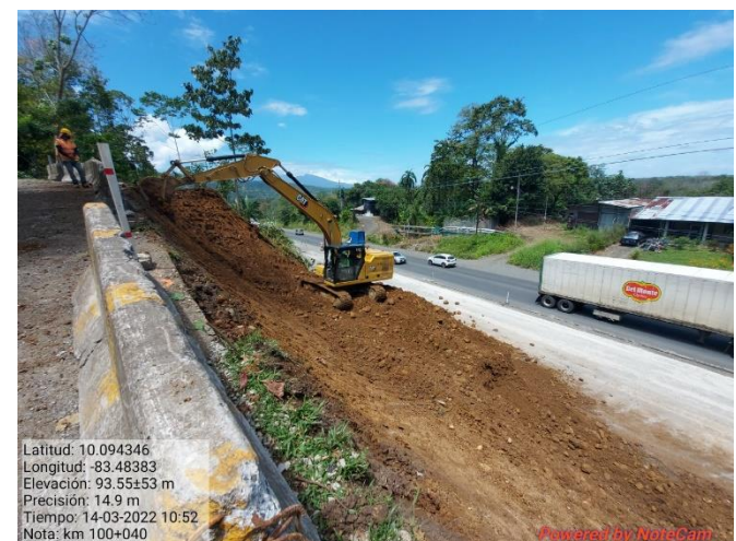
Figura 14. Excavación del talud, km 101.
