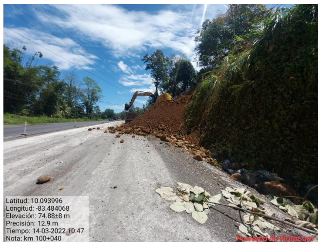
Figura 14. Excavación del talud, km 101.
