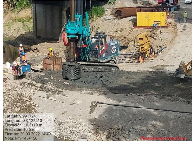
Figura 19. Perforación de pilotes, km 145
