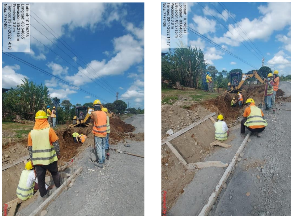
Figura 9. Monitoreo en construcción de cuneta km 77+740LI.
