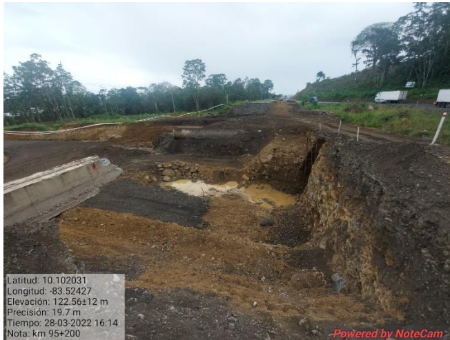
Figura 13. Conformación del PSV, km 95.
