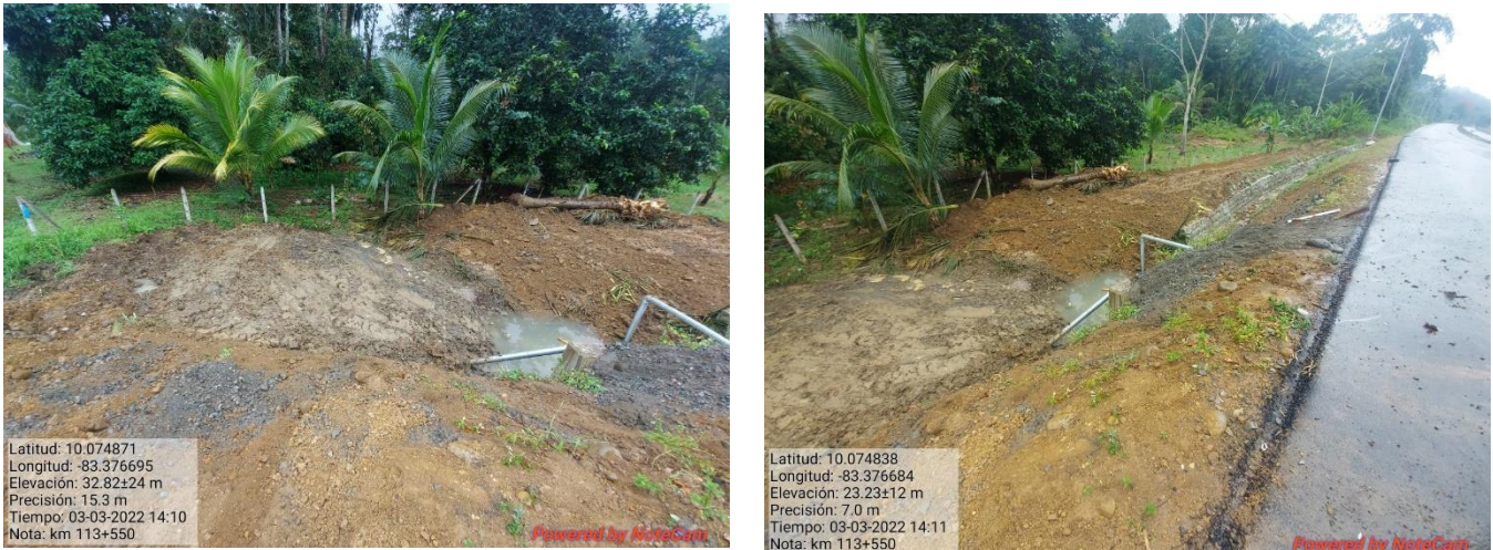
Figura 17. Limpieza del talud, km 113.
