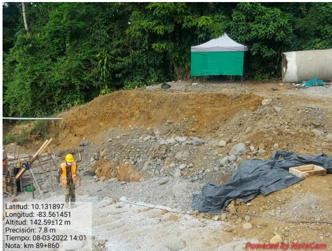
Figura 11. Construcción de alcantarilla para paso de fauna km 89.
