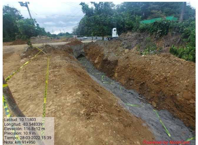
Figura 12. Zanjeo para cambio de servicios públicos, km 91.
