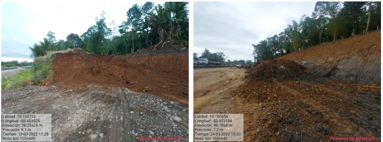
Figura 16. Excavación de la vía, km 100+800, lado izquierdo.
