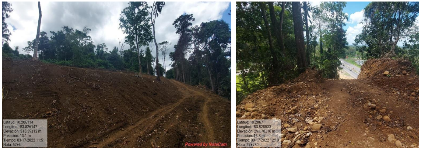
Figura 7. Limpieza de montaña en km 57/58
