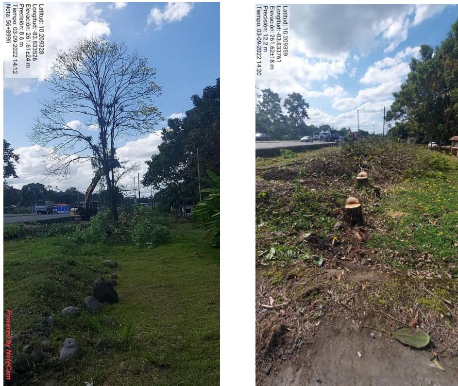
Figura 6. Corta de árboles km 56+889LI y revisión de área
