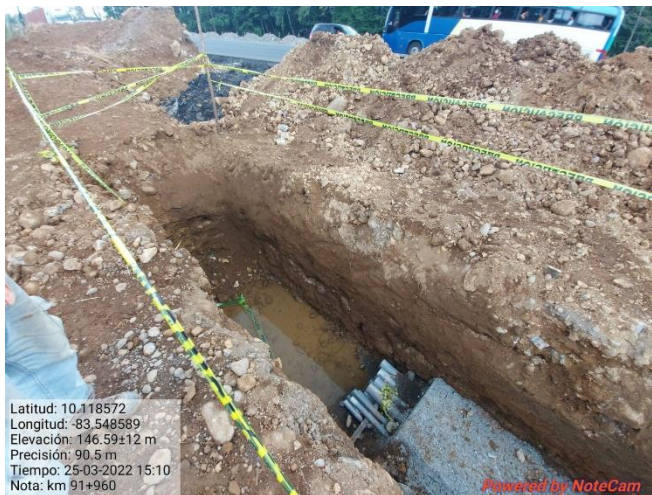
Figura 12. Zanjeo para cambio de servicios públicos, km 91.
