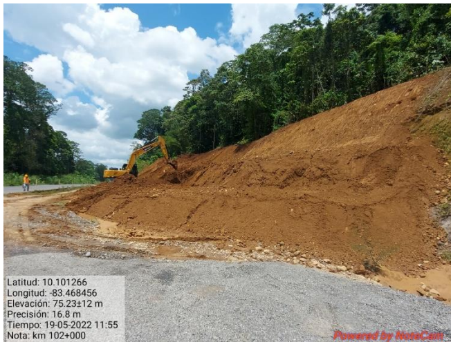
Figura 14. Excavación de taludes, km 102.
