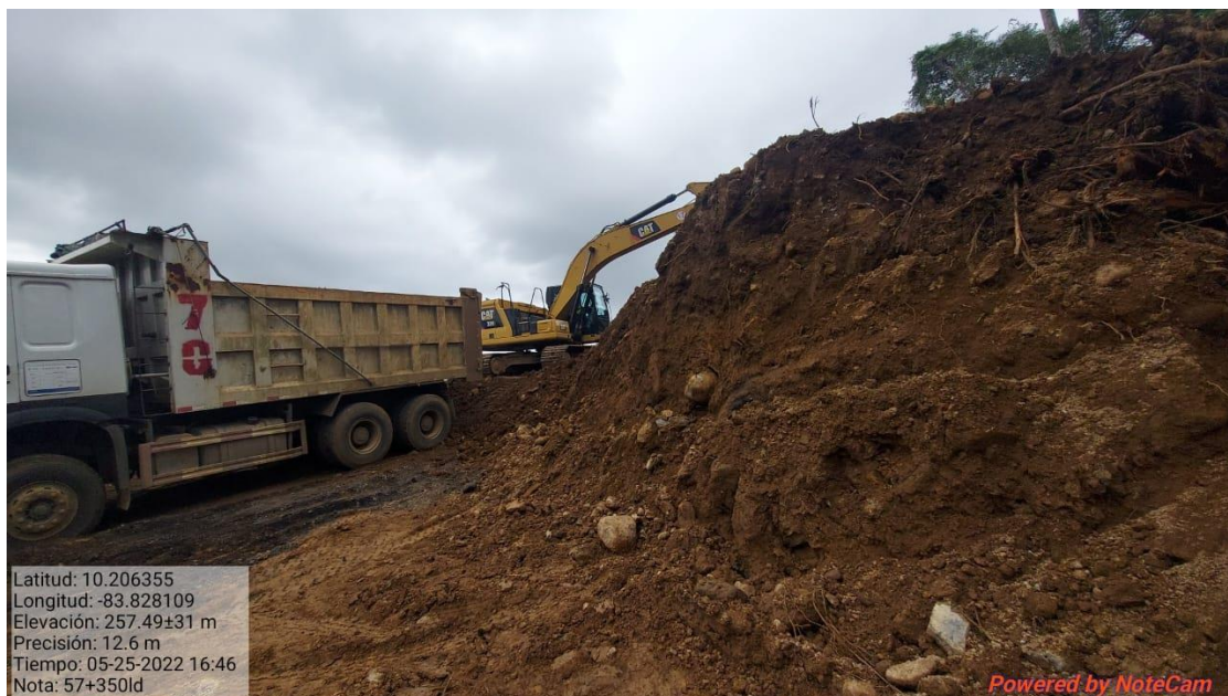
Figura 3. Supervisión en zona de extracción en km57/58 LD
