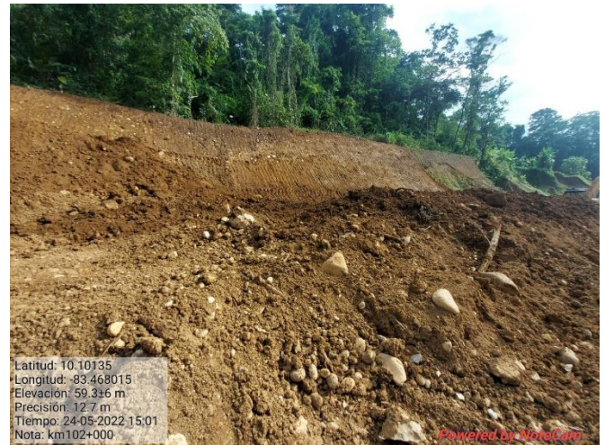
Figura 14. Excavación de taludes, km 102.
