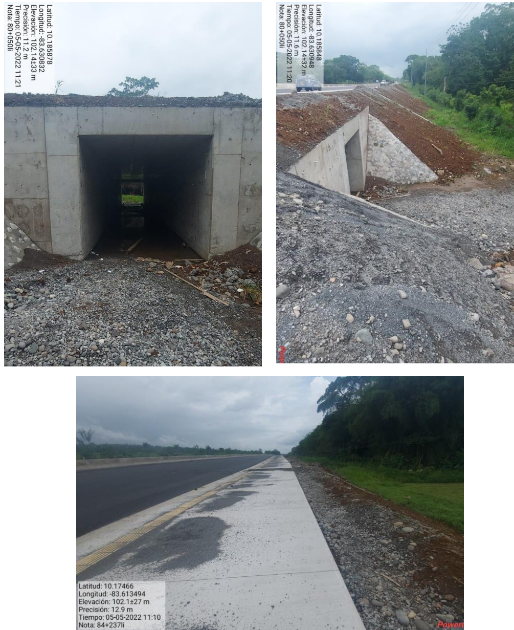
Figura 8. Supervisión en áreas de paso de fauna
