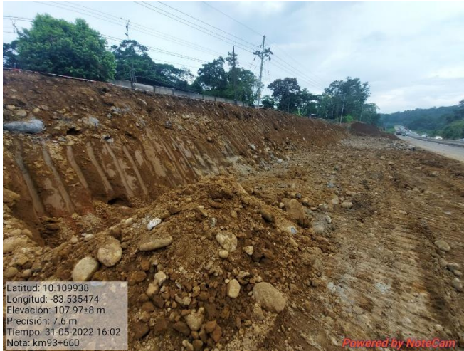
Figura 12. Excavación del talud, km 93.
