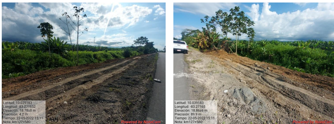
Figura 16. Limpieza de la vía, km 127.
