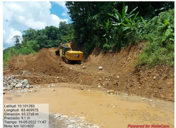
Figura 13. Excavación de taludes, km 101.
