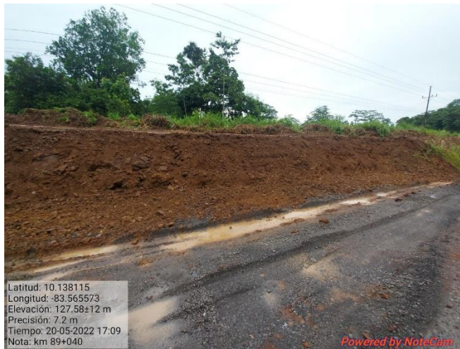
Figura 10. Excavación del talud, km 89.
