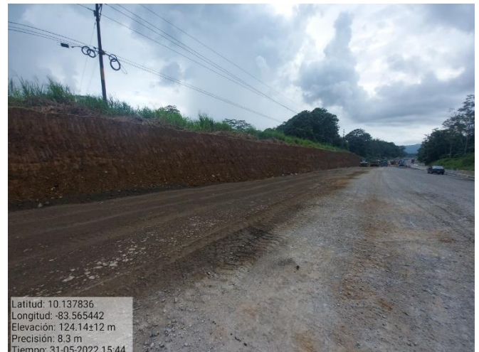
Figura 10. Excavación del talud, km 89.
