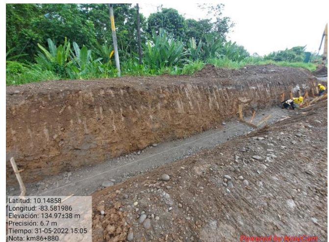
Figura 9. Conformación de zanjeos para cunetas, km 86.
