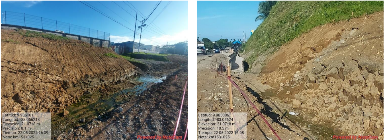
Figura 18. Excavación para alcantarillas, km 153.
