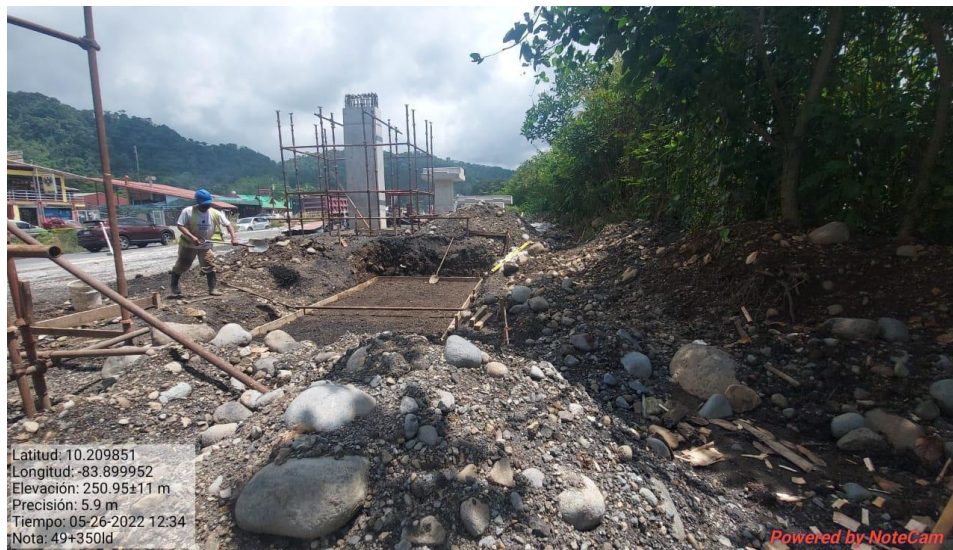
Figura 2. Revisión de áreas contiguas a trabajos en construcción de puente
