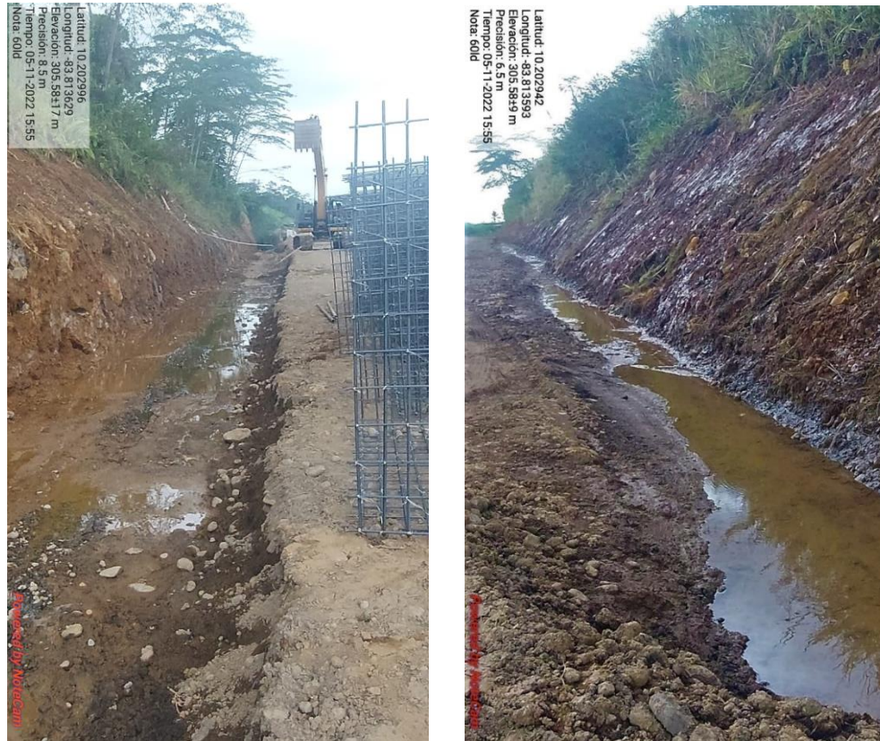
Figura 6. Construcción de cunetas en km59LD
