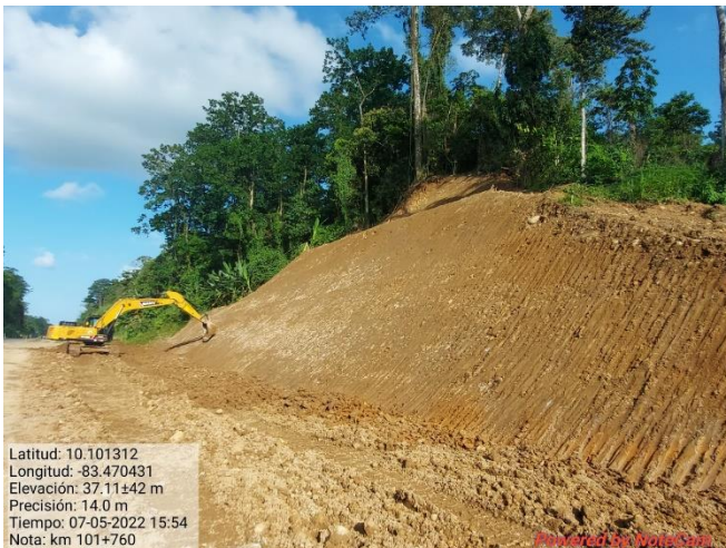
Figura 13. Excavación de taludes, km 101.
