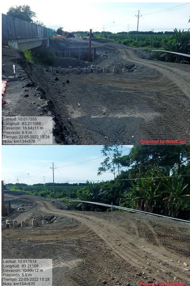
Figura 17. Excavación del antiguo puente sobre el río Rojo, km 134.
