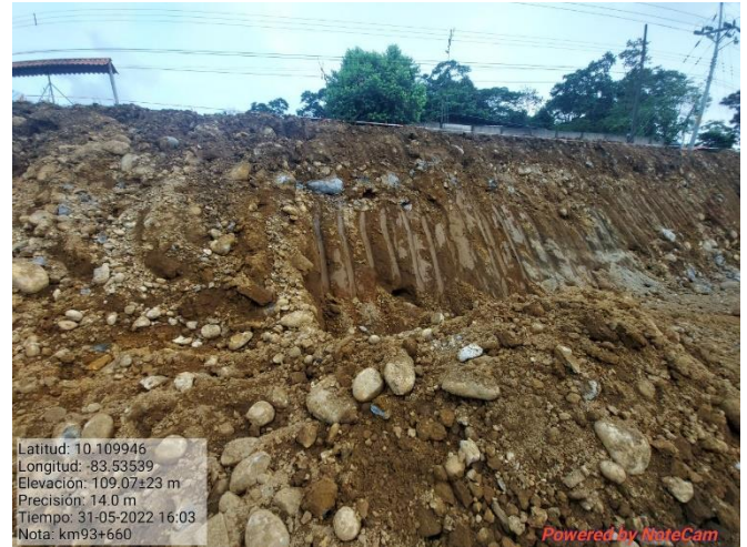
Figura 12. Excavación del talud, km 93.
