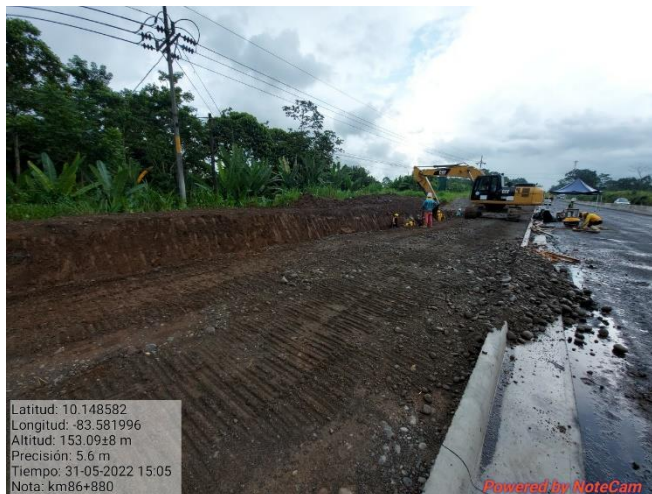
Figura 9. Conformación de zanjeos para cunetas, km 86.
