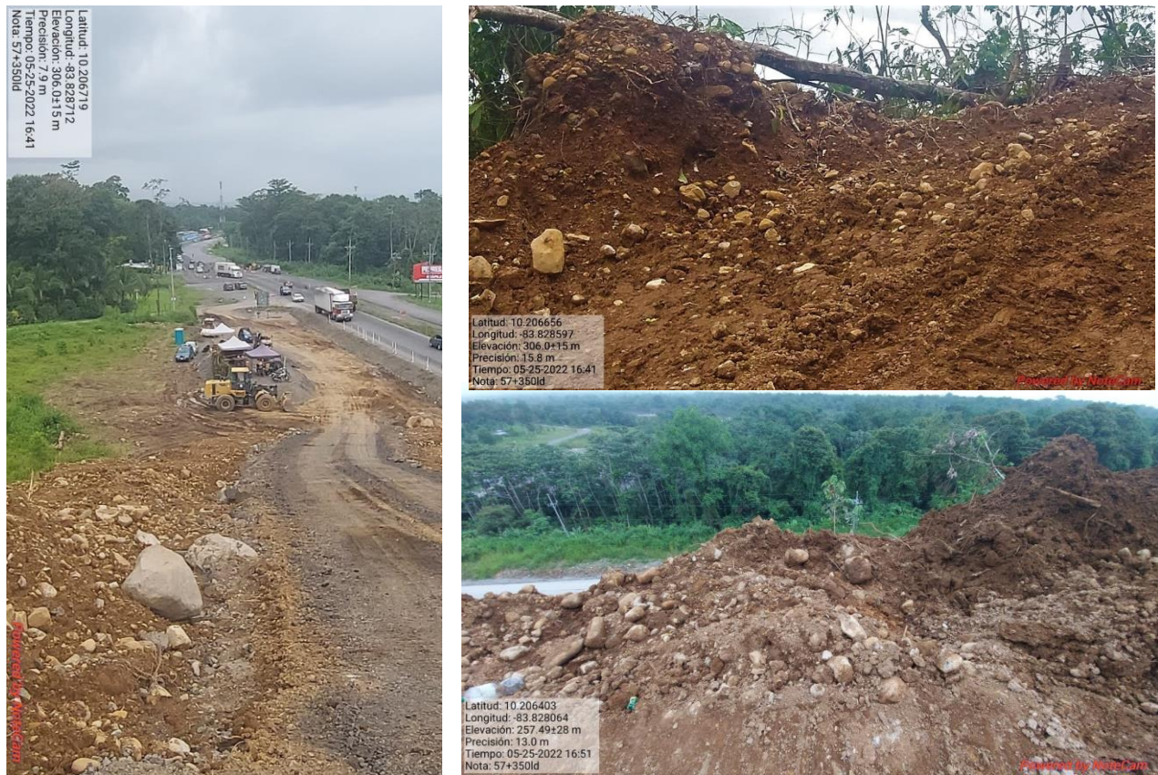
Figura 4. Diferentes aspectos de la supervisión realizada en extracción de material en km 57/58
