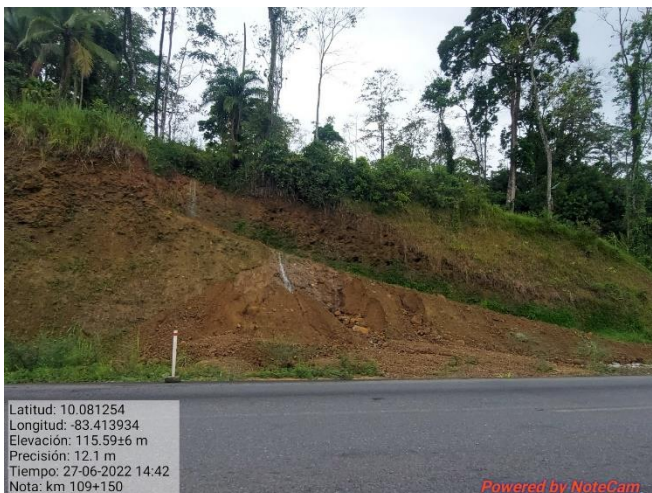
Figura 9. Revisión de taludes caídos por efecto de la lluvia.
