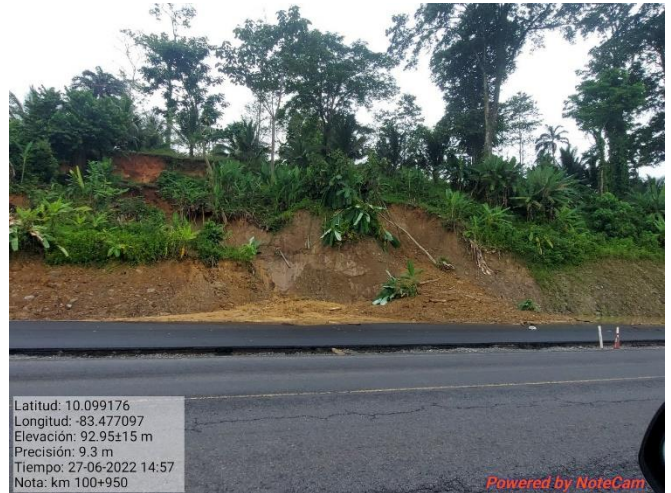
Figura 9. Revisión de taludes caídos por efecto de la lluvia.
