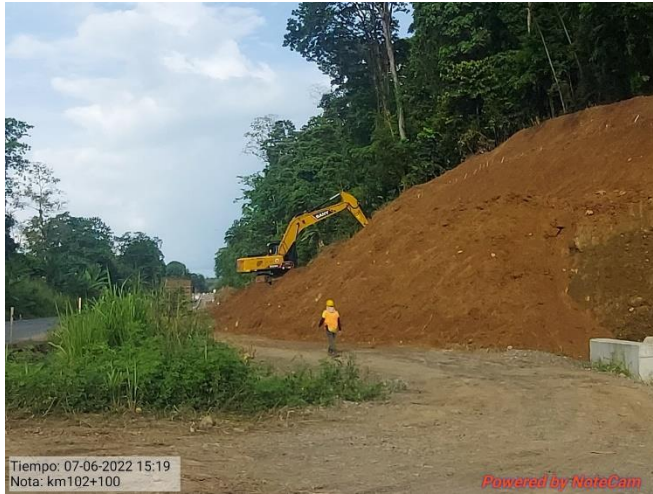
Figura 8. Conformación de taludes en el km 102.
