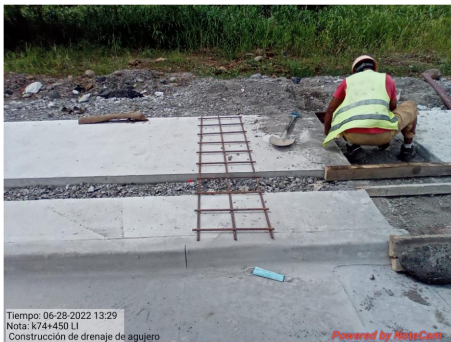
Figura 4. Actividades de asfaltado y construcción de aceras.
