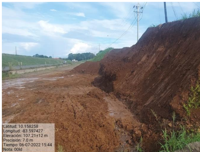
Figura 5. Conformación del talud, km 85.
