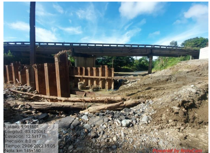
Figura 13. Excavación para pilotes, km 145.
