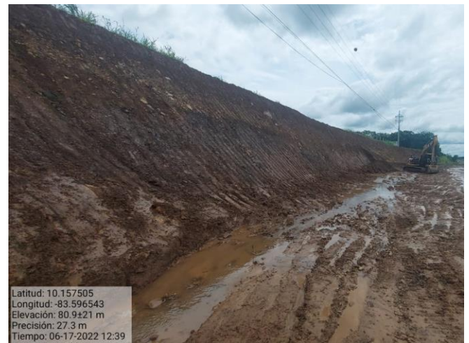
Figura 5. Conformación del talud, km 85.
