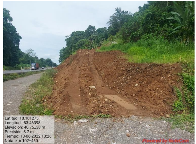
Figura 8. Conformación de taludes en el km 102.
