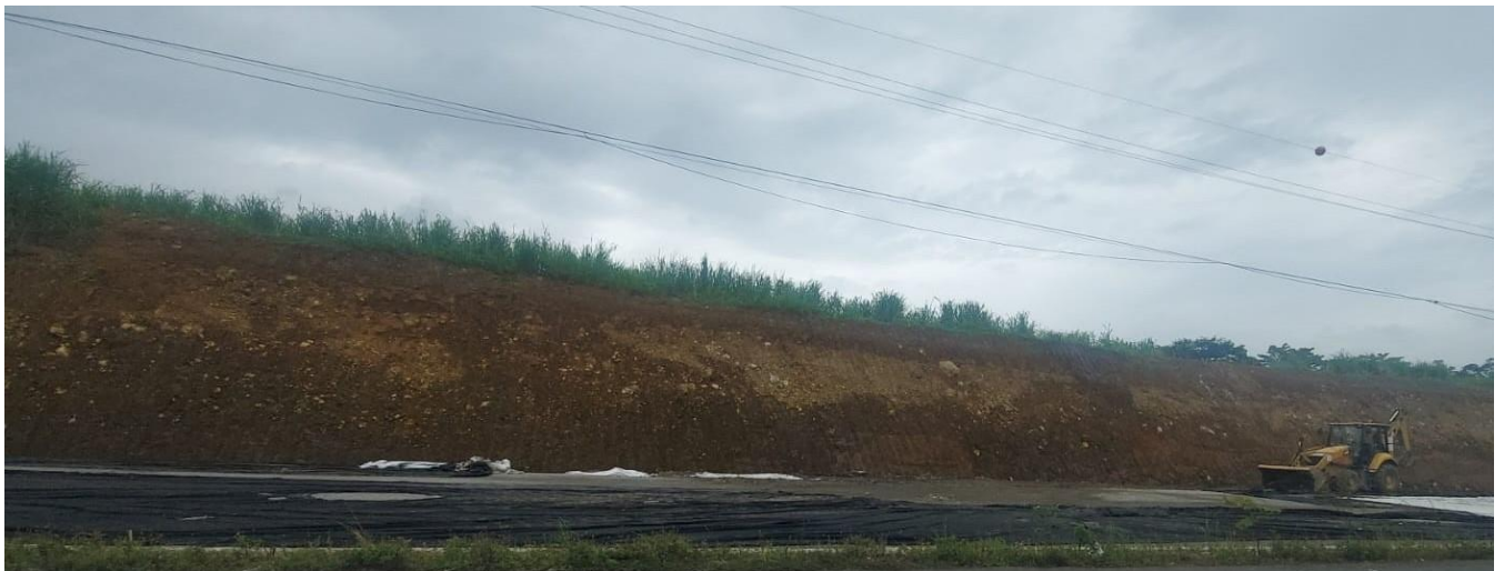
Figura 10. Revisión de talud en km 84+900
