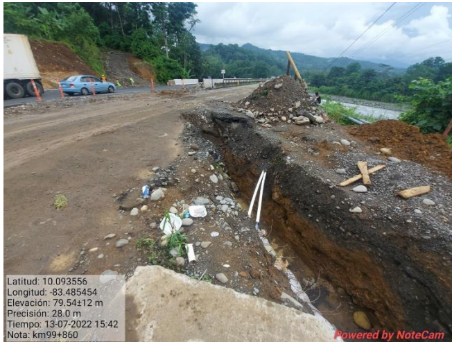
Figura 11. Excavación para cambio de servicios públicos, km 99.
