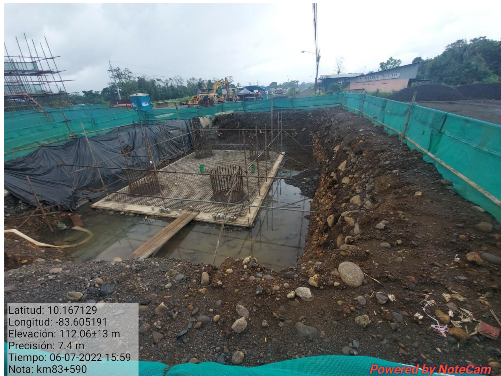
Figura 9. Excavación para pilotes, km 83.
