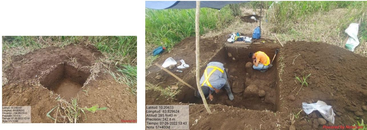
Figura 5. Excavación de pozos de sondeo en km57+ terreno inferior
