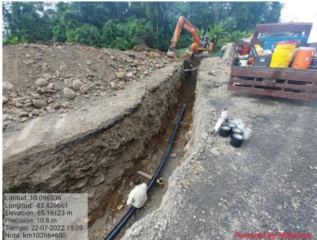
Figura 15. Excavación para cambio de servicios públicos km 106.
