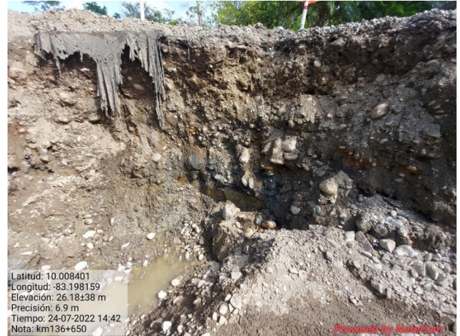
Figura 18. Excavación para gaviones, km 136.
