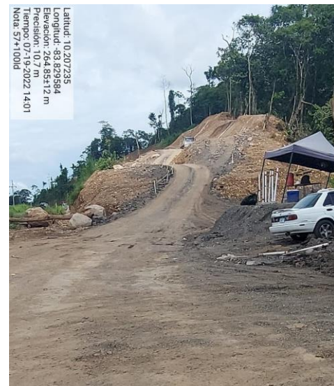
Figura 3. Se revisa talud en trabajos de desagües en el km 54+100LD
