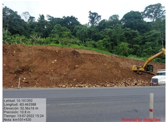
Figura 13. Excavación del talud, km 101.
