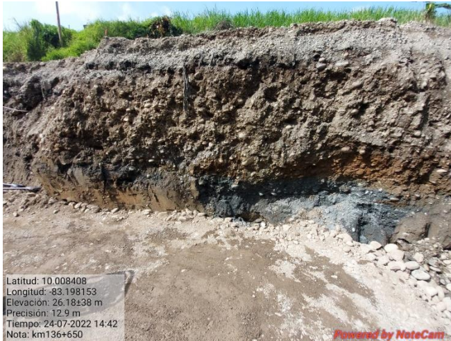
Figura 18. Excavación para gaviones, km 136.
