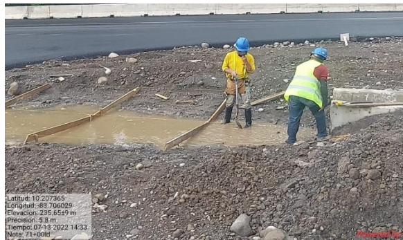
Figura 8. Área de construcción de cunetas en retorno km71
