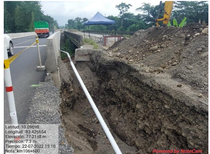
Figura 15. Excavación para cambio de servicios públicos km 106.
