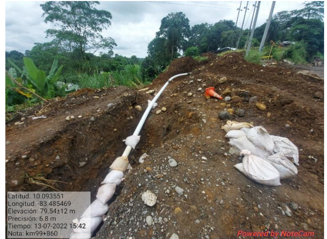
Figura 11. Excavación para cambio de servicios públicos, km 99.
