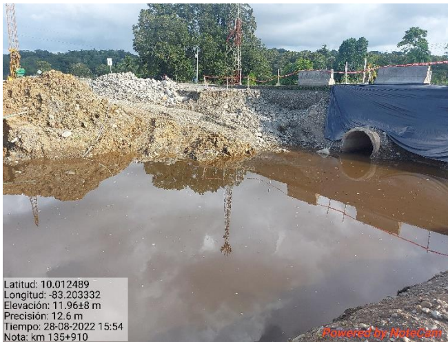
Figura 14. Excavación para alcantarillas, km 135.
