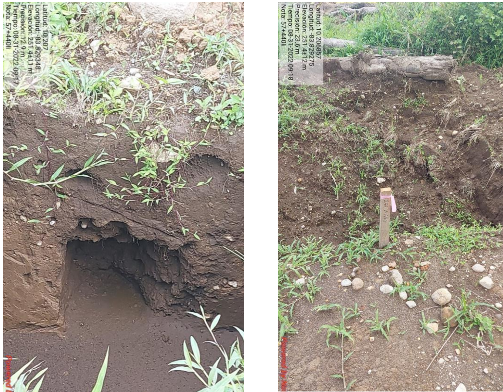
Figura 4. Pozos de sondeos alterados
