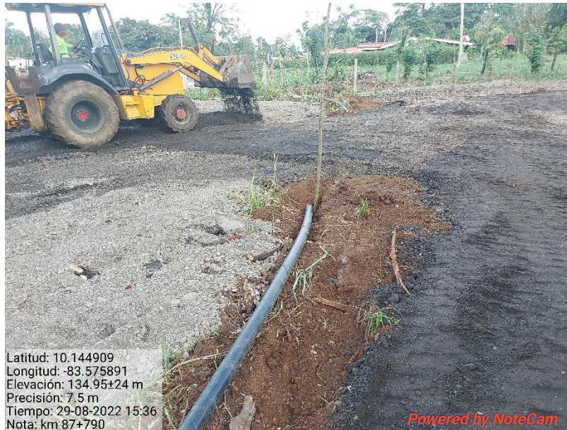
Figura 10. Inspección de terrenos para colocar paso peatonal, km 87.
