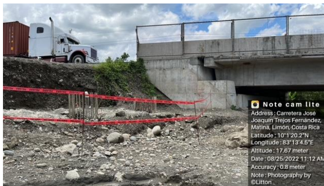
Fotografía 2. Delimitación de la zona afectada, actualmente sin actividades constructivas.
