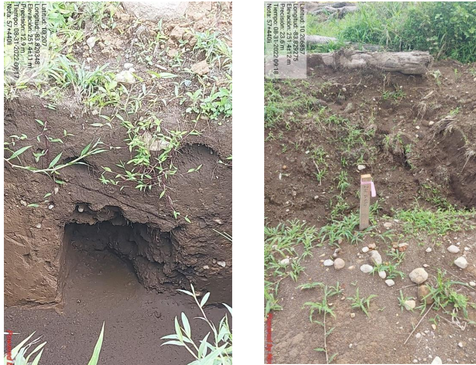
Figura 4. Pozos de sondeos alterados
