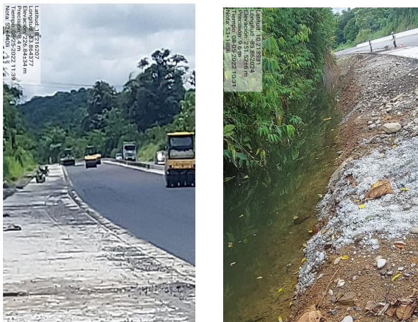
Figura 5. Diferentes zonas de trabajo inspeccionadas Km52+440, km53+180
