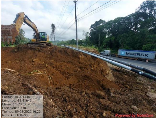
Figura 12. Excavación de calle marginal, km 108.
