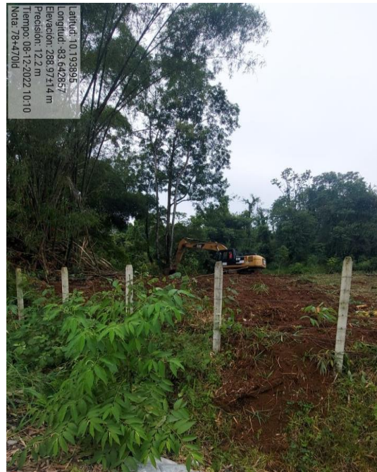
Figura 6. Se hace inspección visual en área de retiro de
