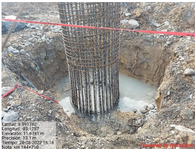
Figura 15. Excavación para paso peatonal, km 144.
