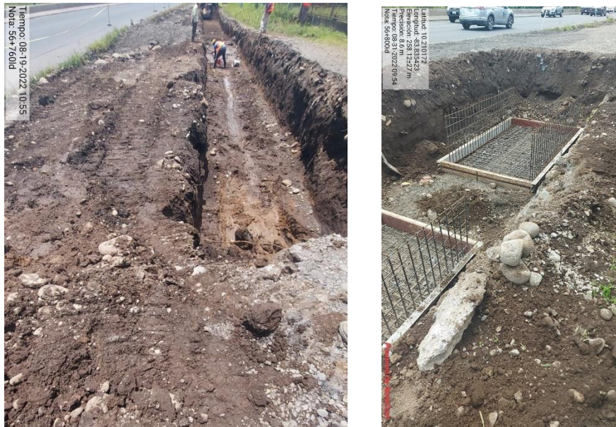
Figura 2. Construcción de desagüe km56+800LD
