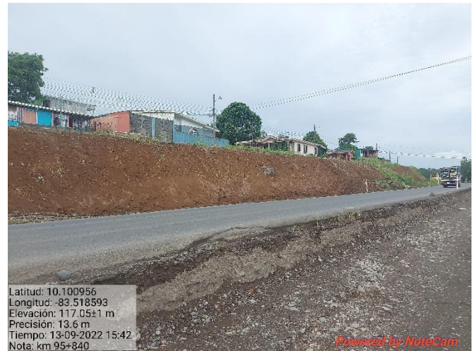
Figura 9. Conformación del talud km 95+750 al 95+850.
