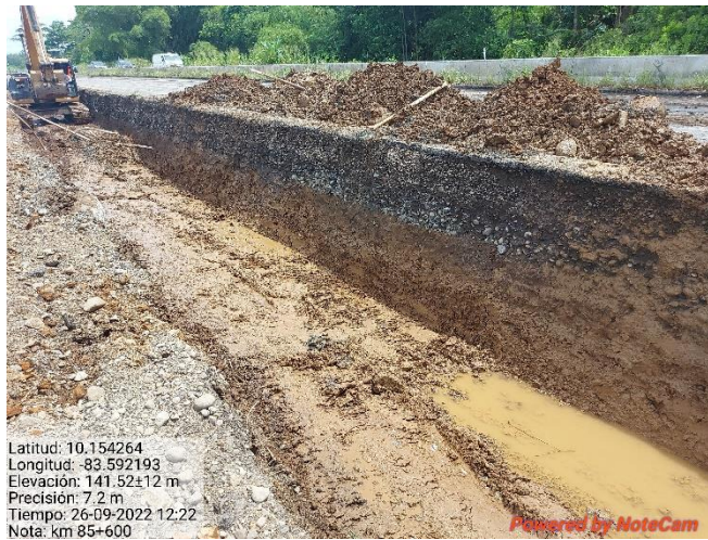
Figura 6. Excavación para ciclovía, km 85.
