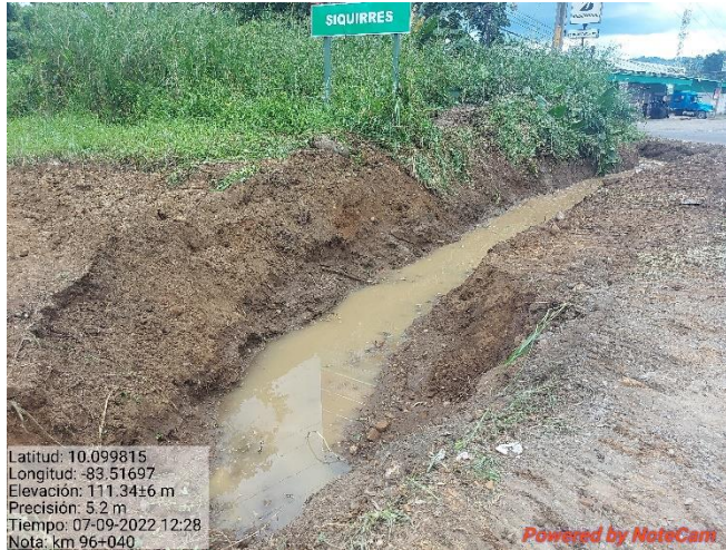
Figura 10. Zanjes para desagües del lado derecho, km 96+040.
