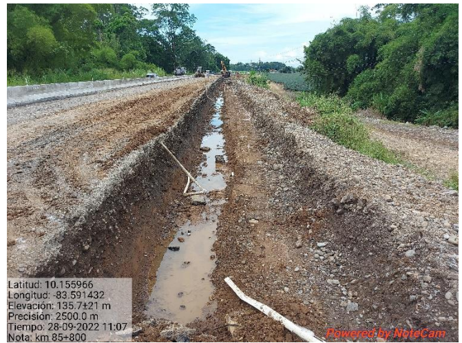
Figura 6. Excavación para ciclovía, km 85.
