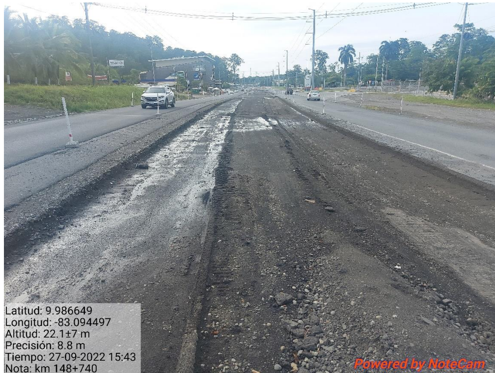
Figura 13. Excavación de la vía antigua, km 148.
