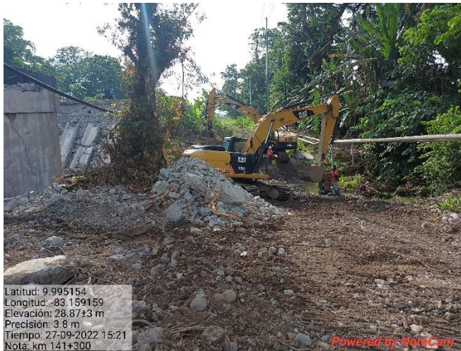
Figura 12. Demolición del puente del río Madre, km 141.
