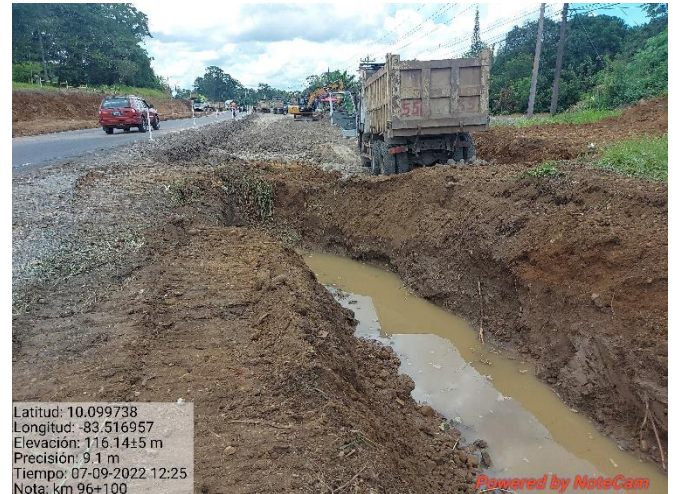
Figura 10. Zanjes para desagües del lado derecho, km 96+040.
