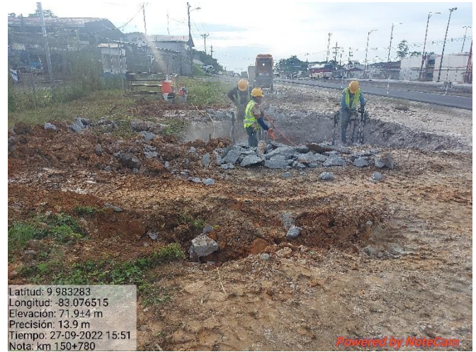
Figura 14. Excavación de pilotes, km 150.
