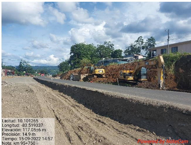
Figura 9. Conformación del talud km 95+750 al 95+850.
