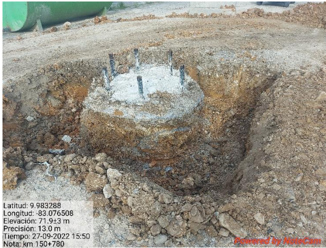
Figura 14. Excavación de pilotes, km 150.
