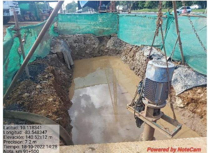
**Figura 10. Excavación de bases para PSV La Francia.**
