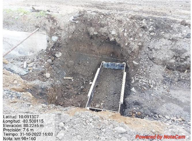
**Figura 12. Excavación para alcantarilla, km 98+160.**
