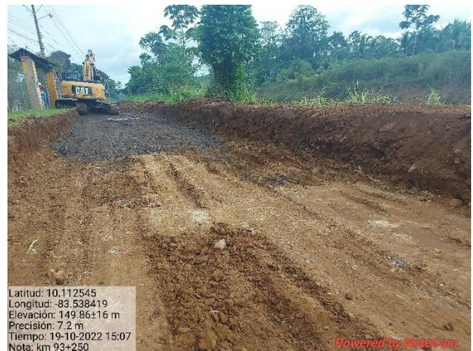
En el km 98+160 se estuvo inspeccionado la excavación para alcantarillas, parte de los estratos estaban mezclados con material de relleno reciente, sin embargo, se observó un estrato de tierra negra pero sin material arqueológico.
