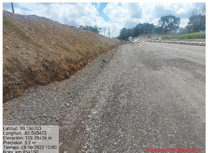
**Figura 9. Continuación de conformación de ciclovia, sin material en los perfiles.**
