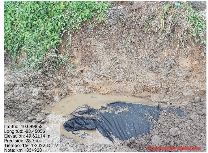
Figura 11. Excavación para alcantarilla, km 103+900.
