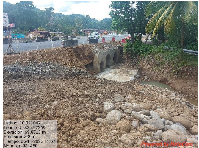
Figura 8. Excavación para alcantarilla, km 98.
