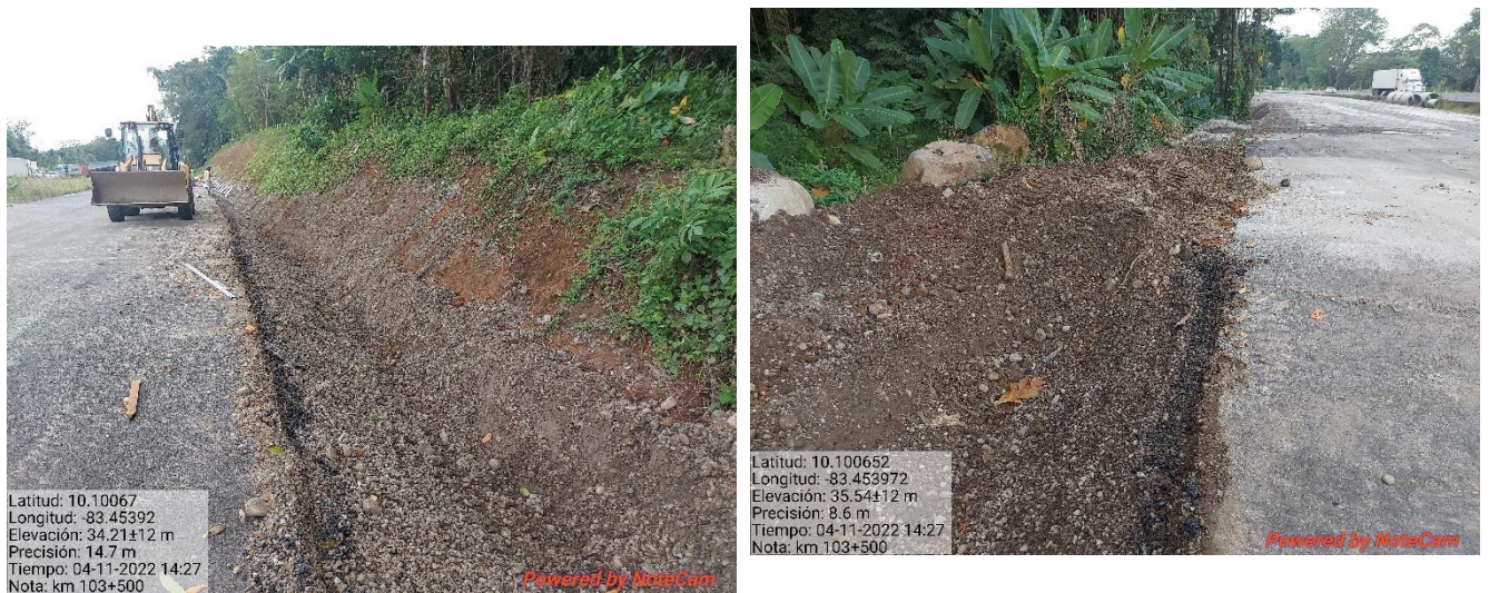
Figura 10. Excavación para alcantarilla, km 103+500
