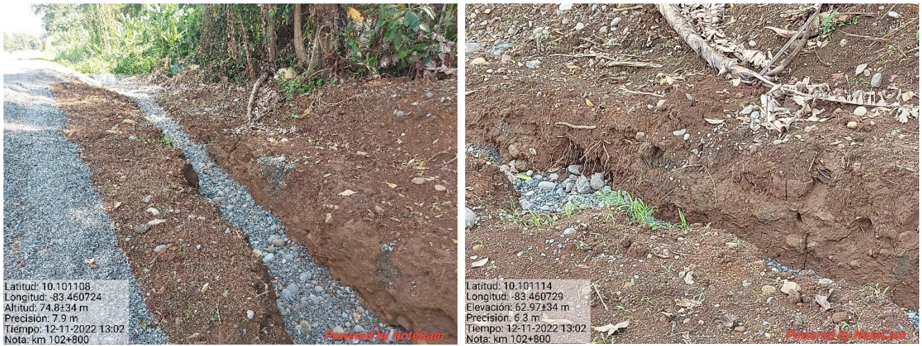
Figura 9. Excavación para alcantarilla, km 102.
