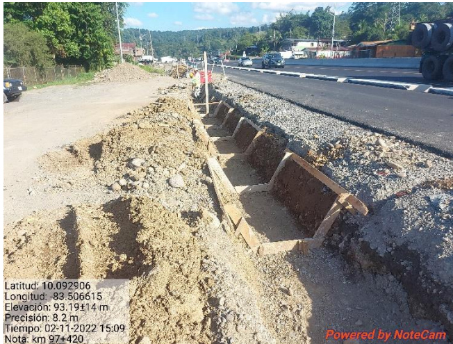
Figura 7. Excavación para alcantarilla, km 97.
