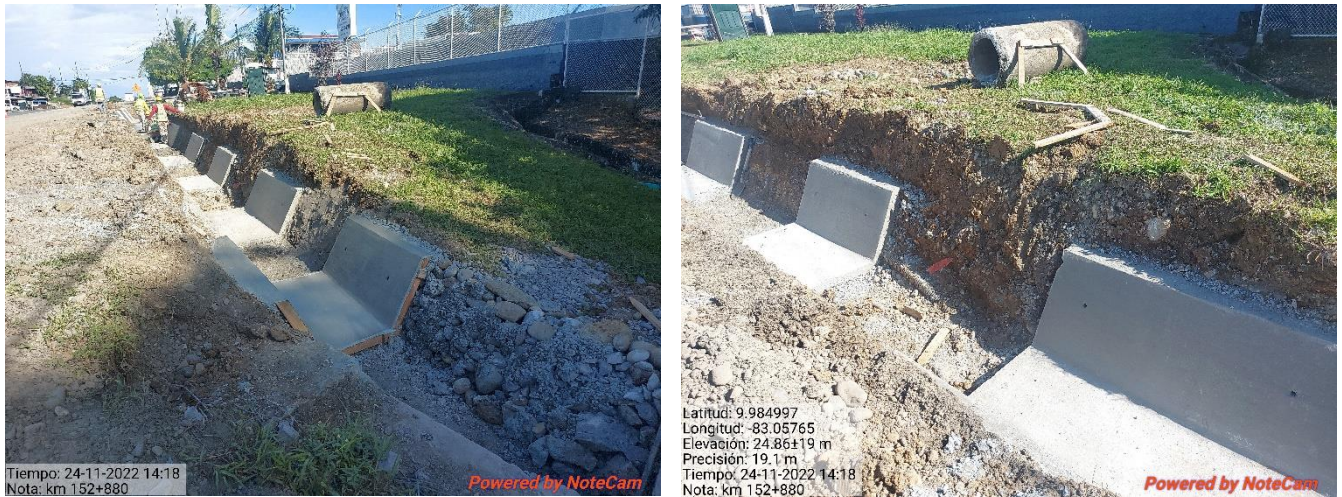
Figura 17. Excavación de alcantarillas, km 152.
