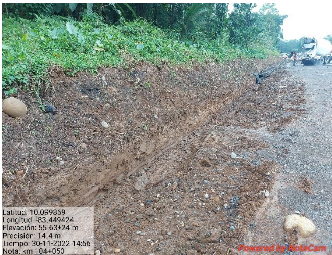
Figura 12. Excavación para alcantarilla, km 104+000.
