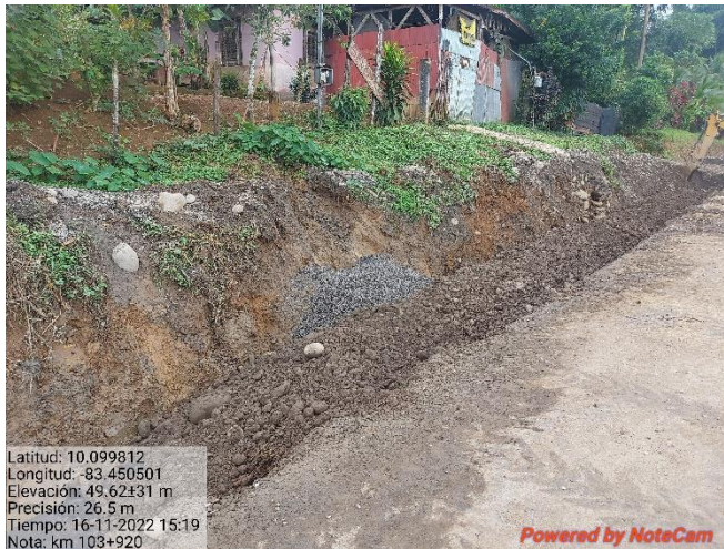
Figura 11. Excavación para alcantarilla, km 103+900.
