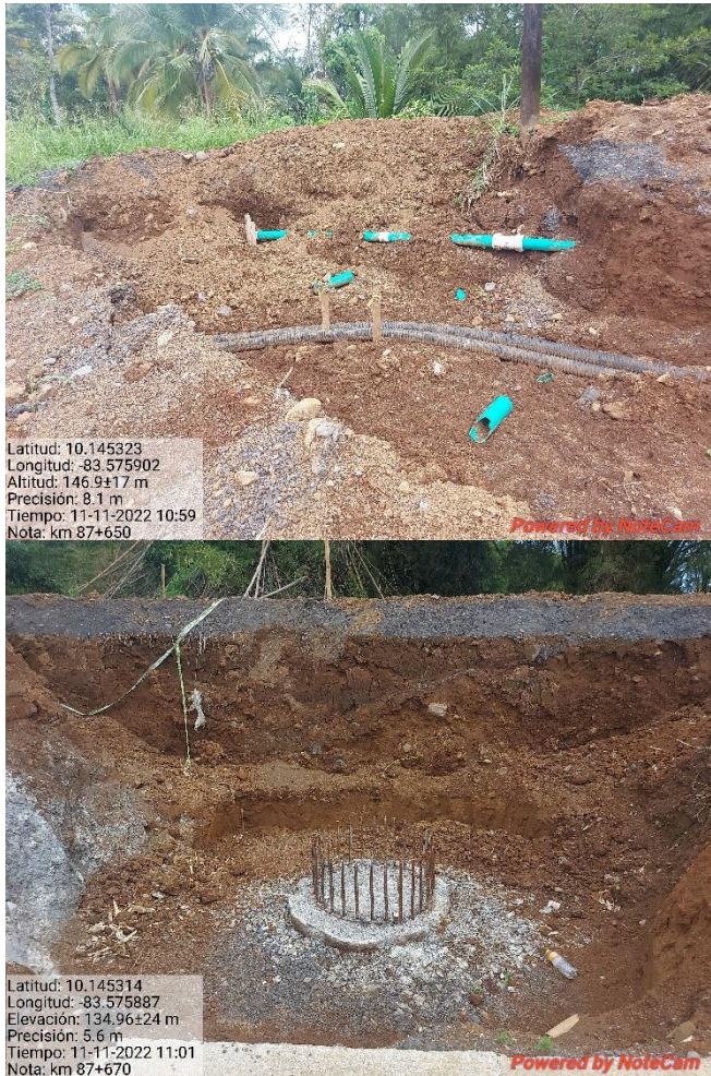
Figura 6. Excavación para paso peatonal, km 87.
