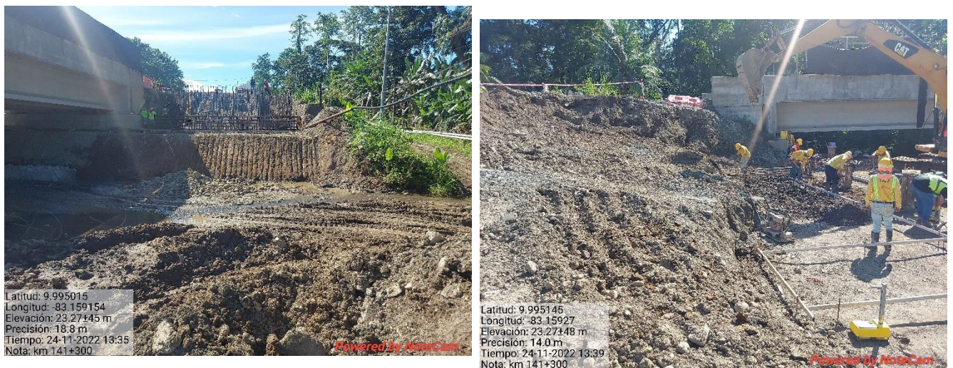
Figura 16. Excavación de base de puente río Madre, km 141.
