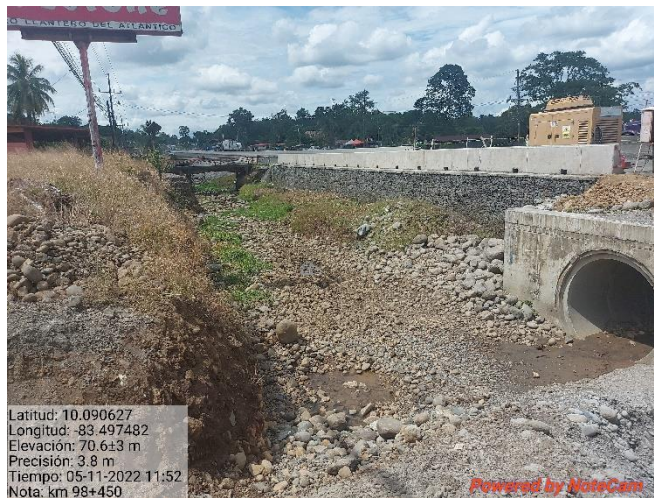
Figura 8. Excavación para alcantarilla, km 98.
