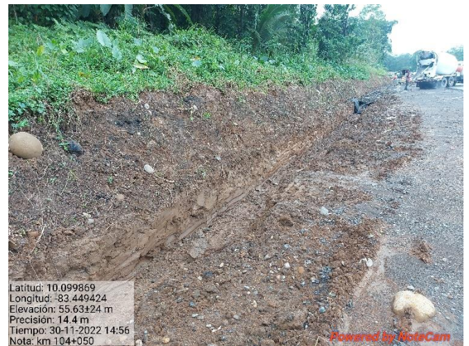
Figura 12. Excavación para alcantarilla, km 104+000.
