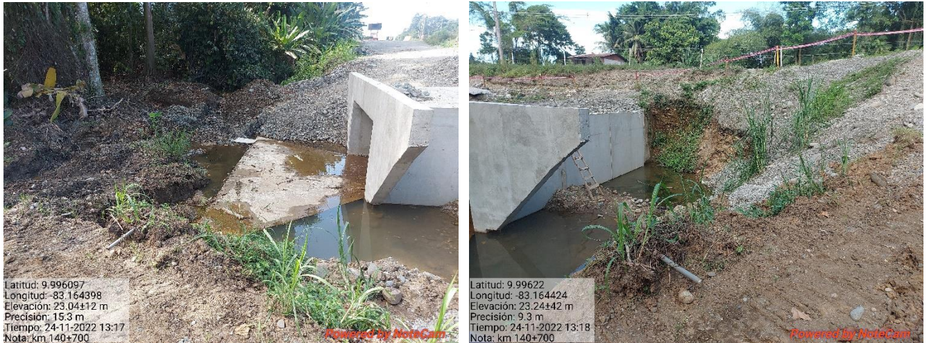
Figura 15. Inspección al área de construcción de alcantarilla, km 140.
