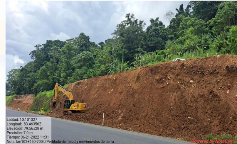
Excavación y terracería en Km 102+450 al 102+700, Lado derecho
