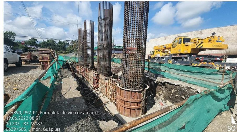
**Vertido de concreto viga de amarre pila P1, IC 62+890**
