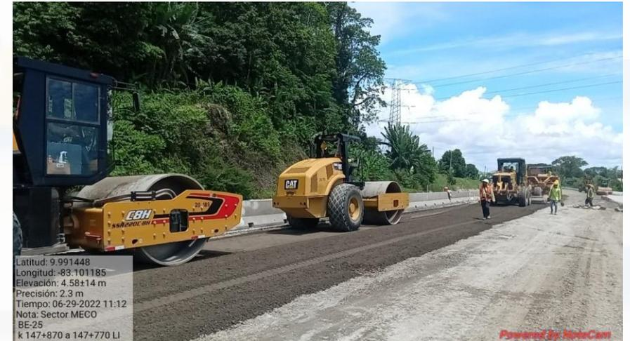
Colocación de capa de base estabilizada con cemento Km 147+870 al 147+770 Lado izquierdo
