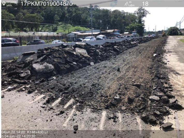
Deconstrucción de capa de asfalto existente, Km 148+430, Lado izquierdo
