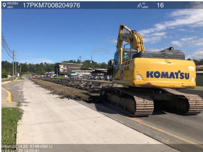
Deconstrucción de capa de asfalto existente, Km 148+290, Lado izquierdo
