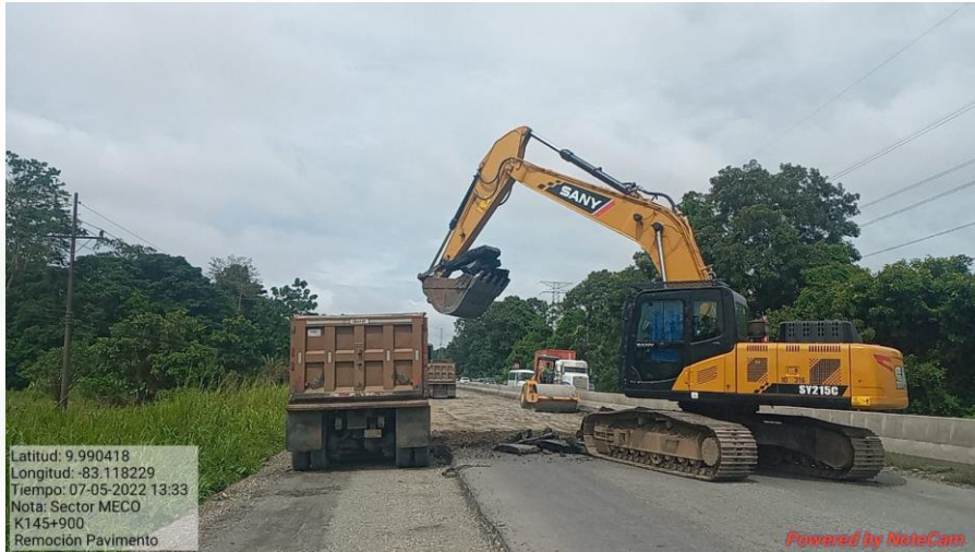
Deconstrucción de capa de asfalto existente, Km 145+900, Lado izquierdo
