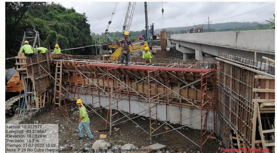
Puente 29 Km 133+950, Río Cuba
