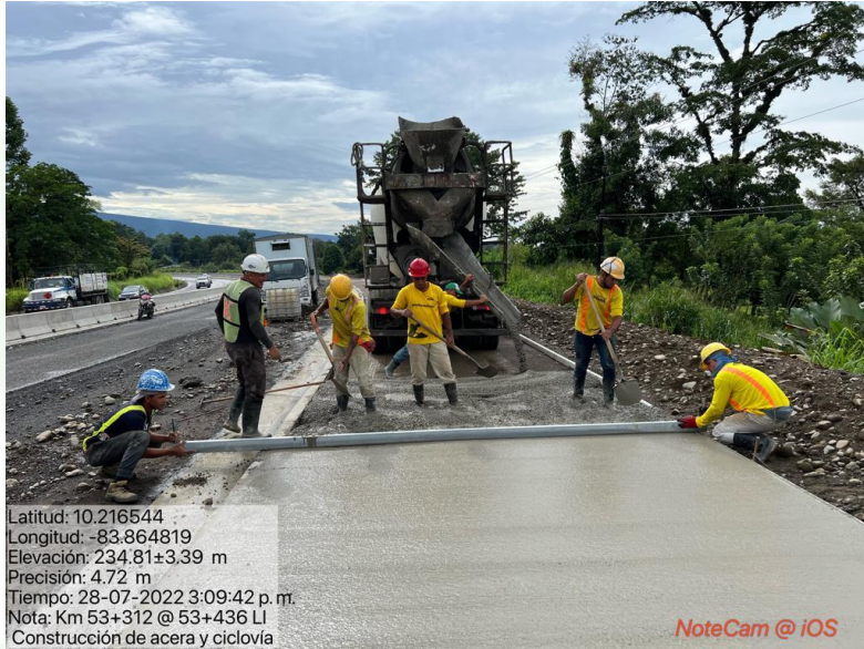
Construcción de aceras Km 53+312 al 53+436, Lado izquierdo
