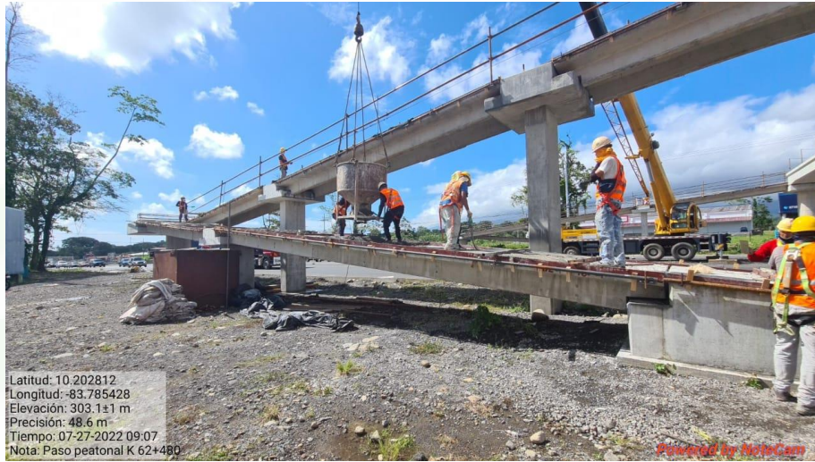
Puente peatonal Km 62+488
