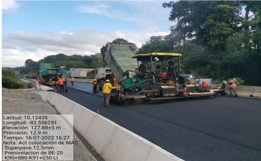
Colocación de capa de mezcla asfáltica en caliente Km 90+880 al 91+030, Lado izquierdo
