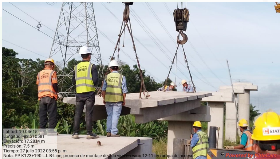
Puente peatonal Km 123+120
