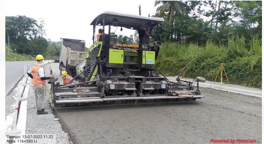
Colocación de capa de base estabilizada con cemento Km 116+580, Lado izquierdo
