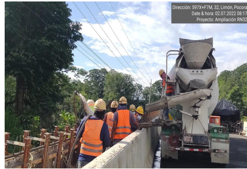
Puente 13 Km 84+269, Río Destierro
