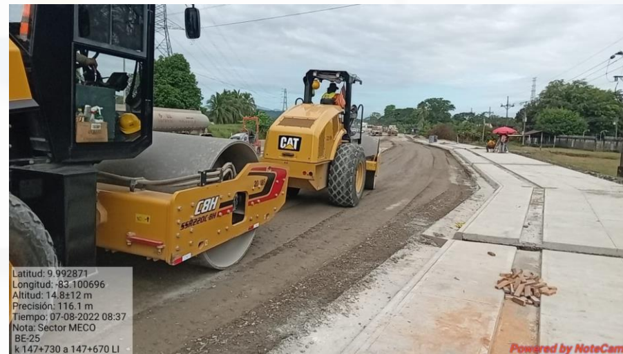
Conformación y compactación del relleno para bahía de autobús Km 147+730 AL 147+670, Lado izquierdo
