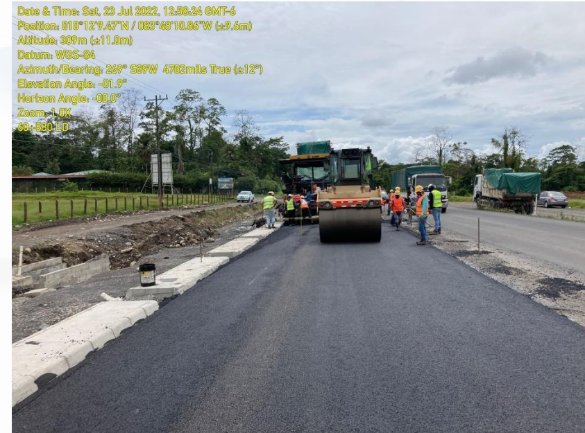
Asfaltado de la calle marginal Km 60+580, Lado izquierdo
