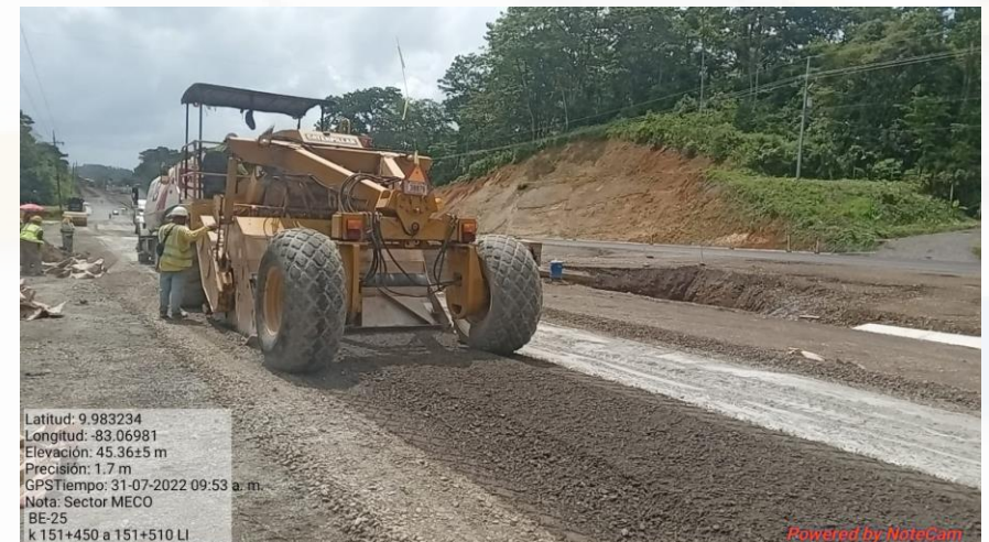
Colocación de capa de base estabilizada con cemento Km 151+450 al 151+510, Lado izquierdo
