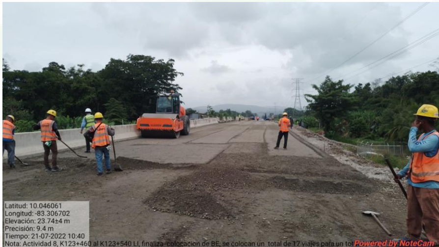
Colocación de capa de base estabilizada con cemento, Km 148+290, Lado izquierdo
