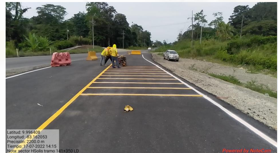
Demarcación peatonal del Km 141+350 LD
