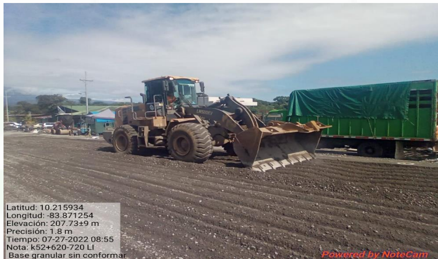
Extendido de capa de base granular en Km 52+620 al 52+720, Lado izquierdo
