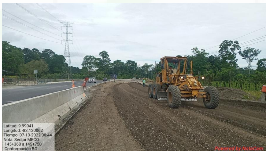
Extendido de capa de base granular en Km 145+360 al 145+750, Lado izquierdo
