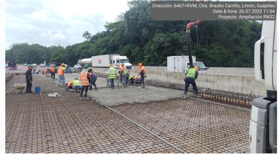
Puente 1 Km 50+975, Río Corinto
