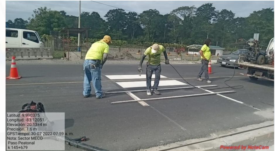
Demarcación peatonal del Km 145+679
