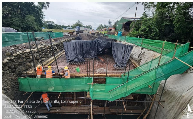
Alcantarilla de cuadro Km 63+372, Lado central
