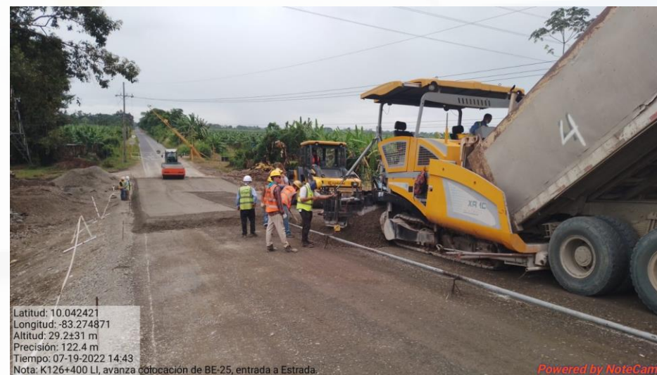
Colocación de capa e base estabilizada en acceso 126+400, Lado izquierdo
