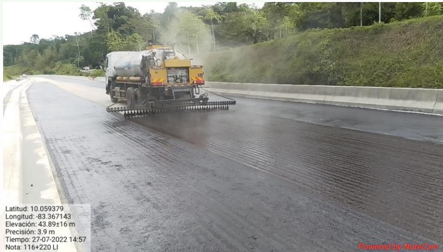
Riego de emulsión para imprimación en Km 116+220, izquierdo
