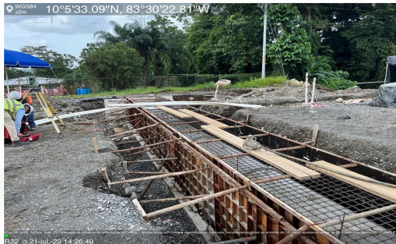
Alcantarilla tubular de concreto Km 97+460, Lado izquierdo
