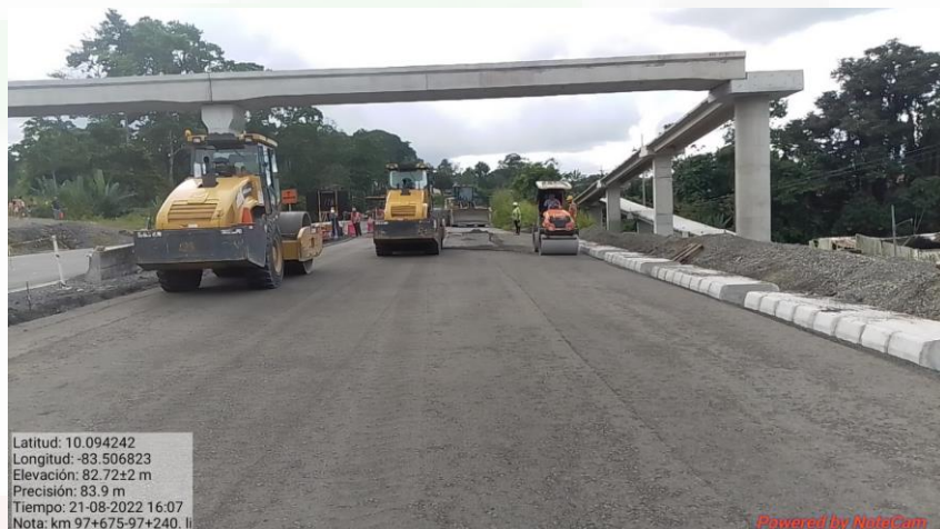
Colocación de capa de base estabilizada con cemento, Km 97+675, Lado izquierdo
