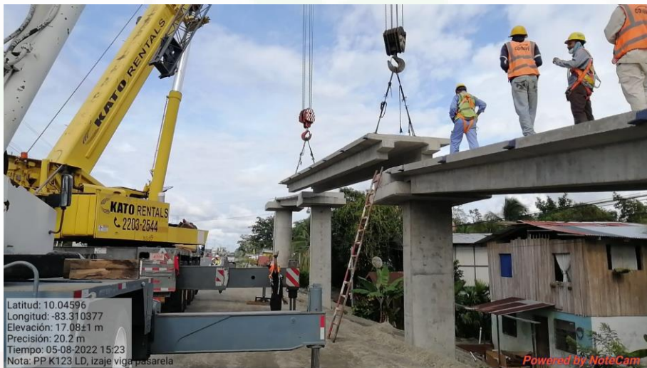
Puente peatonal Km 123+120
