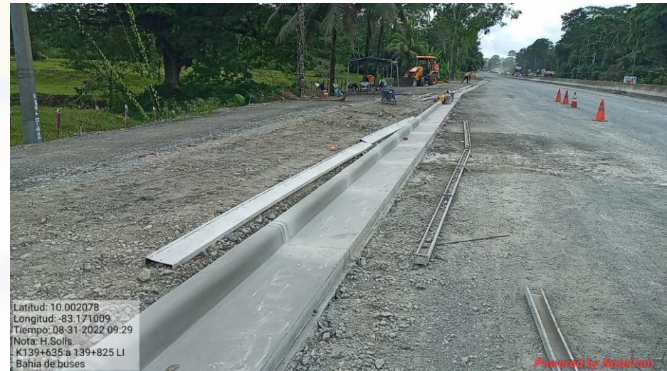
Conformación y compactación del relleno para bahía de autobús Km 139+635 al 139+825, Lado izquierdo
