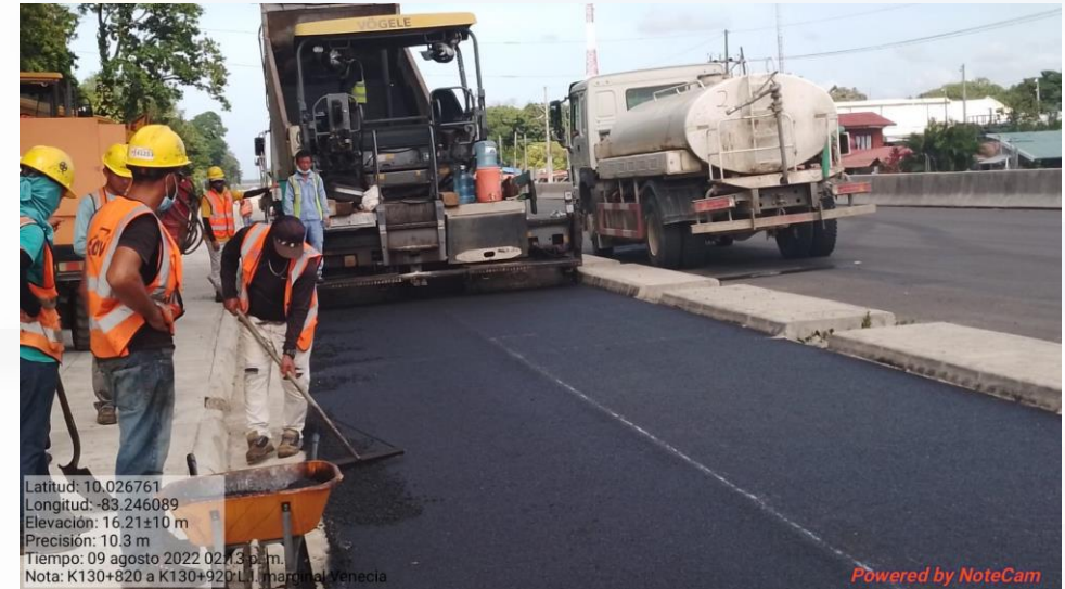
Asfaltado de la calle marginal Km 130+820 al 130+920, Lado izquierdo
