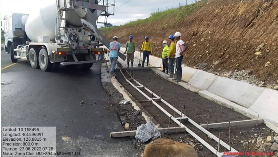
Construcción de aceras Km 84+894 al 84+901, Lado derecho
