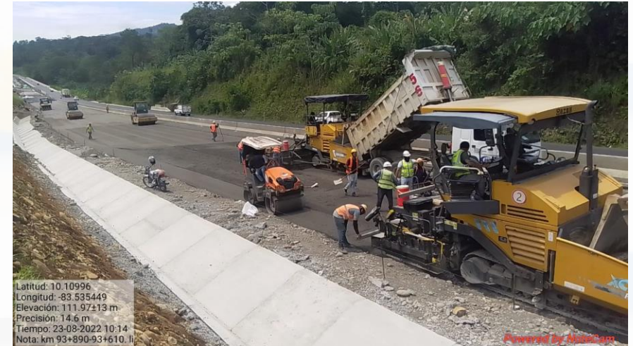
Colocación de capa de base estabilizada con cemento Km 93+890 al 93+610, Lado izquierdo
