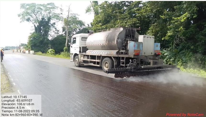
Riego de emulsión para imprimación en Km 82+960 al 83+390, Lado derecho
