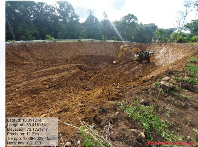
Excavación y terracería en el retorno Km 108+200, Lado derecho
