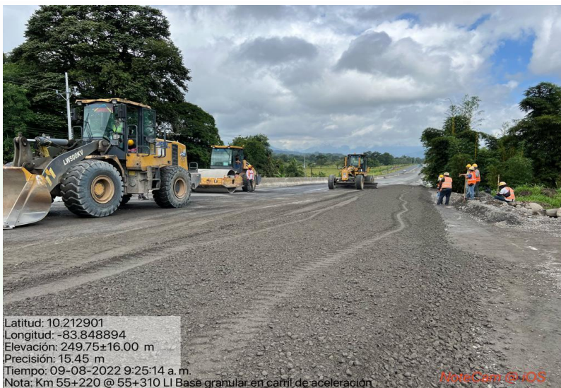
Extendido de capa de base granular en Km 55+220 al 55+310, Lado izquierdo
