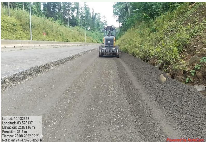
Extendido de capa de base granular en Km 94+470 al 95+050, Lado izquierdo
