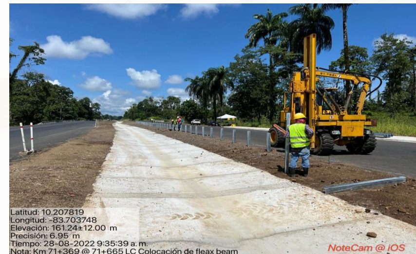
Colocación de la barrera Flex Beam en el retorno del Km 71+266
