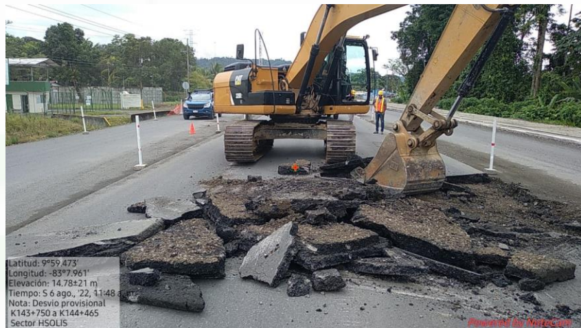
Deconstrucción de capa de asfalto existente, Km 143+750 al 144+465, Lado izquierdo
