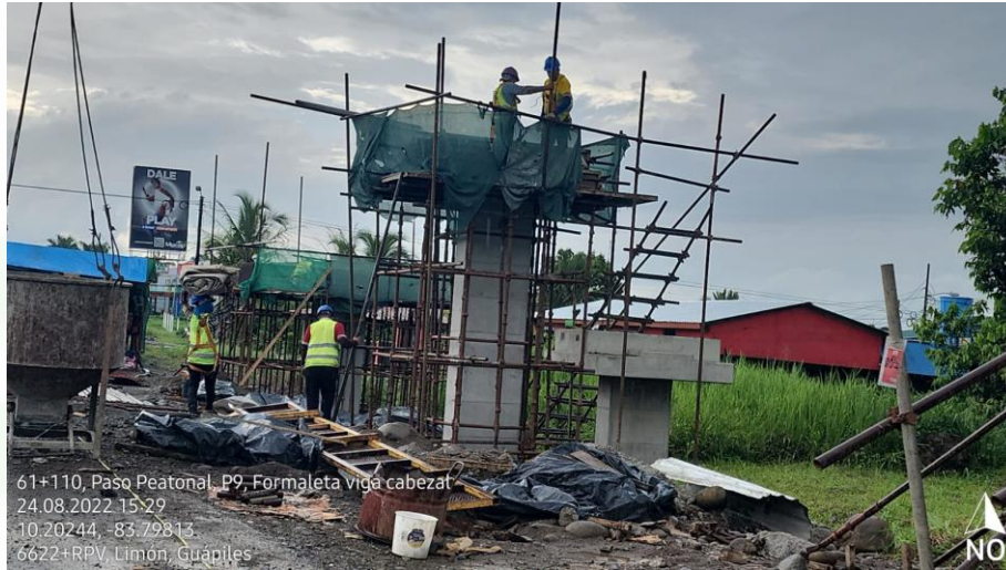
Puente peatonal Km 61+110
