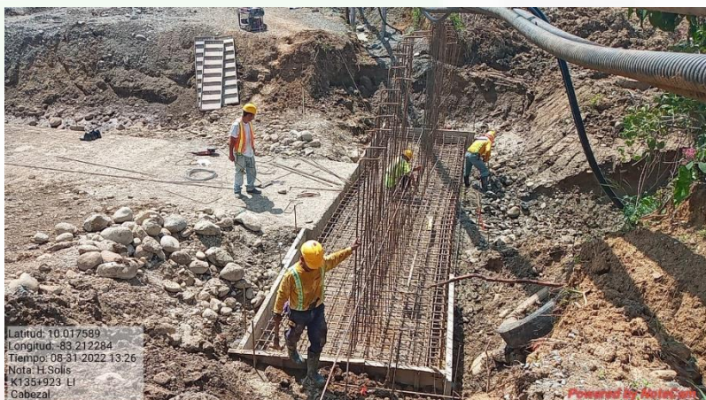
Alcantarilla de cuadro Km 135+925, Lado izquierdo
