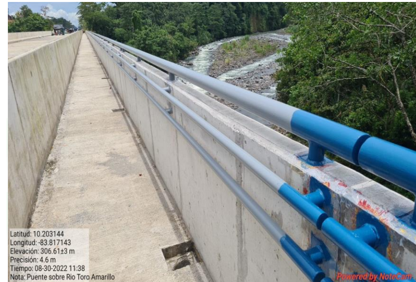
Puente 5 Km 59+124, Río Toro Amarillo
