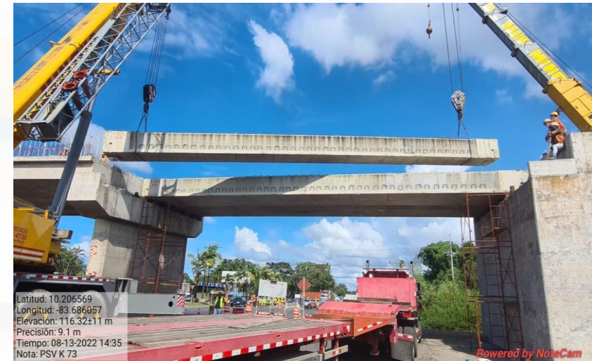
Paso Superior Vehicular Km 73+517
