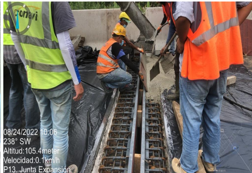
Puente 13 Km 84+269, Río Destierro
