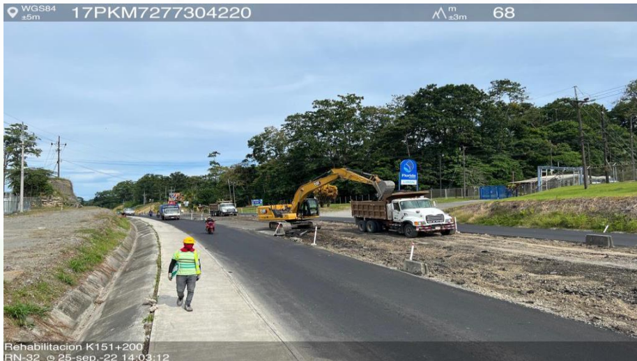
Deconstrucción de capa de asfalto existente, Km 151+200, Lado izquierdo
