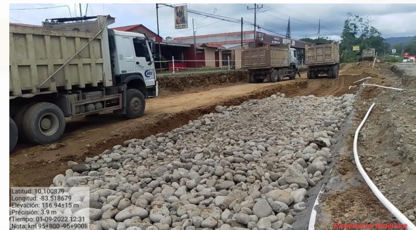
Relleno en Km 95+800 al 95+900, Lado izquierdo
