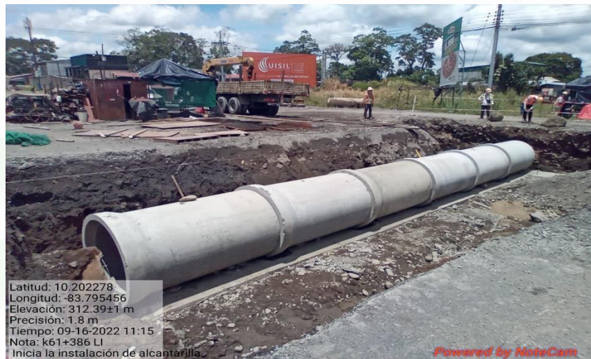
Alcantarilla tubular de concreto Km 61+386, Lado izquierdo
