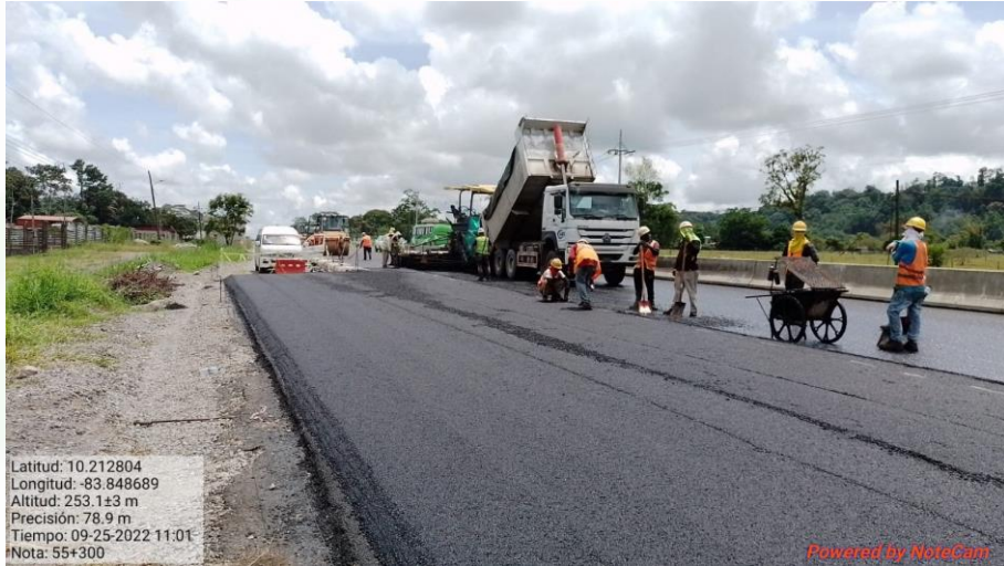
Colocación de capa de mezcla asfáltica en caliente, Km 55+300, Lado izquierdo
