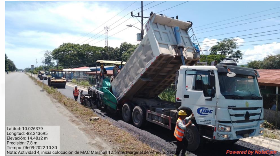
Asfaltado de la calle marginal Km 130+980 Lado Derecho
