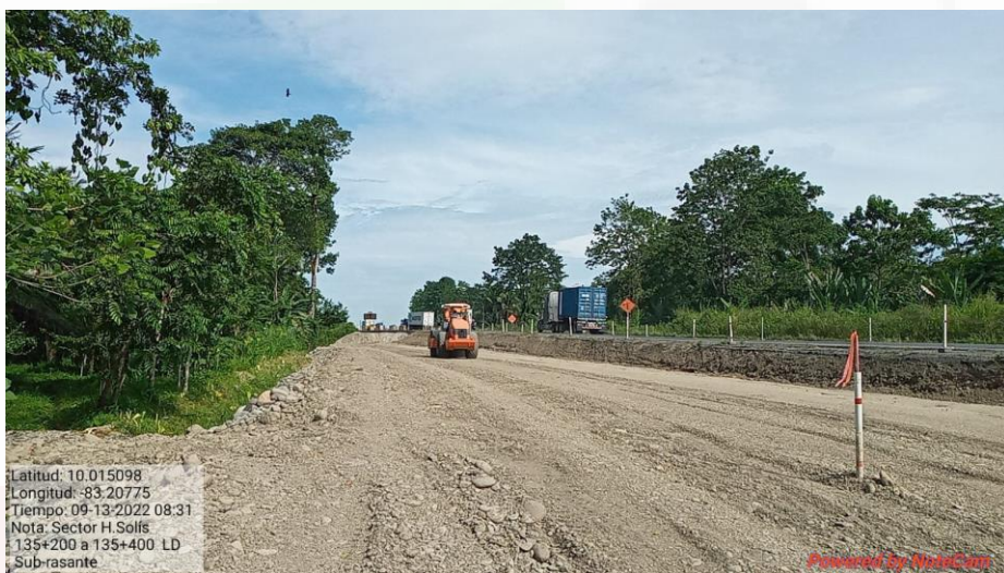
Extendido de capa de base granular en Km 135+200 al 135+400, Lado derecho
