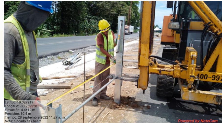
Colocación de la barrera Flex Beam en el retorno del Km 71+266
