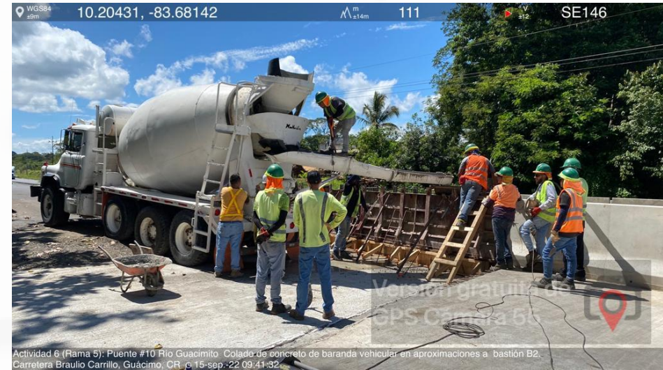
Puente 10 Km 74+049, Río Guacimito
