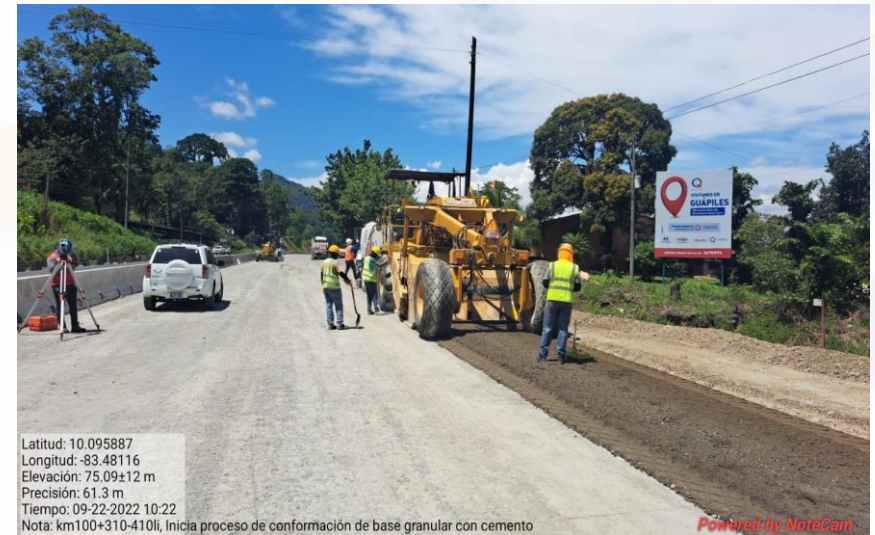
Colocación de capa de base estabilizada con cemento Km 100+310 al 100+410, Lado izquierdo
