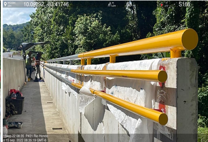
Puente 21 Km 107+814, Río Hondo
