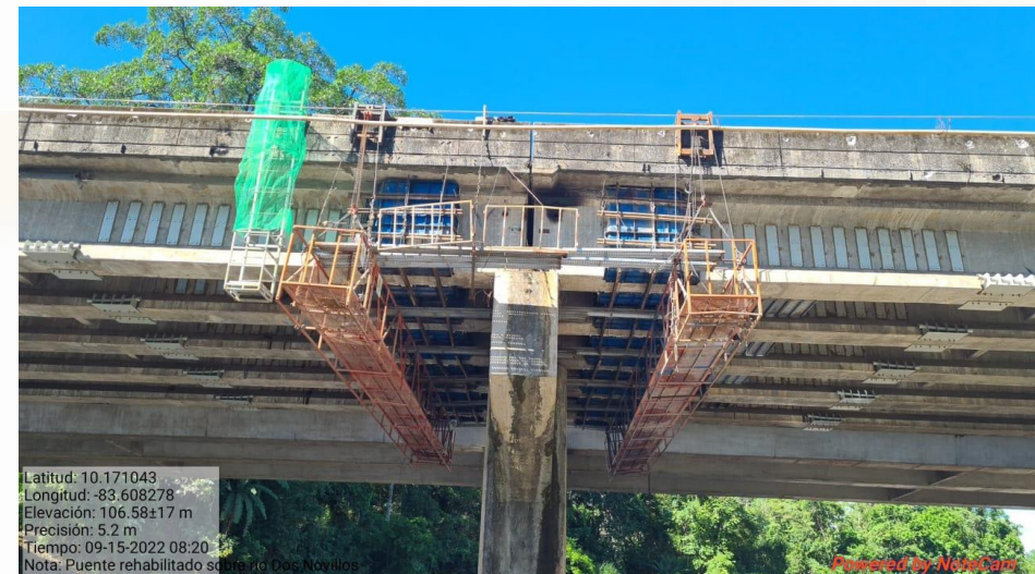
Puente 12 Km 83+035, Río Dos Novillos
