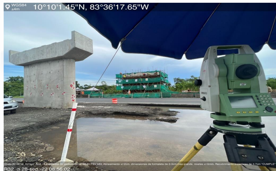
Paso Superior Vehicular Km 83+601
