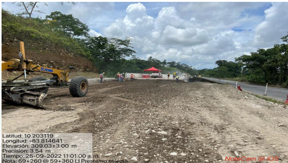
Extendido de capa de base granular en Km 59+260 al 59+360, Lado izquierdo
