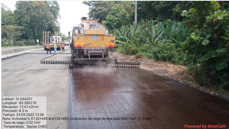
Riego de emulsión para imprimación en Km 126+445 al 126+482, Lado derecho
