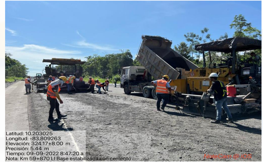
Colocación de capa de base estabilizada con cemento Km 59+870, Lado izquierdo
