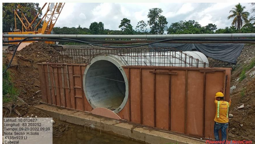
Alcantarilla tubular de concreto Km 135+925, Lado izquierdo
