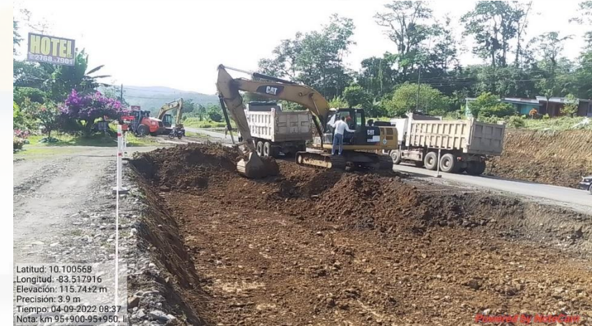
Excavación y terracería en Km 95+900 al 95+950, Lado izquierdo
