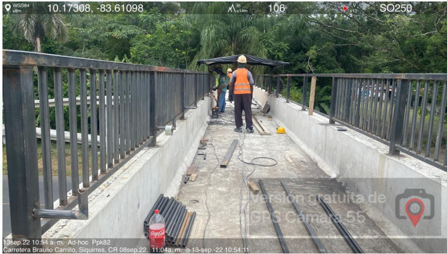
Puente peatonal Km 82+669
