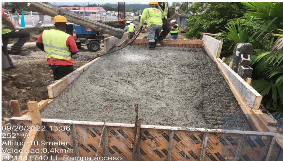
Puente peatonal Km 144+740
