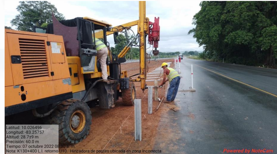
Colocación de la barrera Flex Beam en el retorno del Km 130+400, Lado izquierdo
