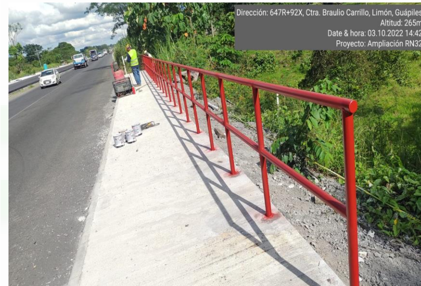
Puente 6 Km 64+884, Río Molinos
