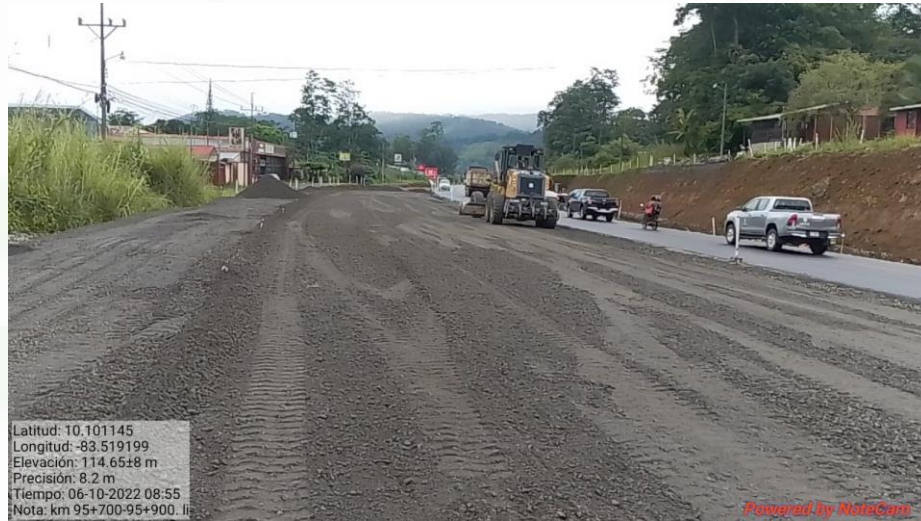
Extendido de capa de base granular en Km 95+700 al 95+900, Lado izquierdo
