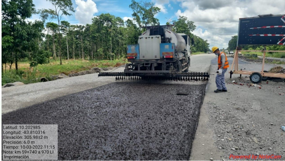
Riego de emulsión para imprimación en Km 59+740 al 59+970, Lado izquierdo
