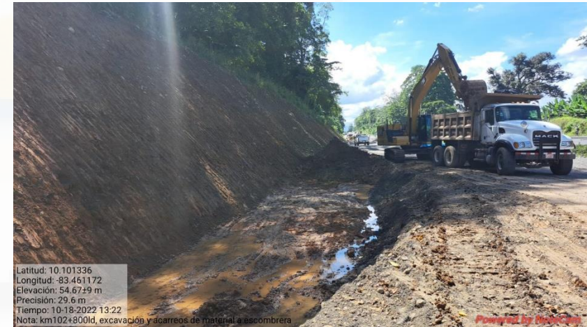
Excavación y terracería en Km 102+800, Lado derecho
