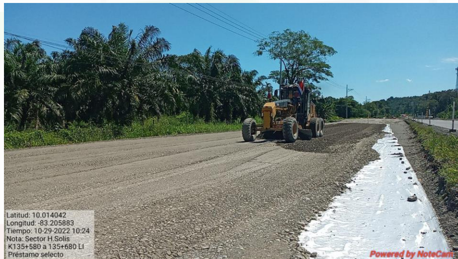
Extendido de capa de base granular en Km 135+580 al 135+680, Lado izquierdo
