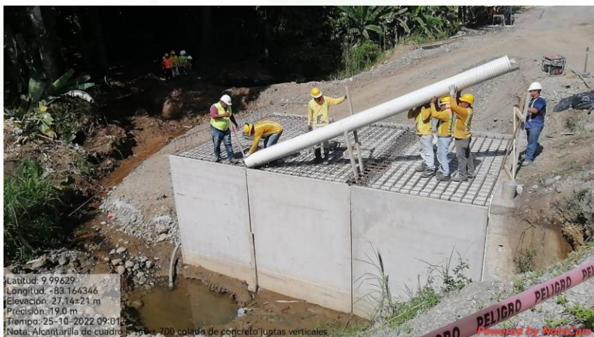
Alcantarilla de cuadro Km 140+700, Lado izquierdo
