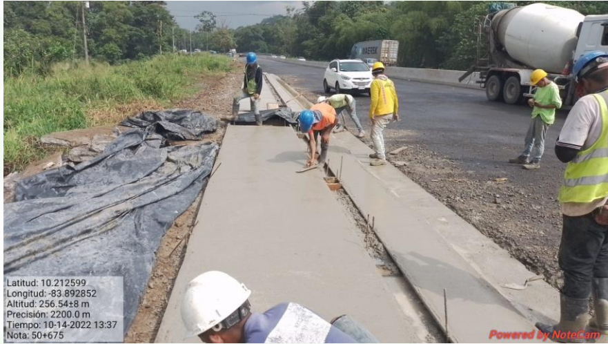
Construcción de aceras Km 50+675, Lado izquierdo
