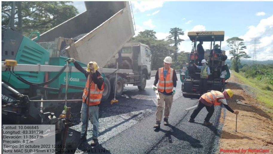
Colocación de capa de mezcla asfáltica en caliente, Km 120+630 al 120+804, Lado izquierdo
