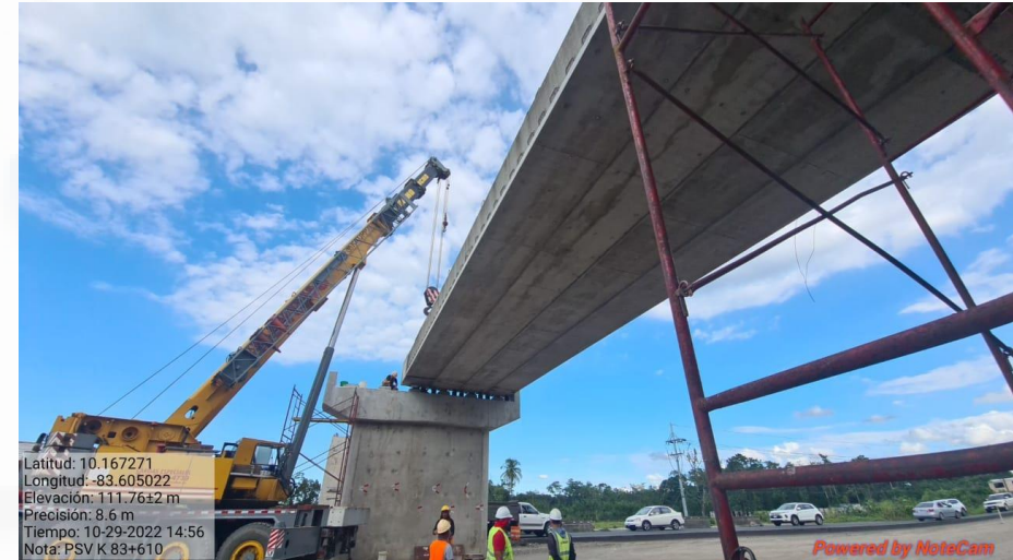
Paso Superior Vehicular Km 83+601
