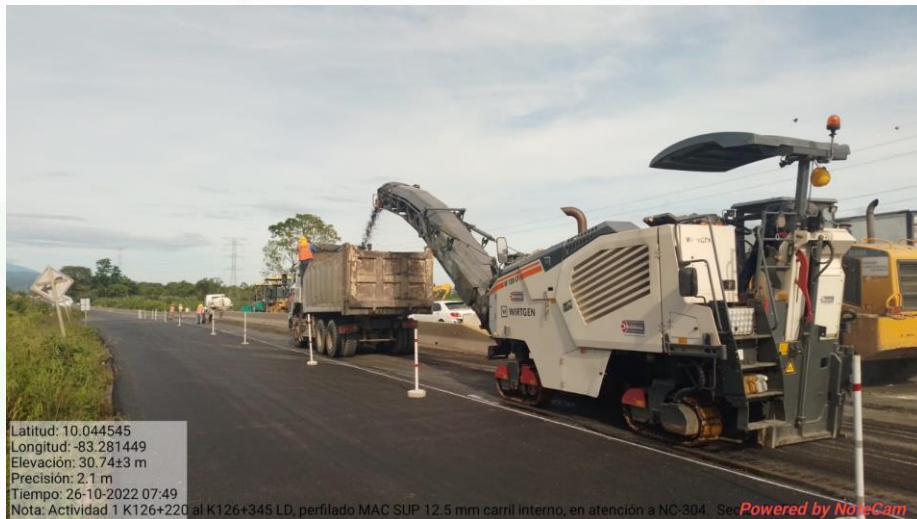
Deconstrucción de capa de asfalto existente, Km 126+220 al 126+345, Lado izquierdo
