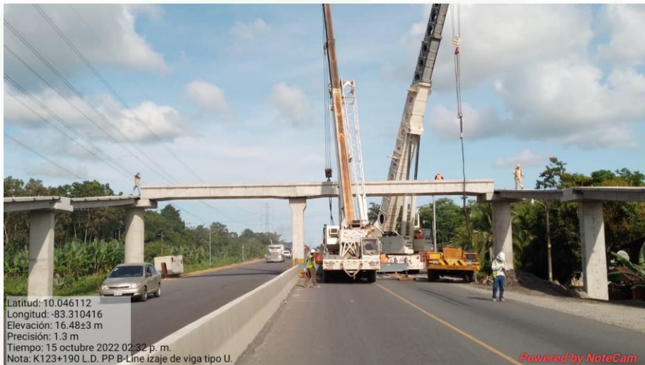
Puente peatonal Km 123+190
