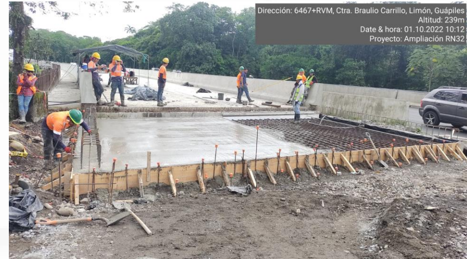
Puente 1 K50+975, Río Corinto
