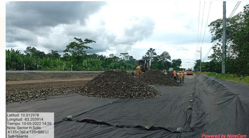
Relleno en Km 135+760 al 135+880, Lado izquierdo
