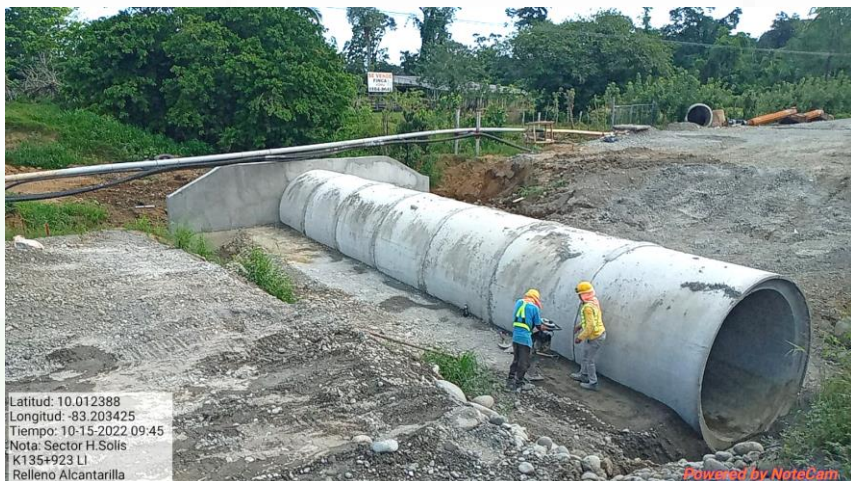
Alcantarilla tubular de concreto Km 135+923, Lado izquierdo
