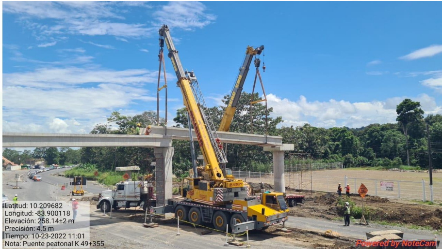
Puente peatonal Km 49+355
