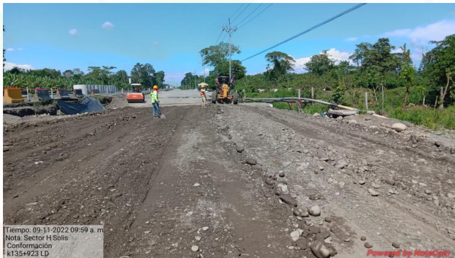
Extendido de capa de base granular en Km 135+923, Lado derecho
