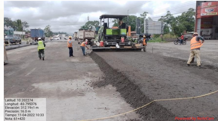
Colocación de capa de base estabilizada con cemento Km 61+420, Lado izquierdo
