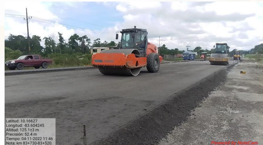
Compactación de capa de base estabilizada con cemento Km 83+730 al 83+520, Lado derecho
