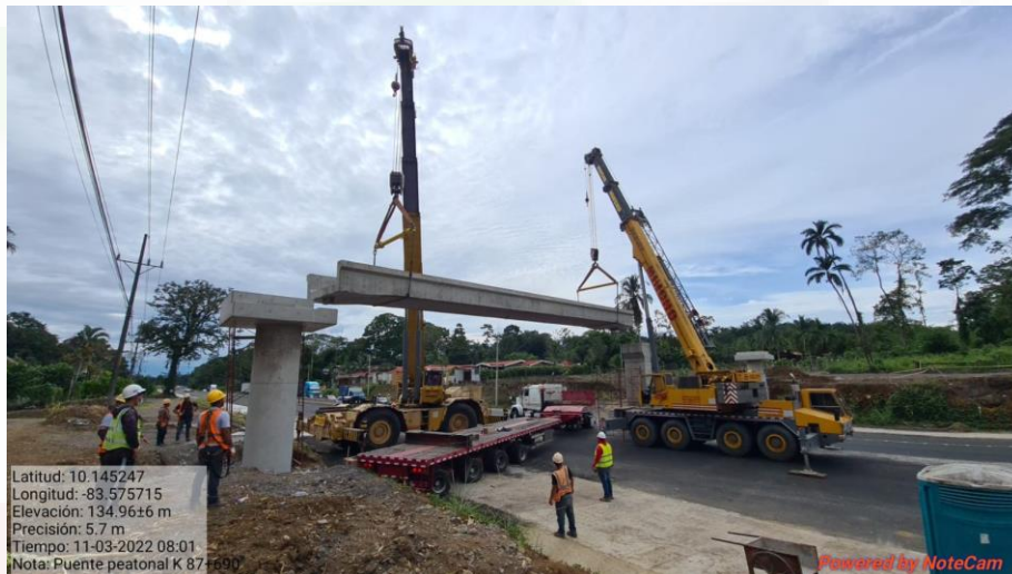
Puente peatonal Km 87+690
