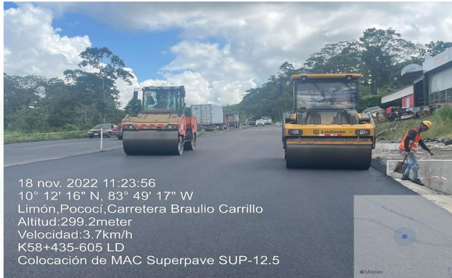
Compactación de capa de mezcla asfáltica en caliente, Km 58+435 al 58+605, Lado derecho
