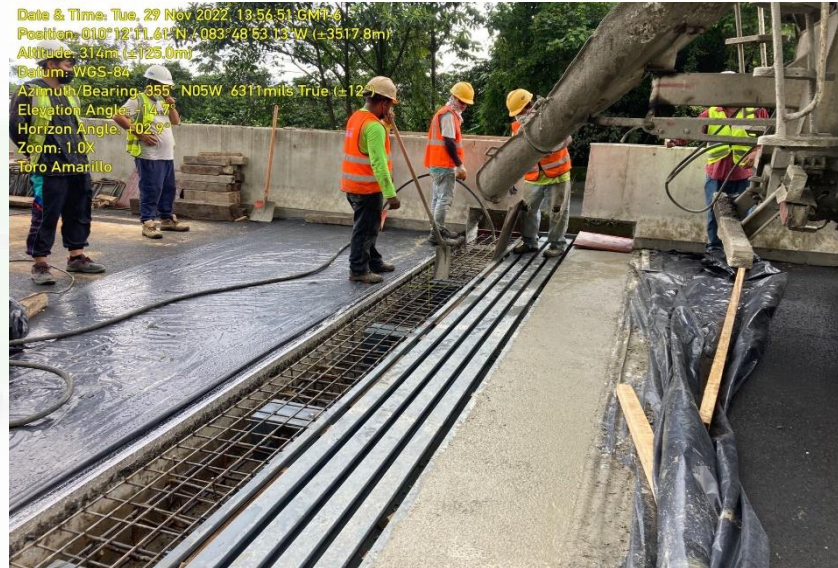
Puente 5 Km 59+124, Río Toro Amarillo
