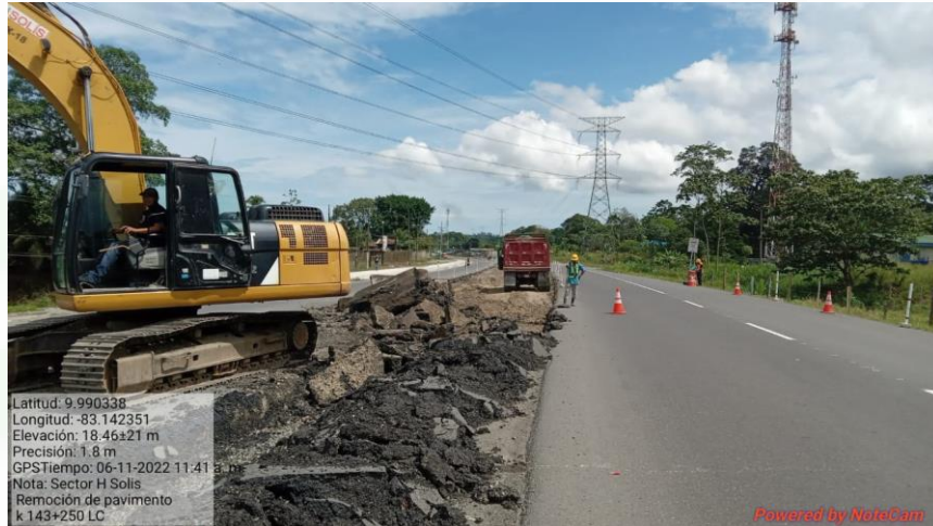
Deconstrucción de capa de asfalto existente, Km 143+250, Lado central
