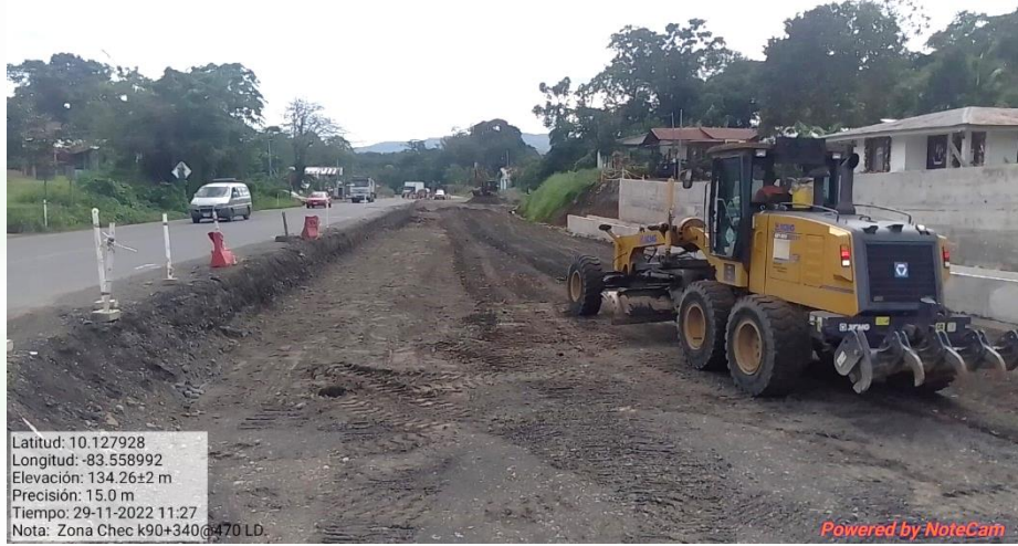
Extendido de capa de base granular en Km 90+340 al 90+470, Lado derecho
