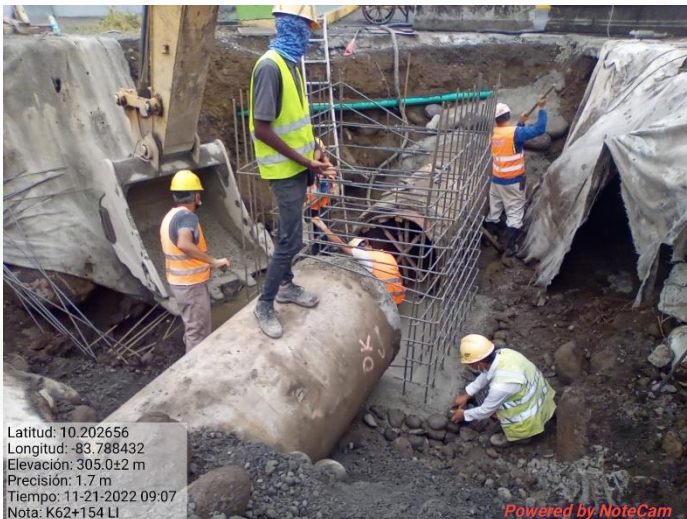
Alcantarilla tubular de concreto Km 62+154, Lado izquierdo
