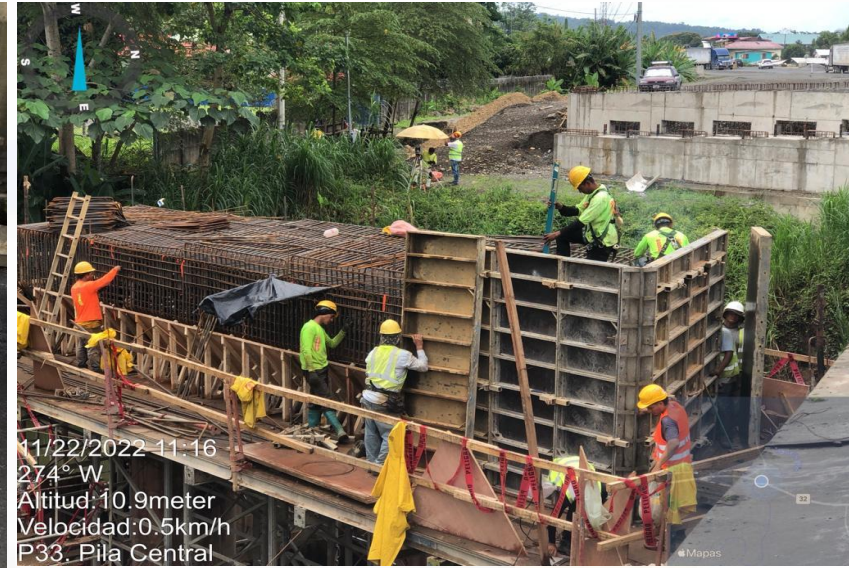
Puente 33 Km 145+145, Río Blanco
