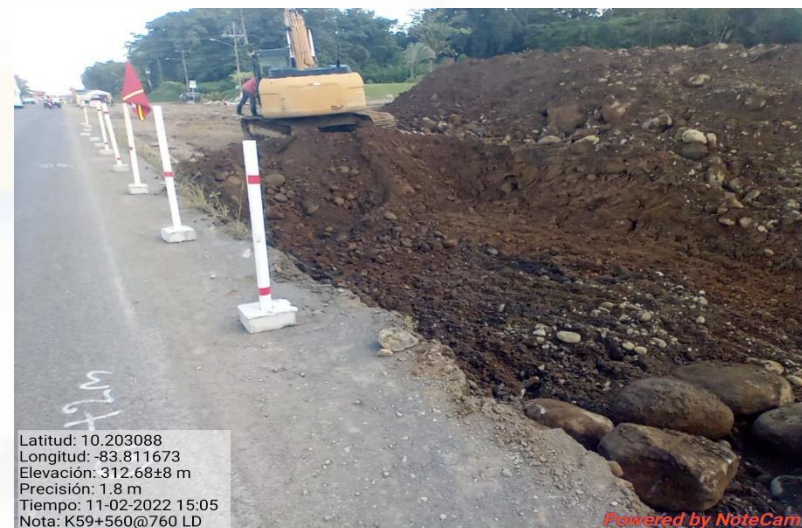
Excavación y terracería en Km 59+560 al 59+760, Lado derecho
