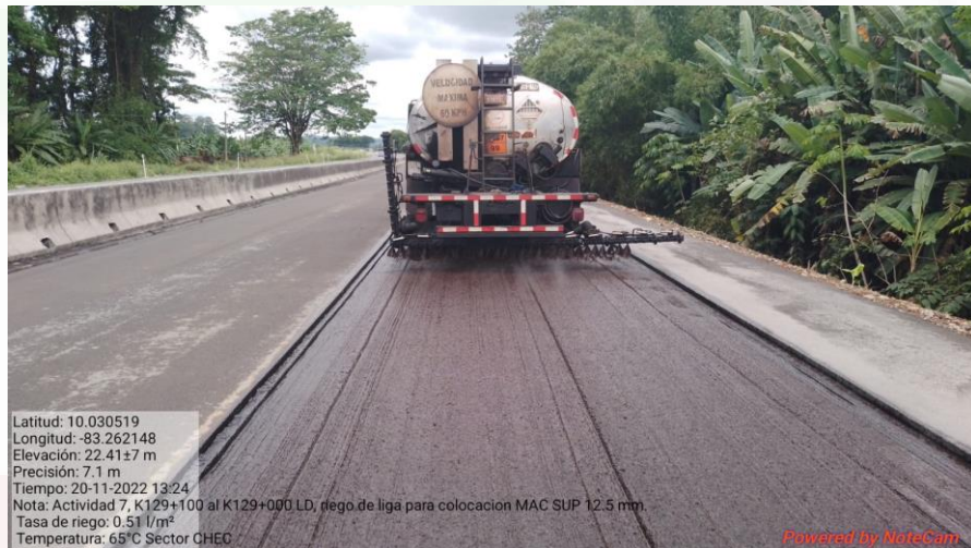
Riego de emulsión para imprimación en Km 129+100, Lado derecho
