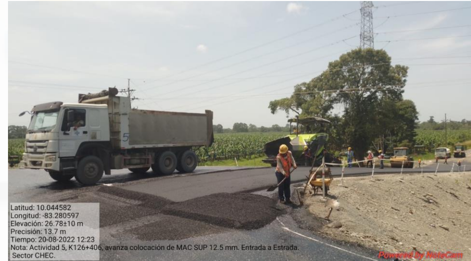
Colocación de capa de mezcla asfáltica en caliente del acceso 126+400, Lado izquierdo
