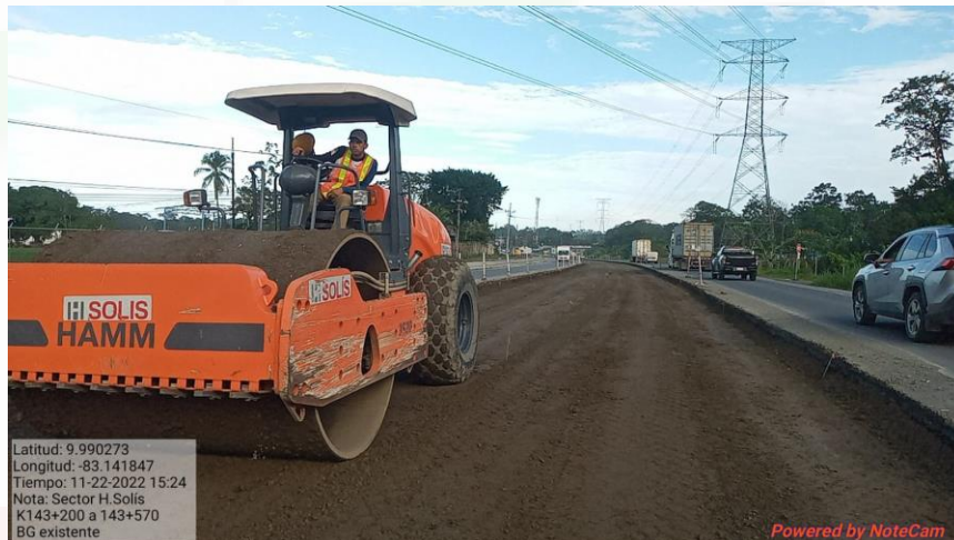
Deconstrucción de capa de asfalto existente, Km 143+850 al 143+750, Lado central
