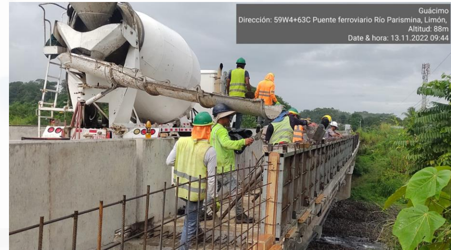
Puente 11 Km 78+187, Río Parismina
