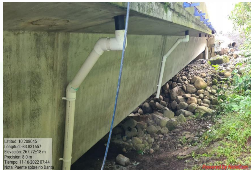
Puente 4 Km 57+334, Río Danta
