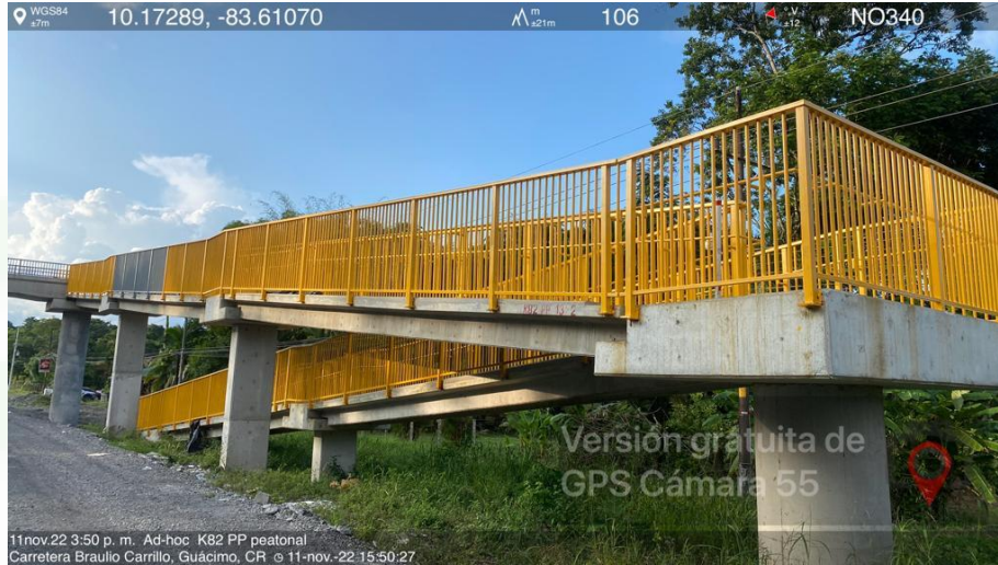
Puente peatonal Km 82+690
