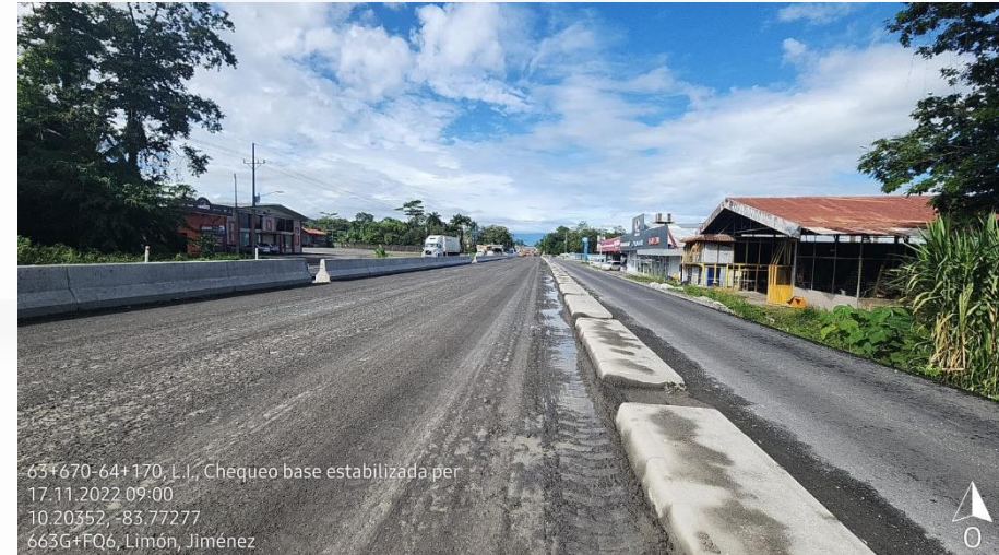
Asfaltado de la calle marginal Km 92+500 al 91+000. Lado izquierdo
