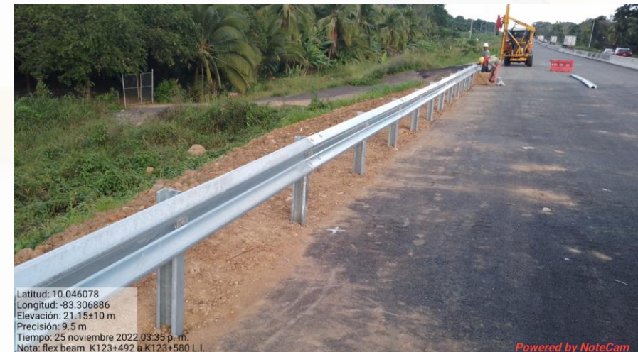
Colocación de la barrera Flex Beam en el retorno del Km 123+492, Lado izquierdo
