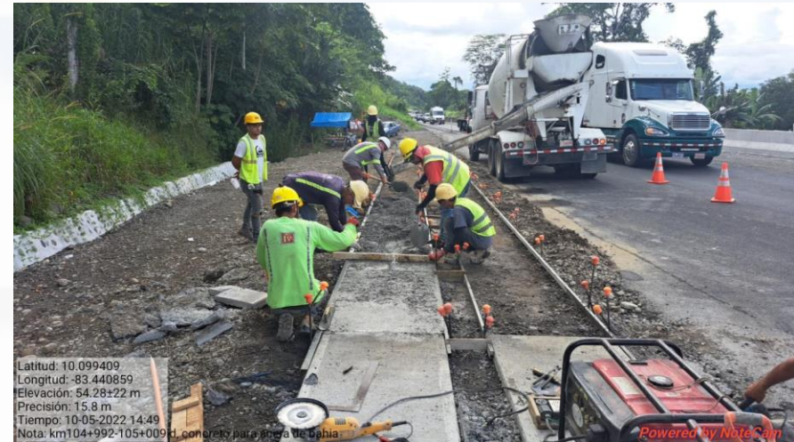
Vertido de concreto de la acera de la bahía de autobús Km 104+992 al 105+009, Lado derecho
