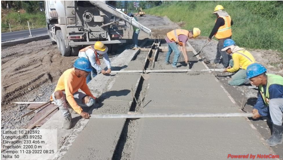
Construcción de aceras Km 50+675, Lado izquierdo
