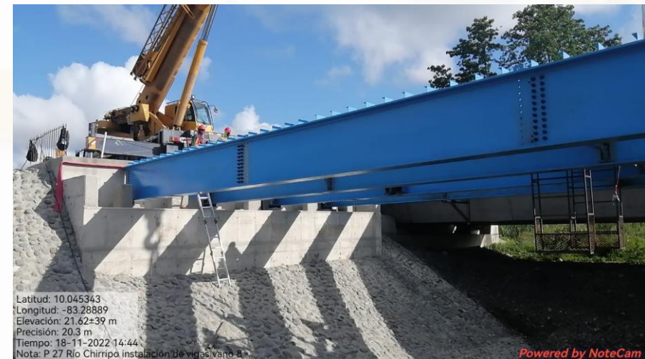
Puente 27 Km 125+309, Río Chirripó
