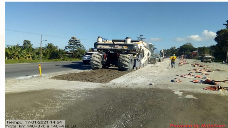
Colocación de base estabilizada en Km 140+370 – 140+470 LD
