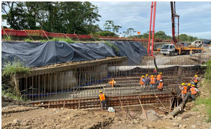
Alcantarilla de cuadro Km 81+399
