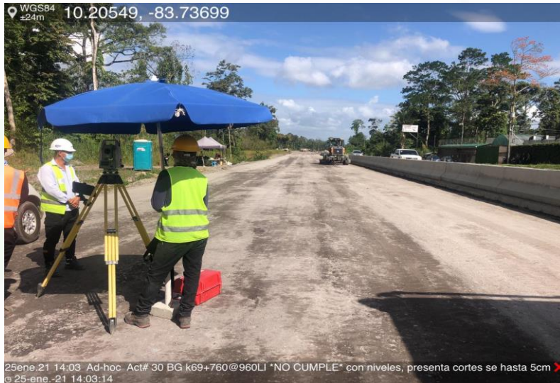
Perfilado de la capa existente de pavimento Km 69+760 LI
