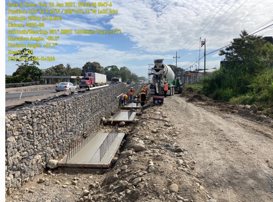
Trabajos en los gaviones del IC 62+890
