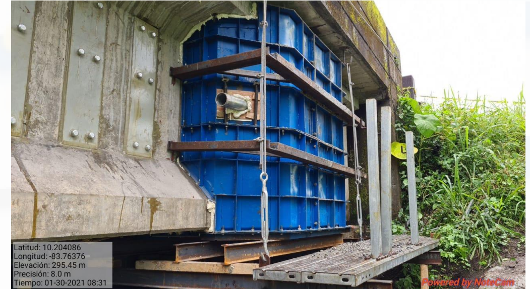
Puente 6 Km 64+884,60, Río Molinos
