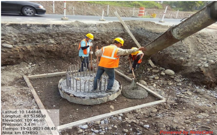
Puente peatonal Km 87+690
