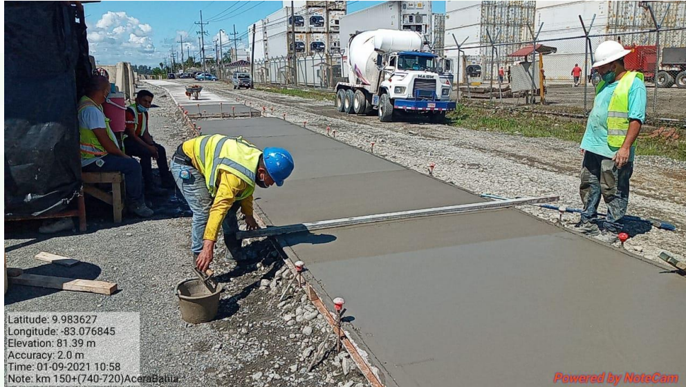
Construcción de aceras Km 150+740
