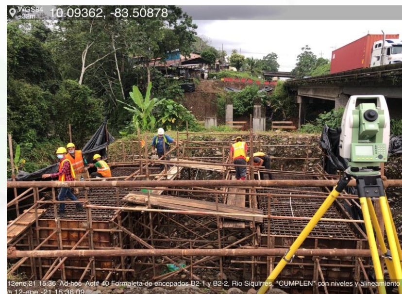
Puente 17 Km 97+118,30, Río Siquirres
