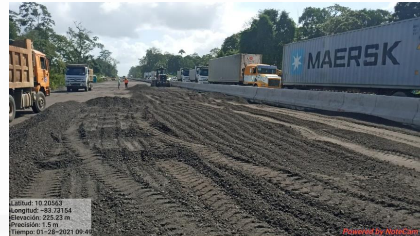
Colocación de capa de geomalla en Km 69+000 LI
