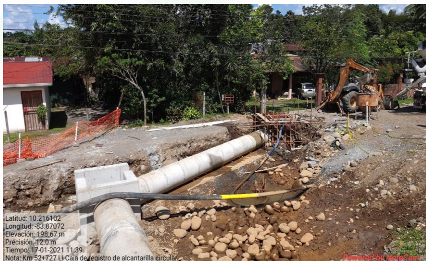
Alcantarilla tubular de concreto Km 52+727
