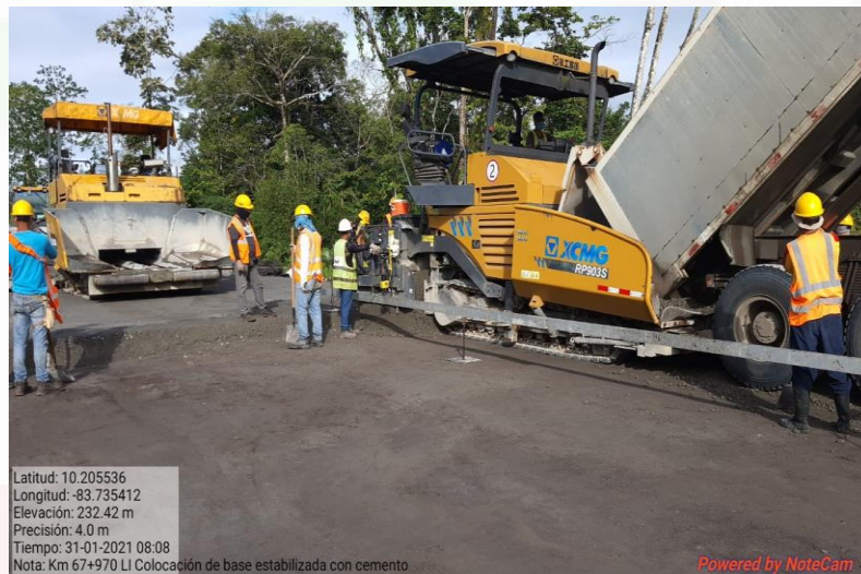
Rehabilitación de la carretera existente Km 69+970 LI
