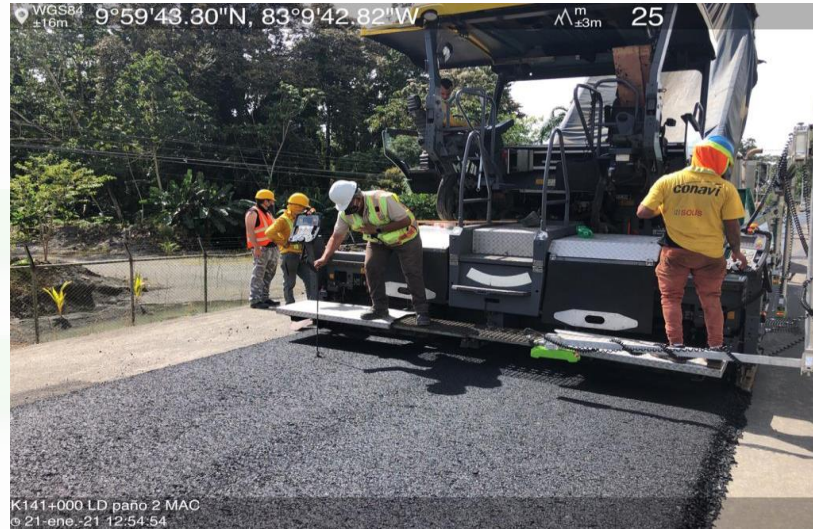
Colocación de capa asfáltica en caliente Km 141+000 LD
