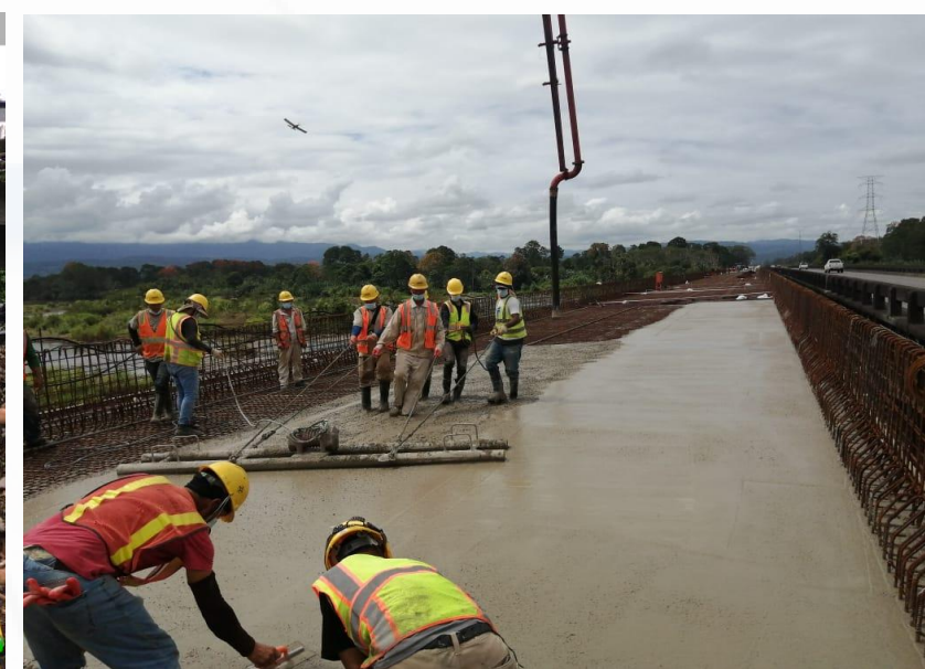
Puente 27: Km 125+309,60 Río Chirripó
