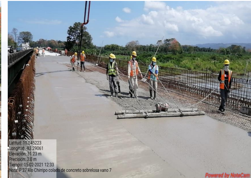
Puente 27: Km 125+309,60 Río Chirripó
