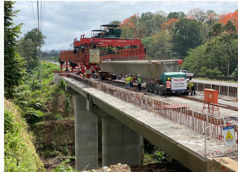
Puente 13 Km 84+269,70, Río Destierro
