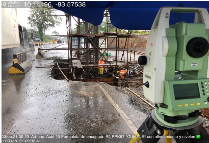
Puente peatonal Km 87+690
