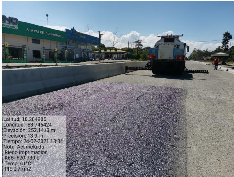
Riego de imprimación Km 66+620 al 66+780 LI
