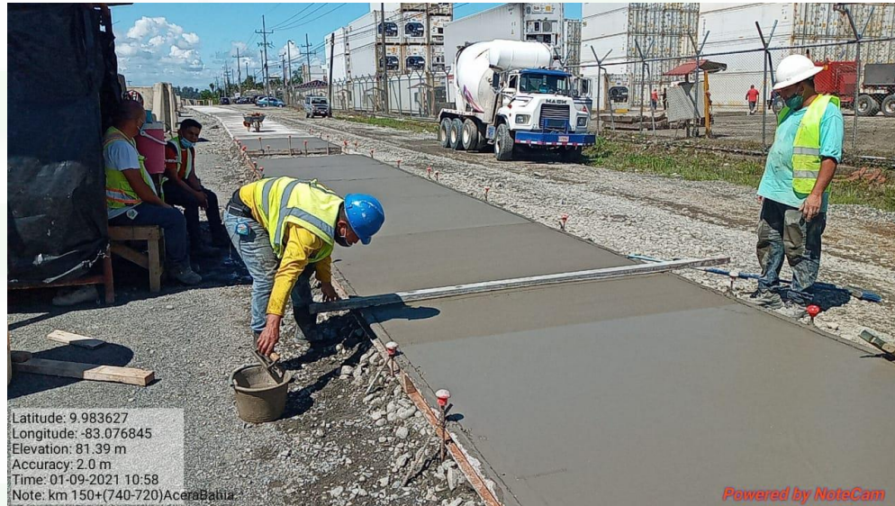
Construcción de aceras Km 150+740
