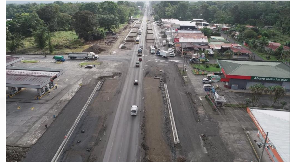
Trabajos en el IC 62+890
