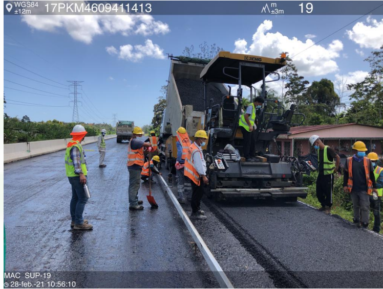
Colocación de capa asfáltica en caliente Km 122+000 LD
