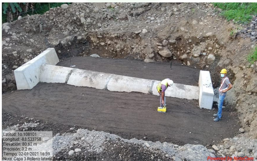
Alcantarilla tubular de concreto Km 93+928
