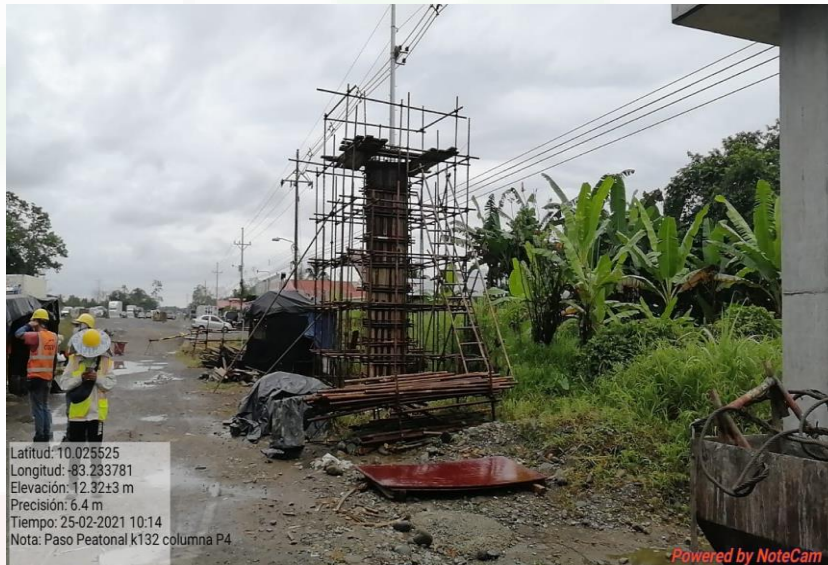
Puente peatonal Km 132+213
