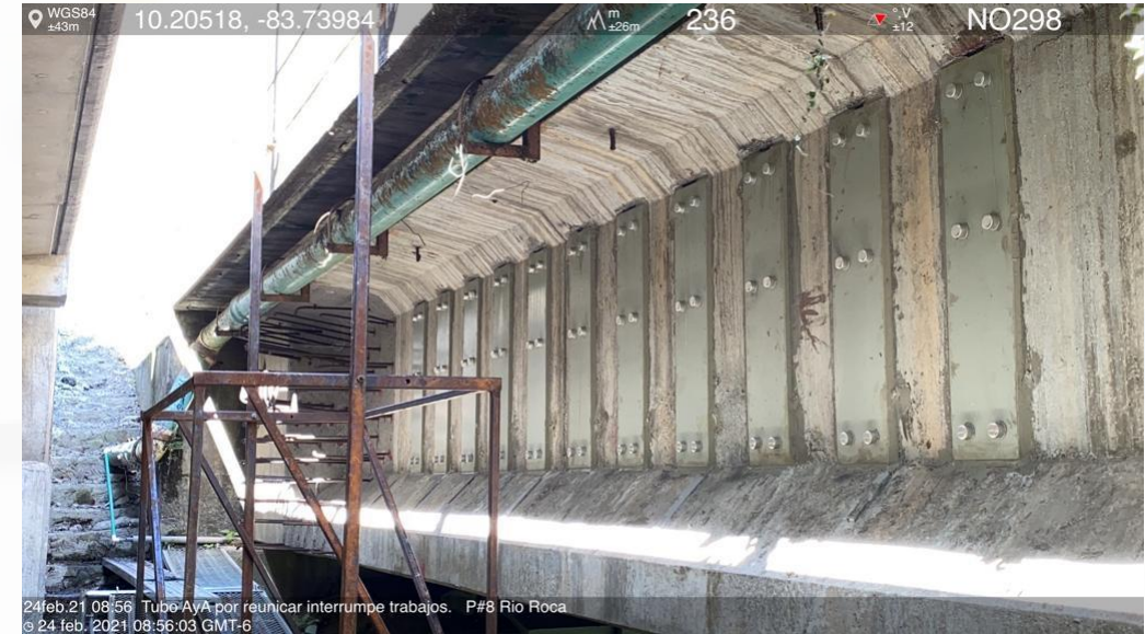
Puente 8 Km 67+508,60, Río Roca
