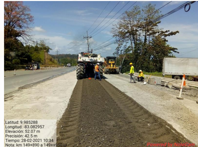
Colocación de base estabilizada en Km 149+890 – 149+950 LI
