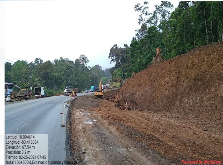
Excavación común y limpieza del derecho de vía en Km 106+500
