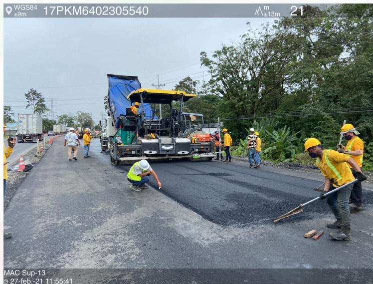
Colocación de mezcla asfáltica Km 143+000 LD
