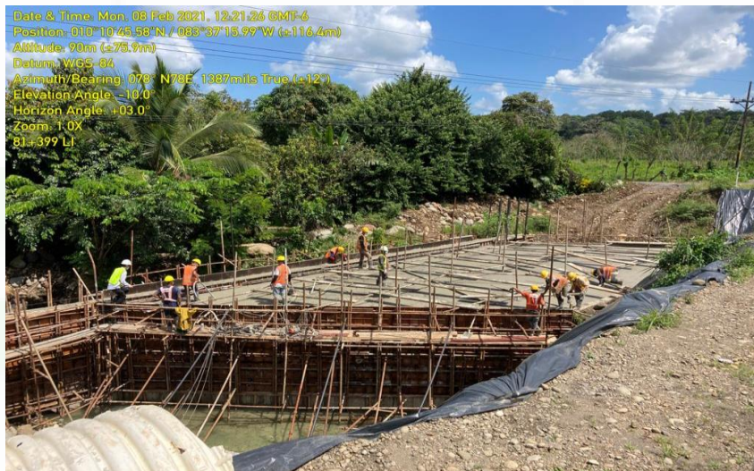
Alcantarilla de cuadro Km 81+399
