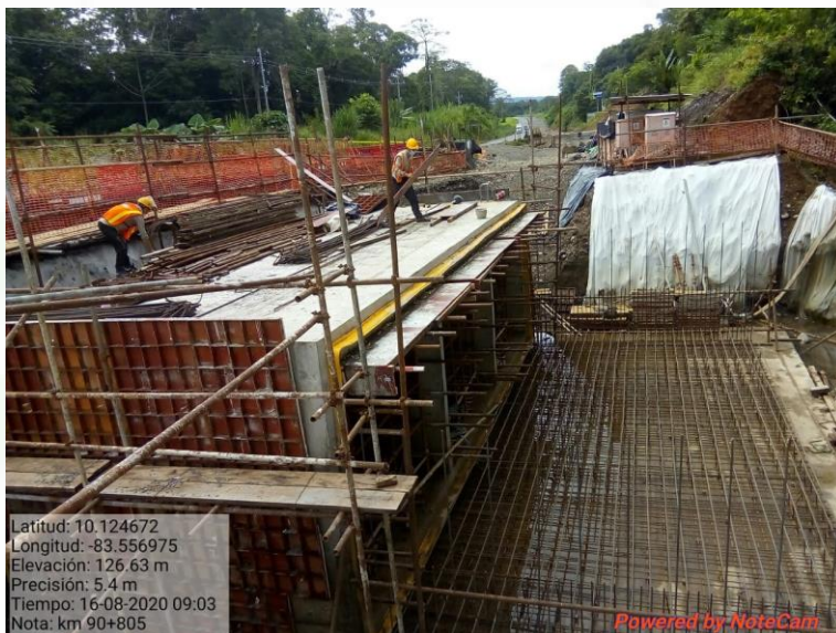
Alcantarilla de cuadro Km 90+805
