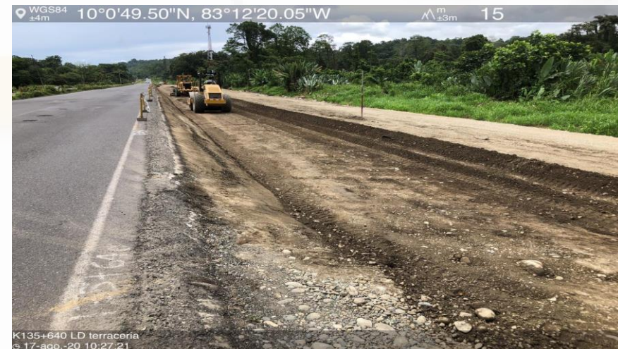
Trabajos de relleno en Km 134+000 LD
