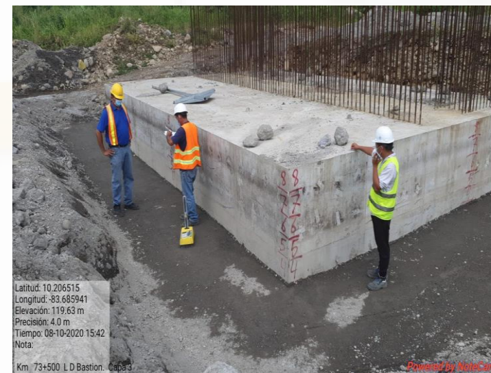
Bastión uno PSV Km 73+517
