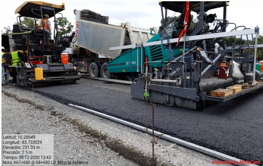
Colocación de capa asfáltica en caliente Km 67+680 al 68+680 LD
