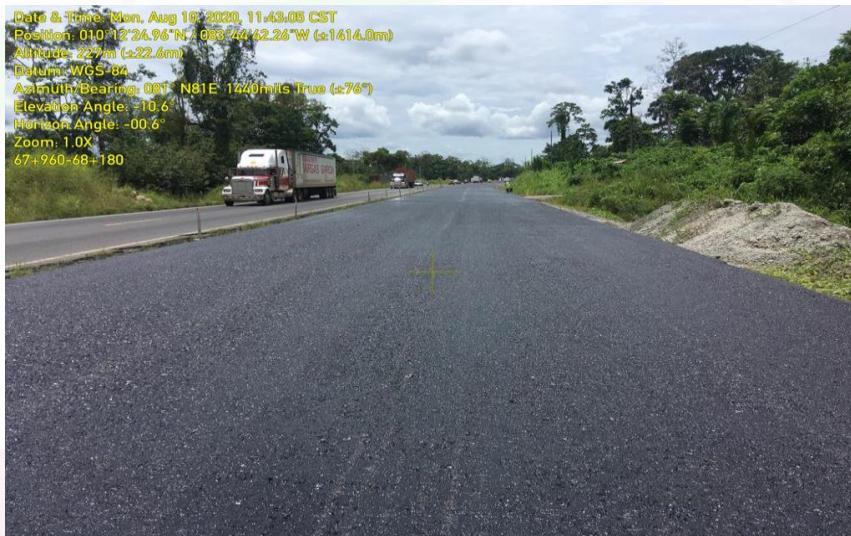
Mezcla asfáltica en Km 67+960 al 68+180 LD
