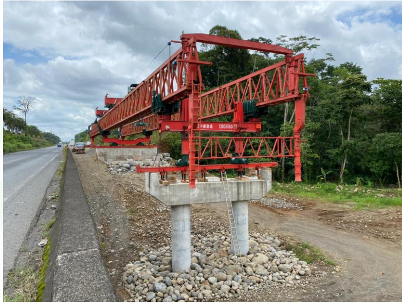
Puente 5: Km 59+124, Río Toro Amarillo
