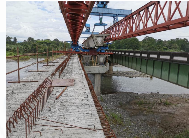
Puente 27: Km 125+309 Río Chirripó
