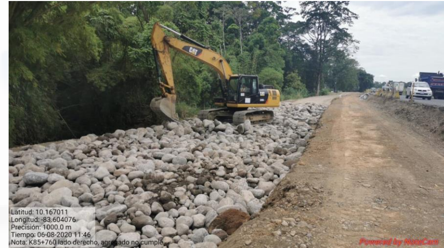
Trabajos de relleno en Km 85+760 LD
