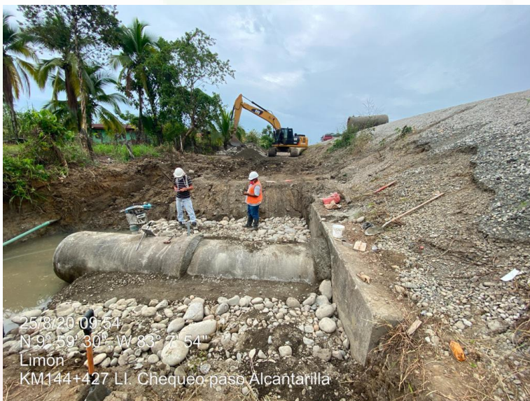
Alcantarilla tubular de concreto Km 144+427
