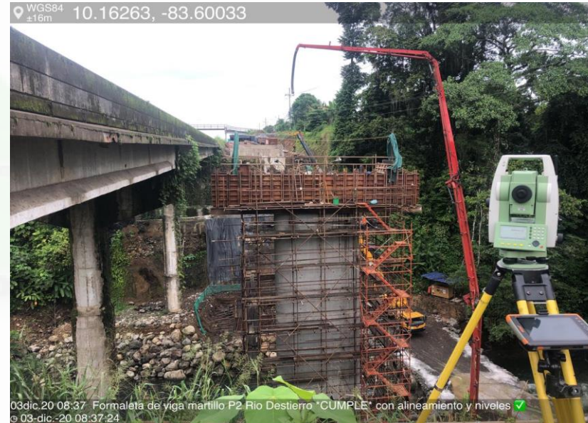
Puente 13 Km 84+269,70, Río Destierro
