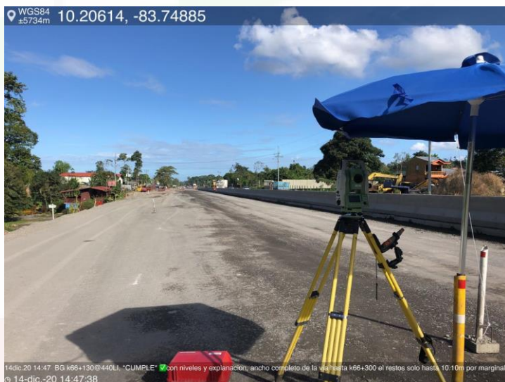
Rehabilitación de la carretera existente Km 66+130 LI
