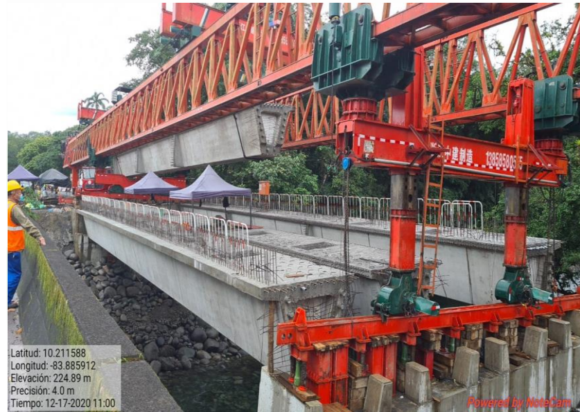
Puente 1: Km 50+975,80, Río Corinto
