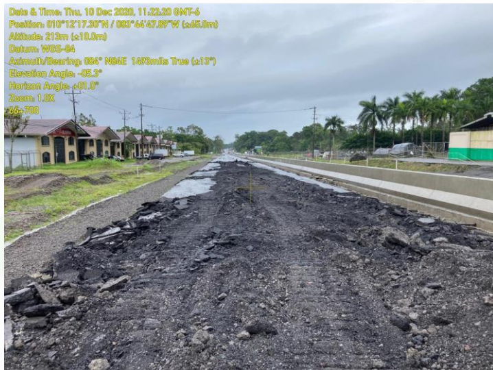
Perfilado de la capa existente de pavimento Km 66+700 LI
