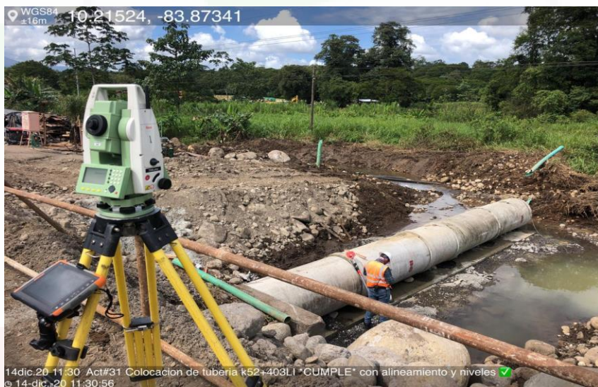
Alcantarilla tubular de concreto Km 52+403
