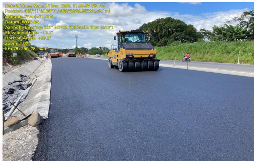
Compactación de capa de mezcla asfáltica Km 78+250 LD
