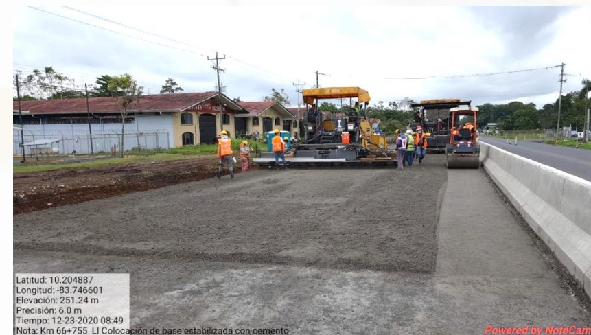
Colocación de base estabilizada en Km 66+755 LI
