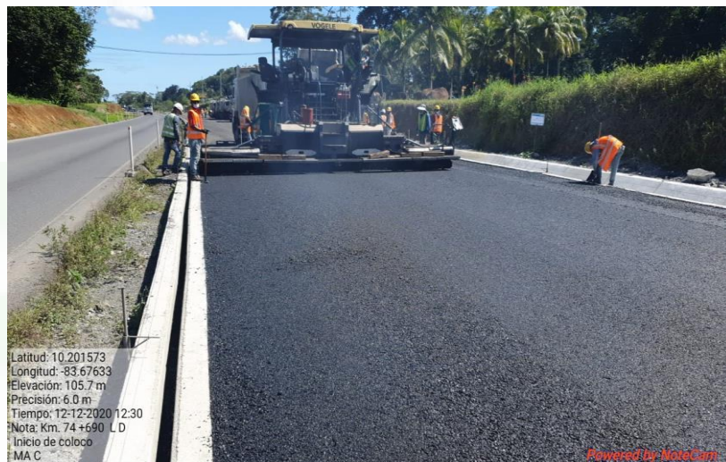
Colocación de capa asfáltica en caliente Km 74+600 LD
