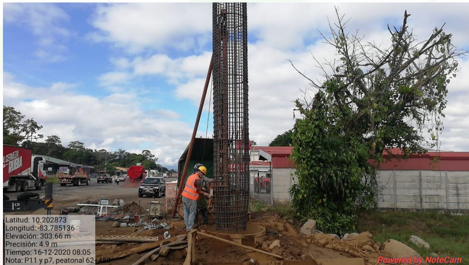
Puente peatonal Km 62+488
