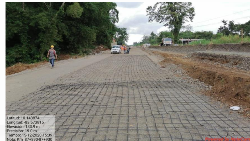
Colocación de capa de geomalla en Km 87+890 al 87+930 LD
