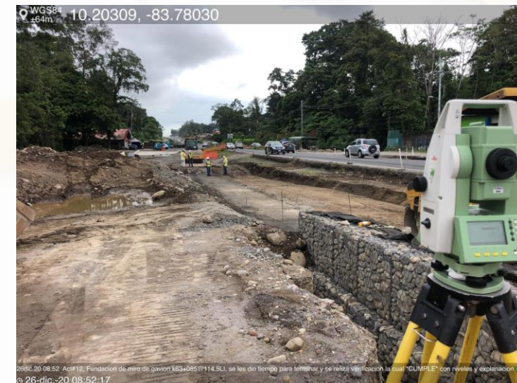
Trabajos en los gaviones del IC 62+890
