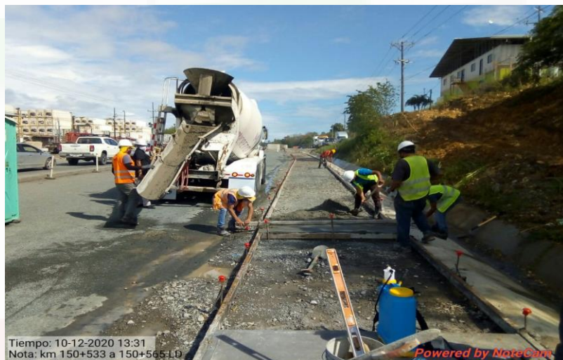
Construcción de aceras Km 150+533 al 150+565
