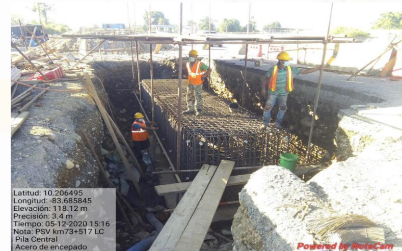
Trabajos de pila central del PSV Km 73+517
