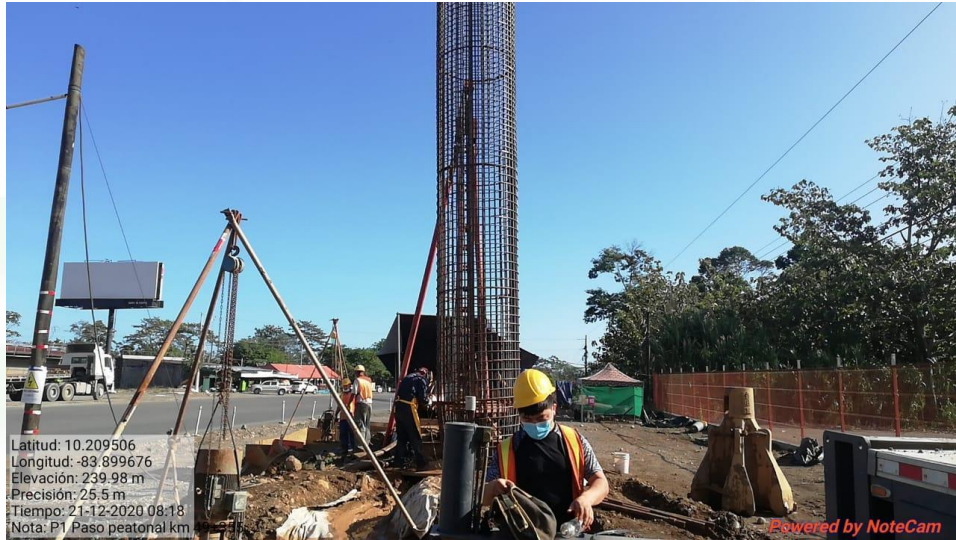
Puente peatonal Km 49+355
