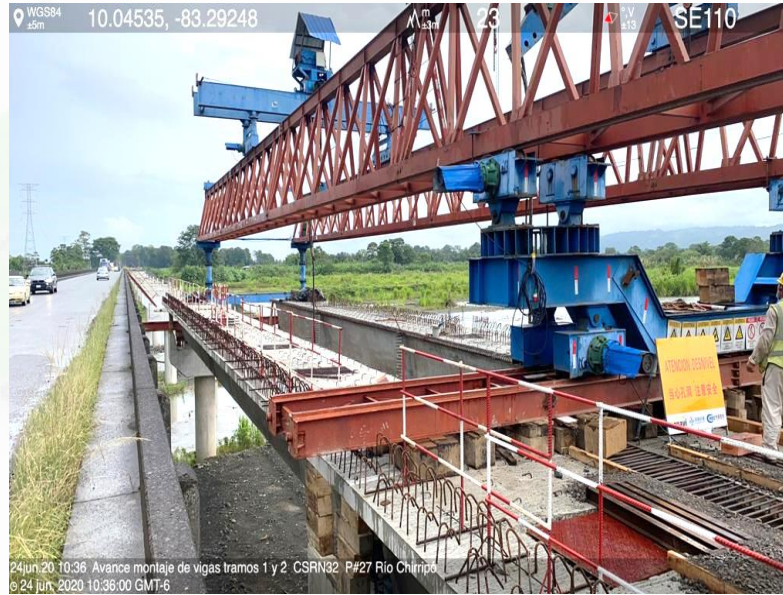
Puente 27: Km 125+309, Río Chirripó
