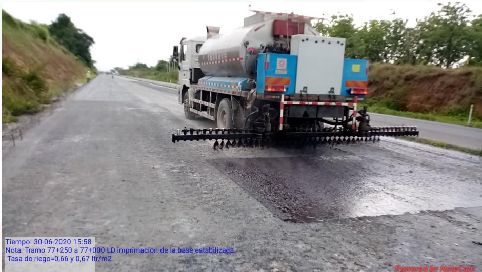
Riego con emulsión asfáltica en Km 77+250 al 77+600 LD
