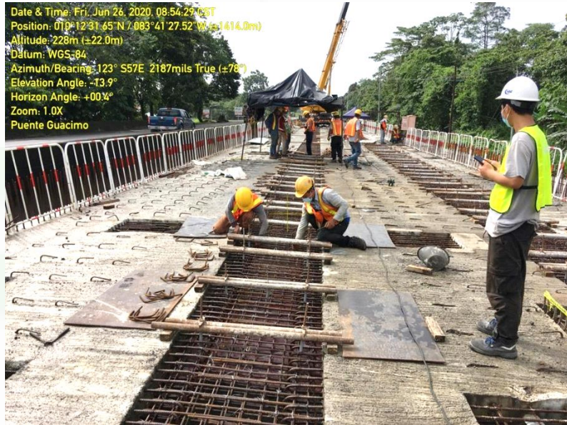
Puente 9: Km 73+755, Río Guácimo
