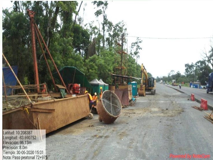
Puente peatonal Km 72+975
