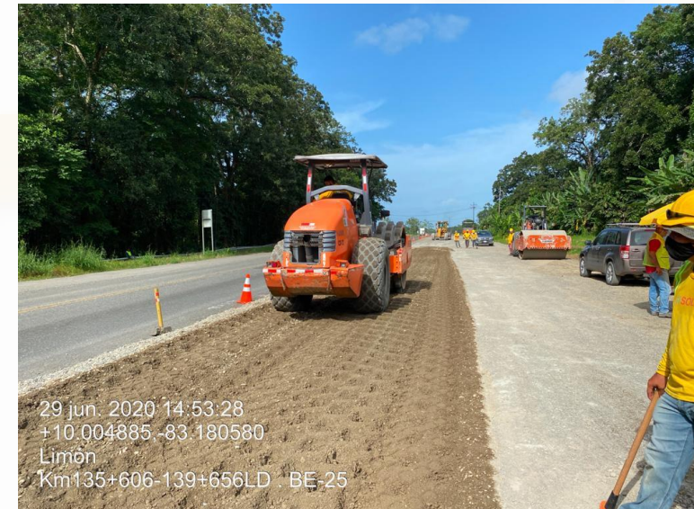
Trabajos de relleno en Km 135+606 LD
