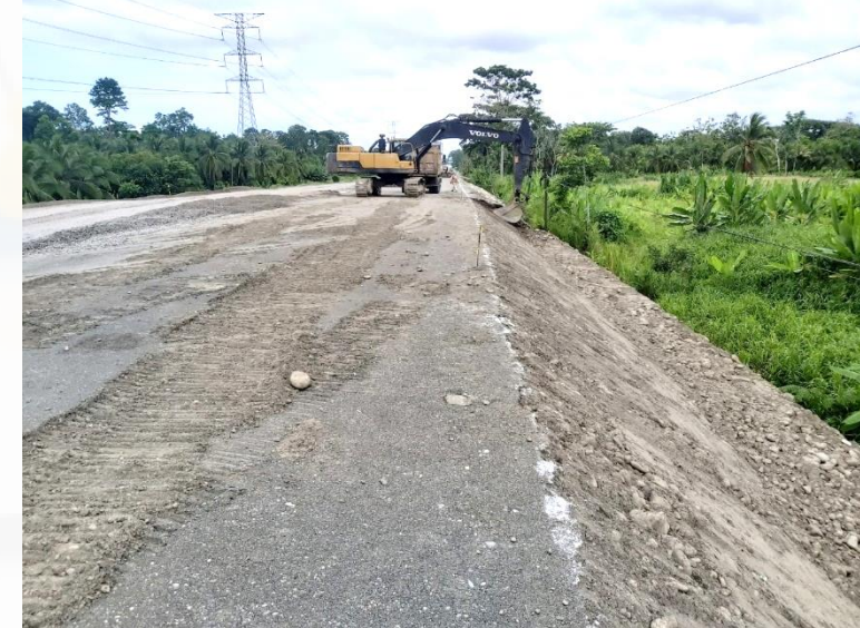
Trabajos de relleno en Km 123+000 LD
