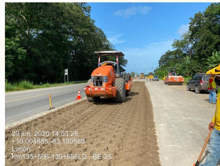
Trabajos de relleno en Km 135+606 LD
