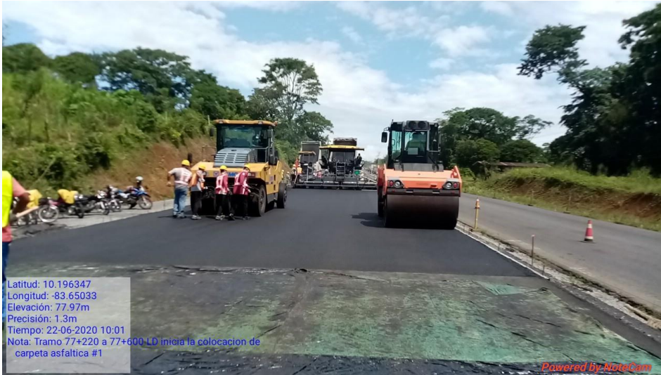
Colocación de capa asfáltica en caliente Km 77+220 al 77+600 LD
