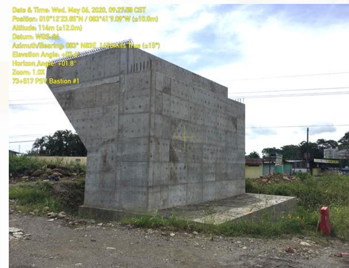
Bastión dos PSV Km 73+517
