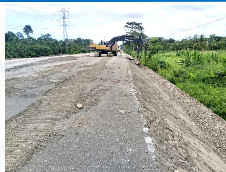
Trabajos de relleno en Km 123+000 LD
