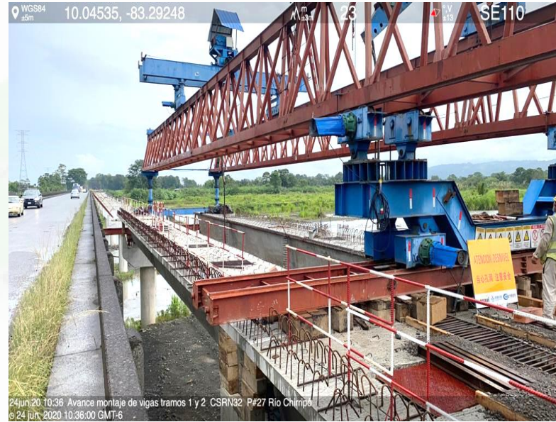
Puente 27: Km 125+309, Río Chirripó
