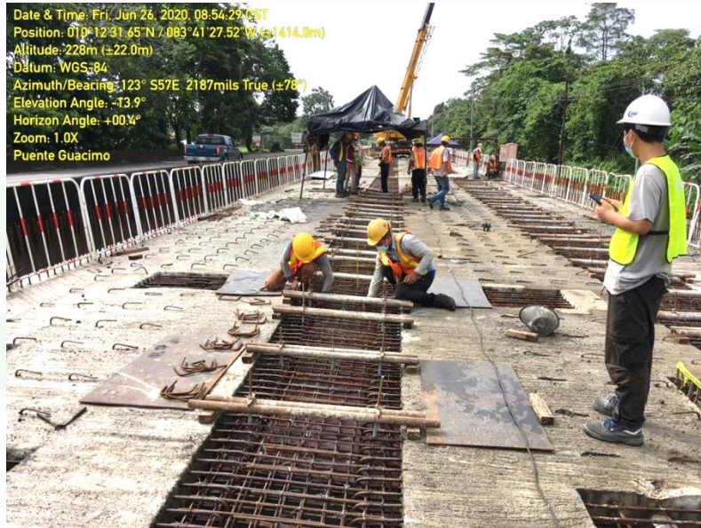
Puente 9: Km 73+755, Río Guácimo
