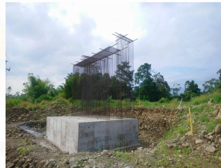
Bastión uno PSV Km 73+517
