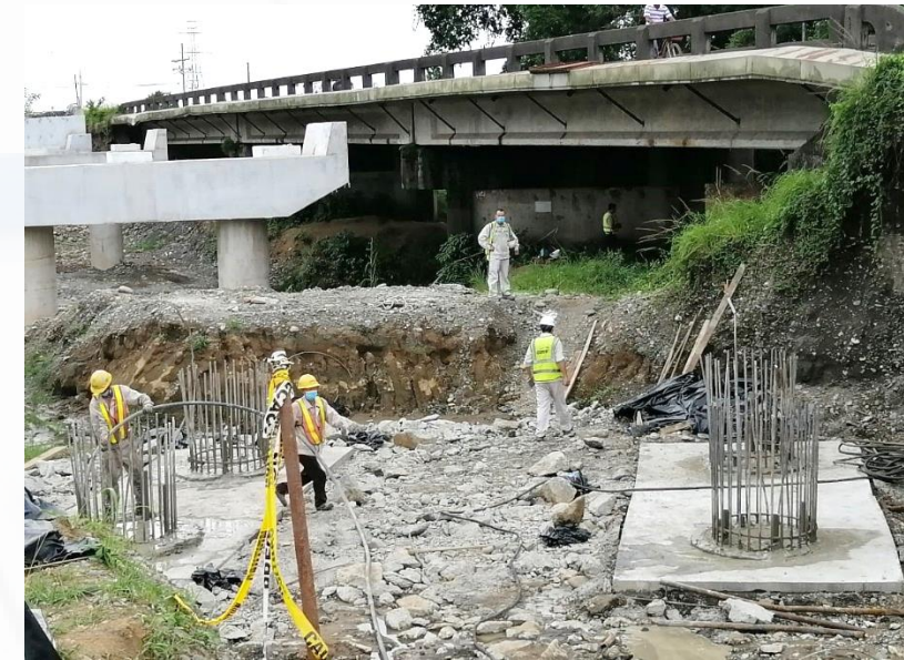
Puente 29: Km 133+950 Río Cuba
