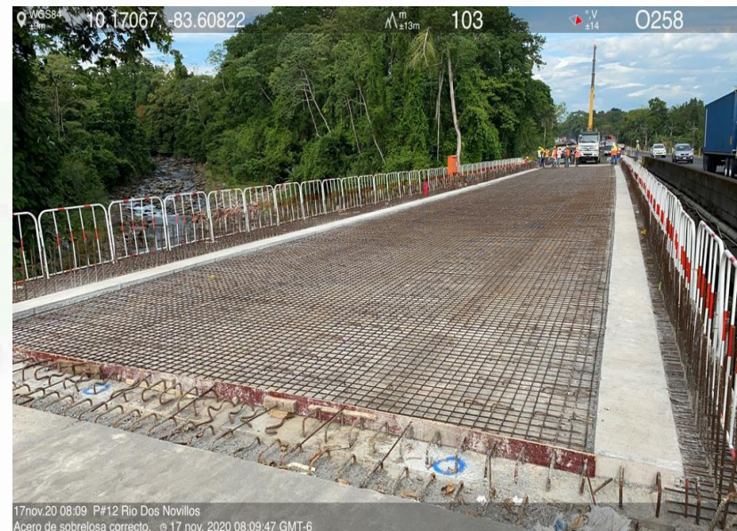
Puente 12: Km 83+035, Río Dos Novillos
