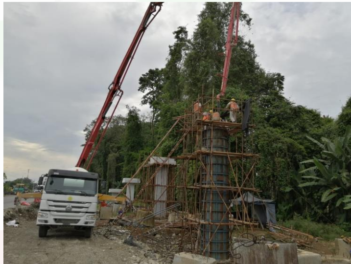
Puente peatonal Km 132+213
