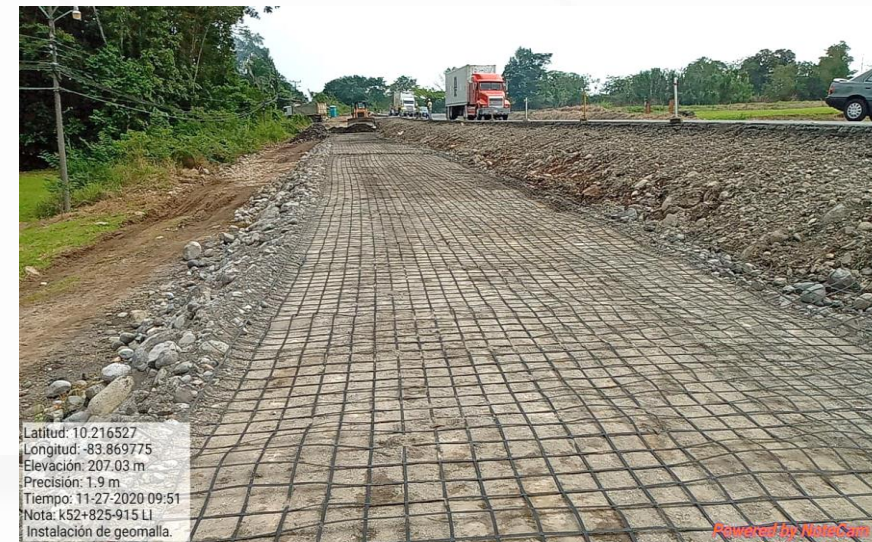
Colocación de capa de geomalla en Km 52+825 LI
