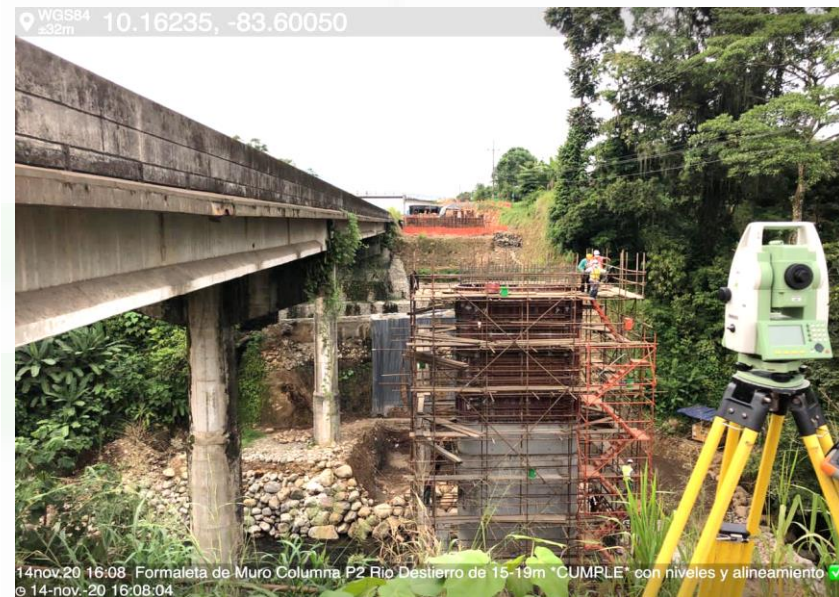
Puente 13: Km 84+269, Río Destierro
