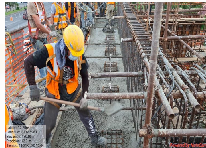
Trabajos de pila central del PSV Km 73+517
