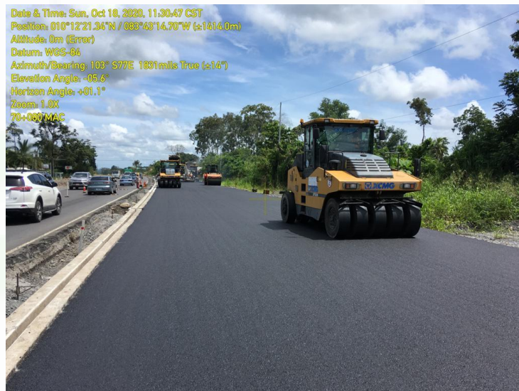
Colocación de capa asfáltica en caliente Km 70+080
