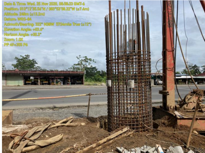
Puente peatonal Km 49+355
