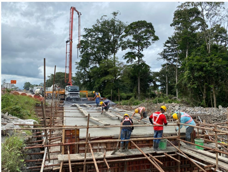
Alcantarilla de cuadro Km 63+167
