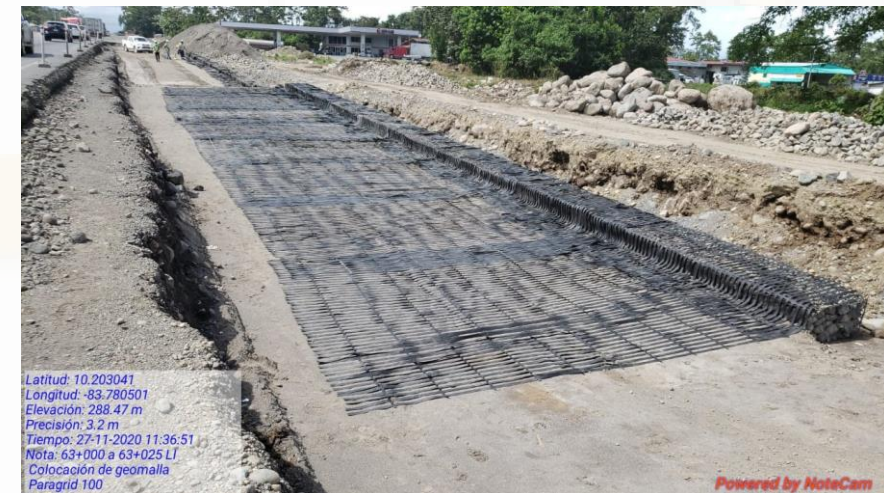
Trabajos en los gaviones del IC 62+890
