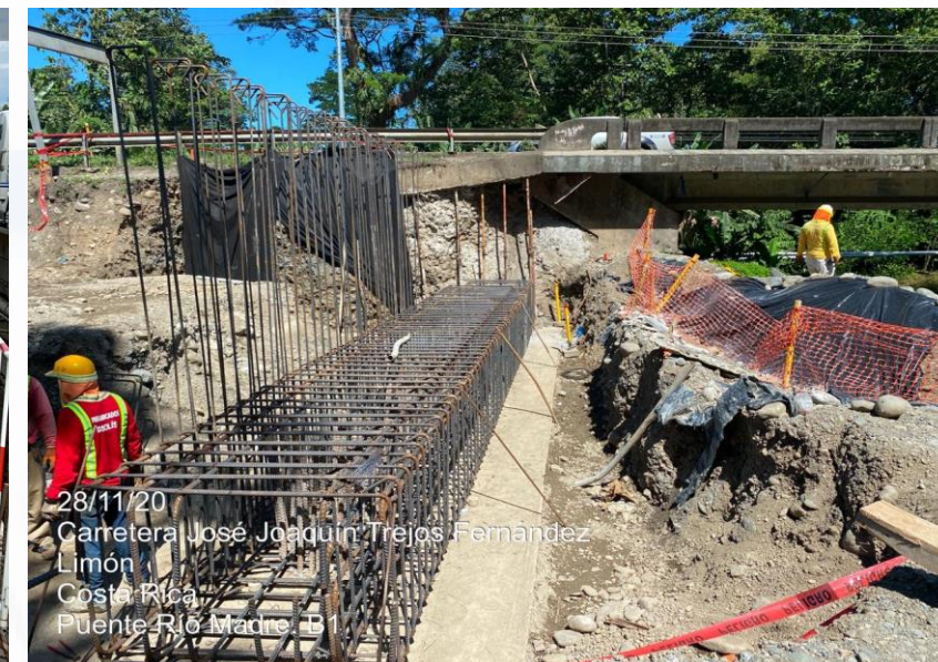
Puente 32: Km 141+278, Río Madre
