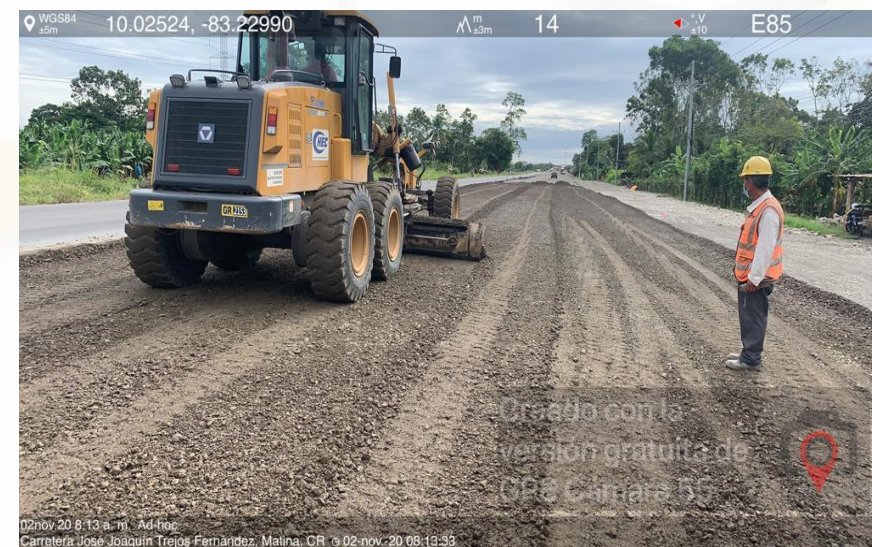
Colocación de base estabilizada en Km 132+780 LD
