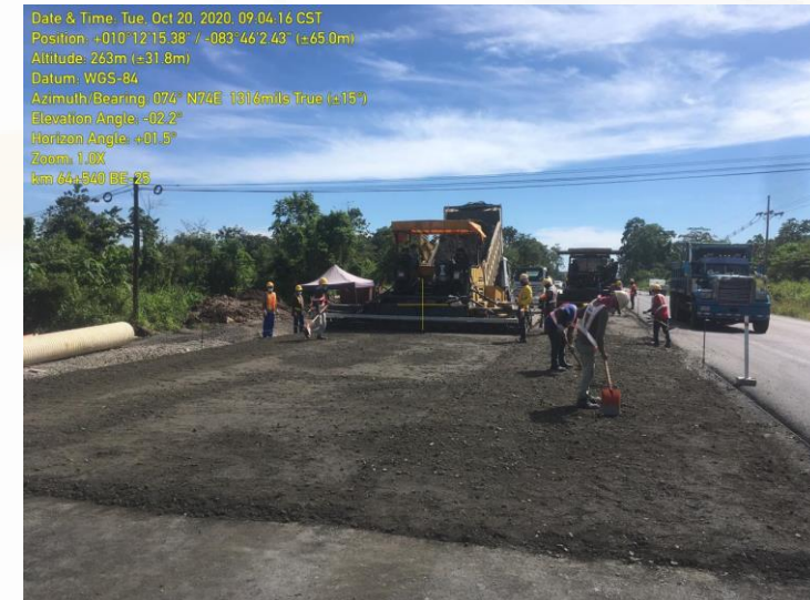
Colocación de base estabilizada en Km 64+540 LD
