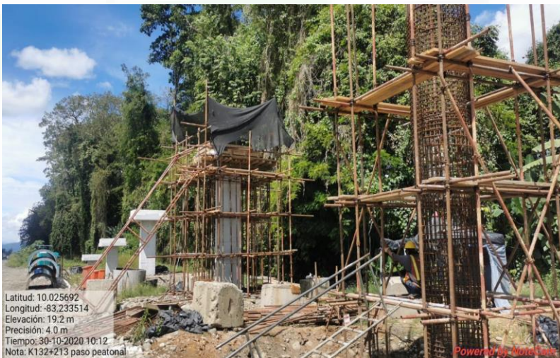
Puente peatonal Km 132+213
