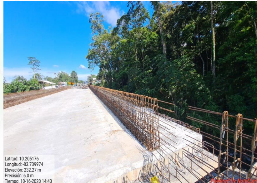
Puente 8: Km 67+508,60, Río Roca
