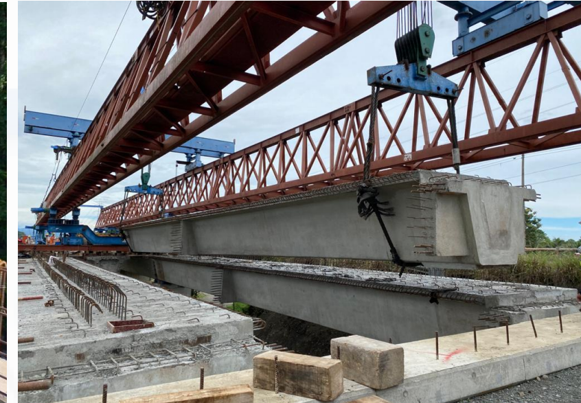
Puente 27: Km 125+309,60, Río Chirripó
