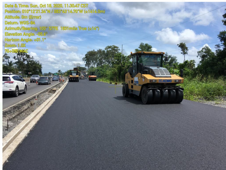
Colocación de capa asfáltica en caliente Km 70+080
