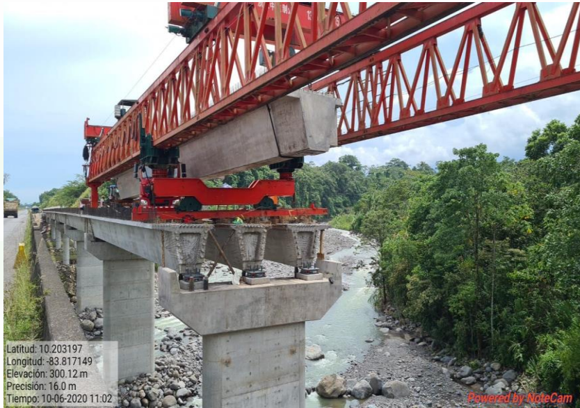
Puente 5: Km 59+124, Río Toro Amarillo
