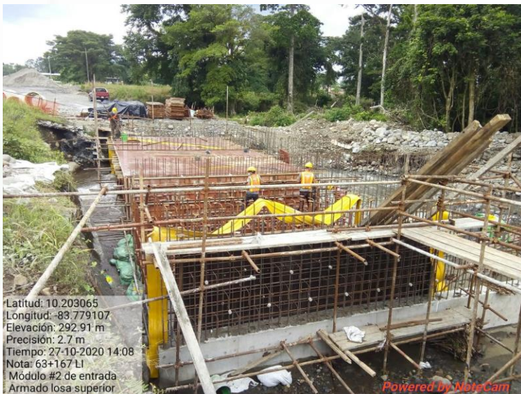
Alcantarilla de cuadro Km 63+167
