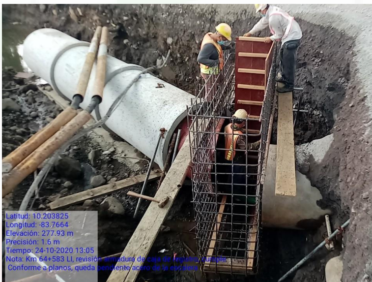
Alcantarilla tubular de concreto Km 64+583
