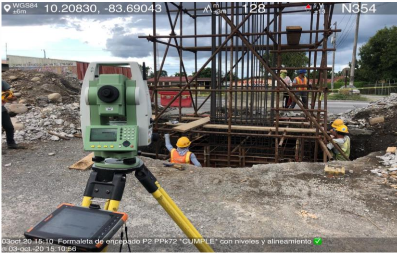
Puente peatonal Km 72+975
