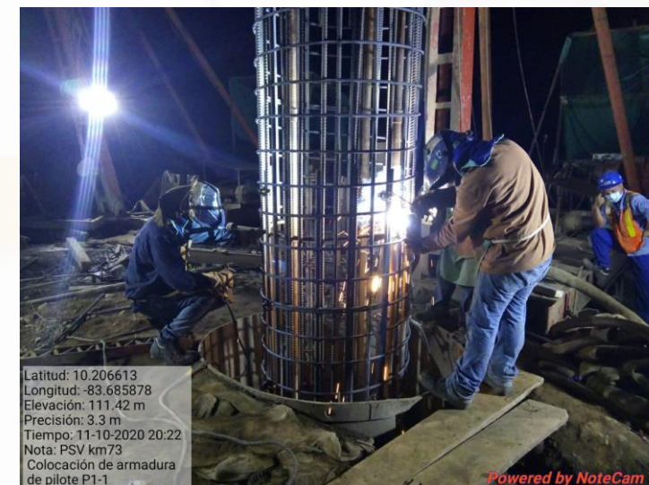
Trabajos de pila central del PSV Km 73+517
