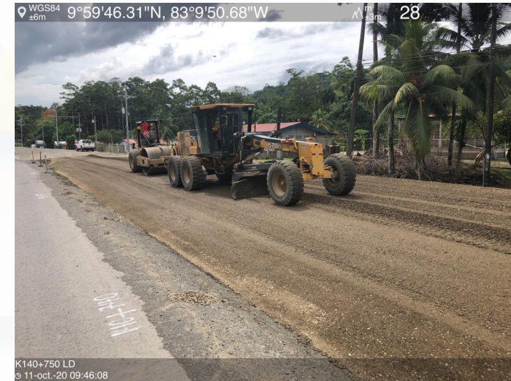
Trabajos de relleno en Km 140+750 LD
