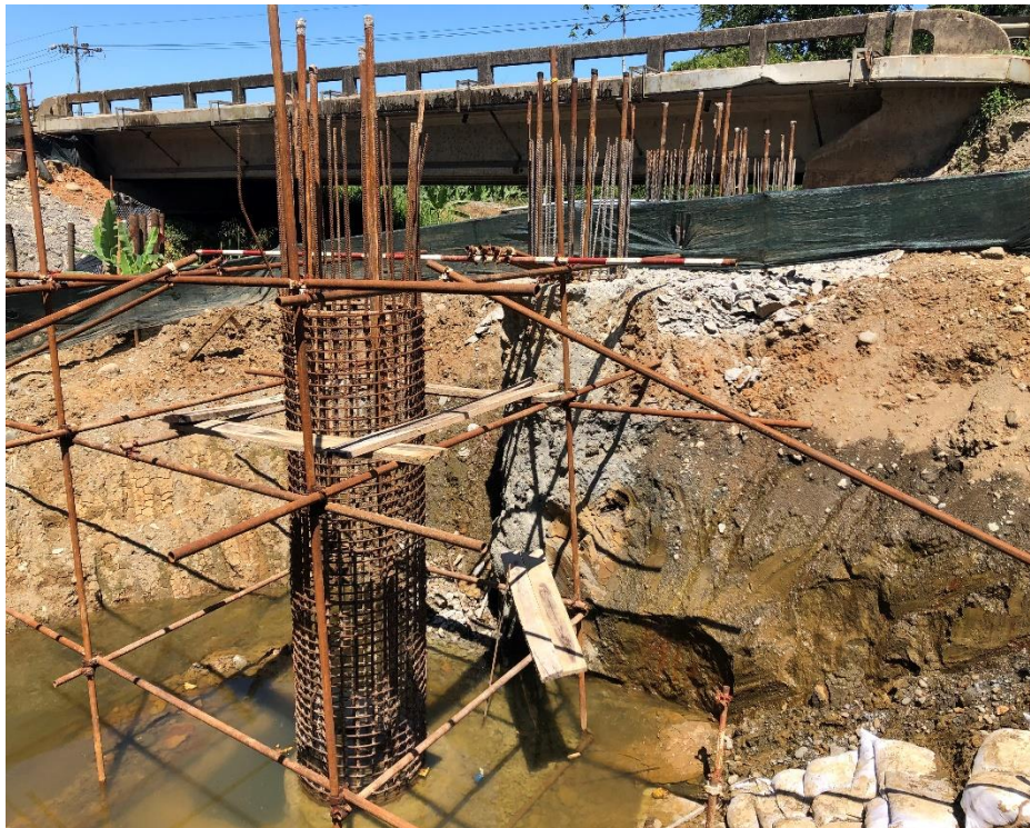
Avances en la base del puente sobre el Río Rojo y Río Toro.
