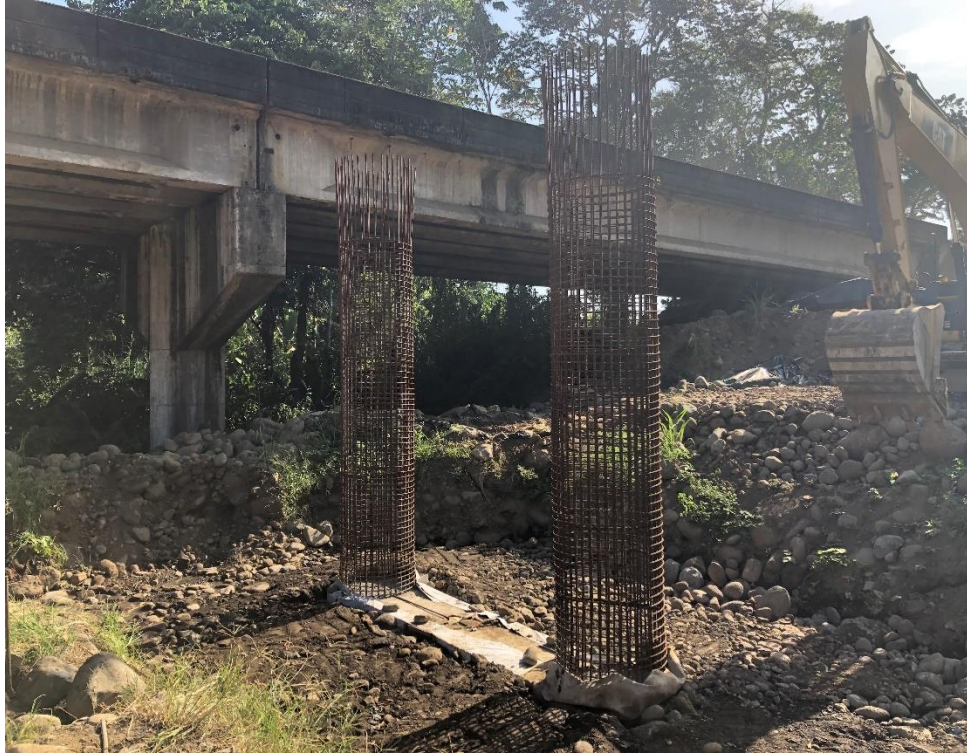
Avances en la base del puente sobre el río Guácimo, Guacimito y Parismina.
