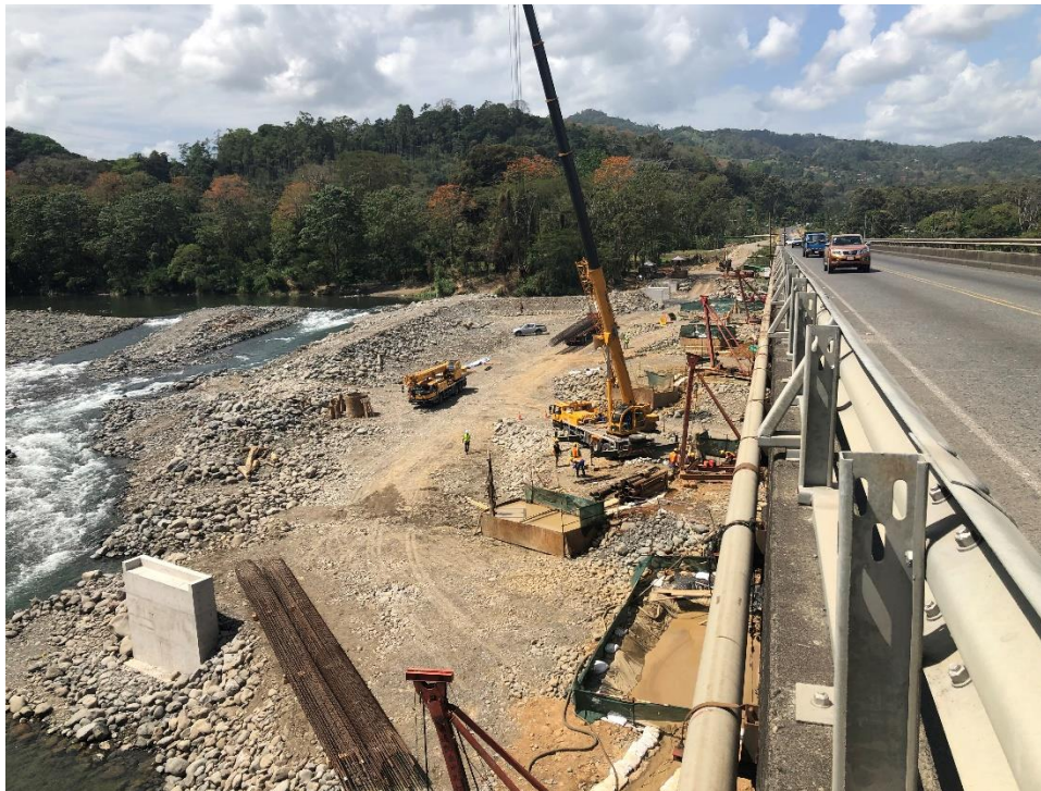
Avances en la base del puente sobre el Río Pacuare, Quebrada Calderón y Aguas Claras
