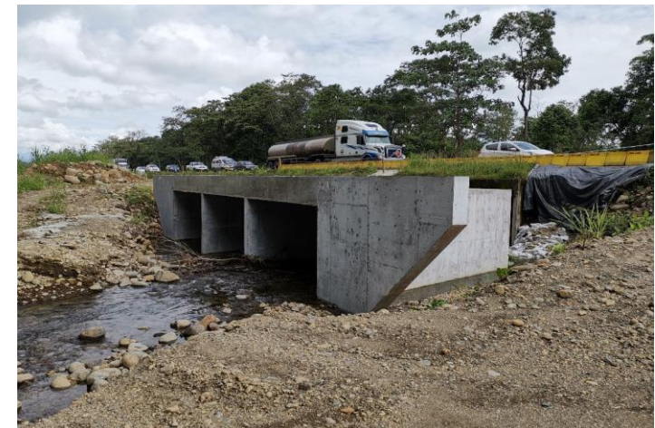
Avances en la base del puente sobre el Río Chirripo y Construcción de alcantarilla Kilometro 60+247.
