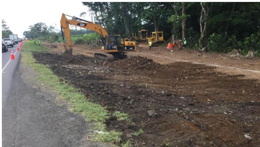
**Fotografías del proceso de Corta de árboles y limpieza del derecho de vía**
