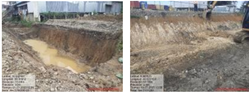
Figura 4. Excavación para gaviones km 132 y perfil de lado izquierdo, km 151
