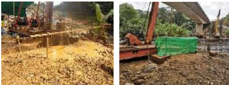
Fot. Izquierda: Lodos en el puente sobre el río Hondo, pilotera N°14. Se debe controlar y dirigir el flujo de lodos hacia la pila, para evitar la contaminación del río con lodos. Derecha: Control de lodos de perforación de pilotes.
