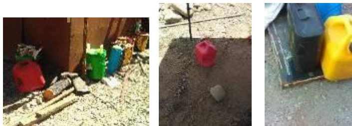
Fot. Recipientes con diésel, los cuales carecen de bandejas para contención de derrames. Los recipientes se colocan directamente sobre el suelo, sin que se coloque algún plástico, bandeja o cualquier otro medio impermeabilizante.
