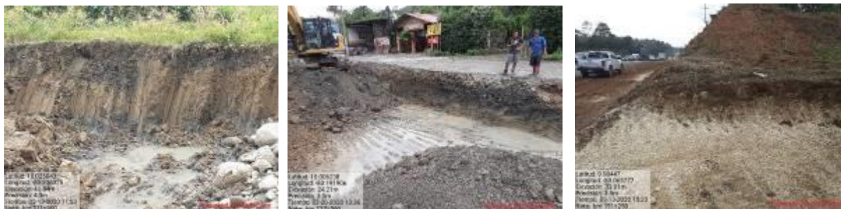
Figura 8. Km 131, corte con perfil de arcillas, tramo 4; km 137, presencia de arcillas y km 151 excavación de capa coralina, respectivamente.
