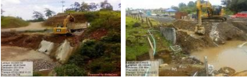
Figura 5. Zonas de trabajo en alcantarillas y desagües del tramo 1.
