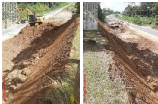
Figura 7. Inspección de perfil de talud en el km 90+950, tramo 3.
