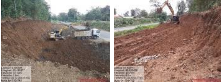
Figura 11. Trabajo de terracería entre el km 103 y 104.
