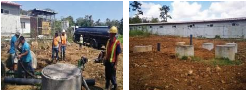
Fot. Mantenimiento y reparación del sistema de manejo de aguas residuales, plantel k93.
