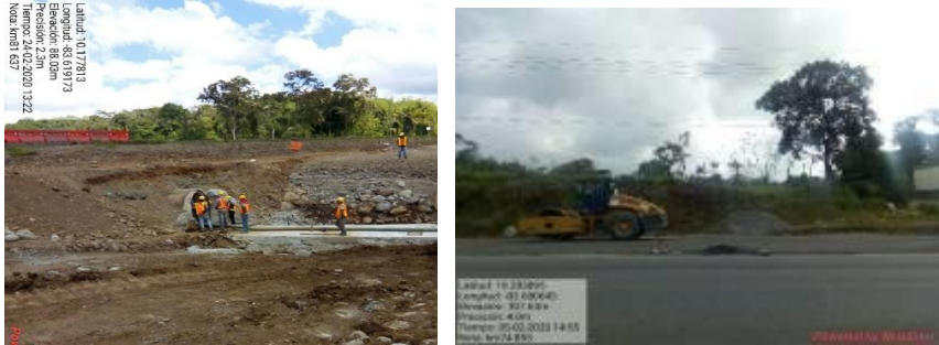
Figura 6. Inspección de trabajos en distintos puntos de este sector, tramo 2.
