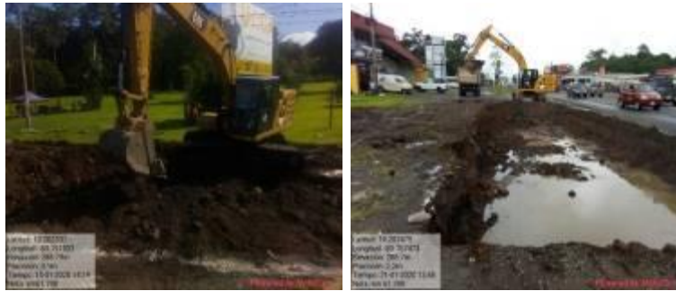
Figura 1. Excavación de vía en zona comercial de Guápiles.
