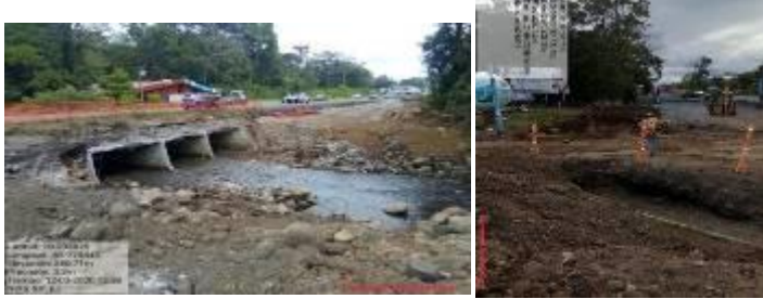
Figura 10. Zonas de trabajo de encauzamiento de río y colocación nueva tubería.
