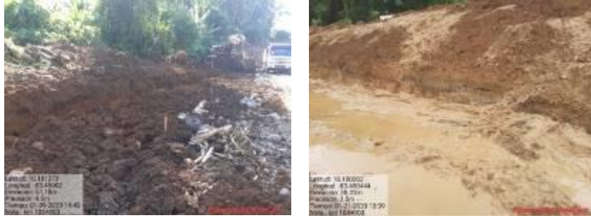
Figura 3. Excavación del derecho de vía km 102 y km 104.
