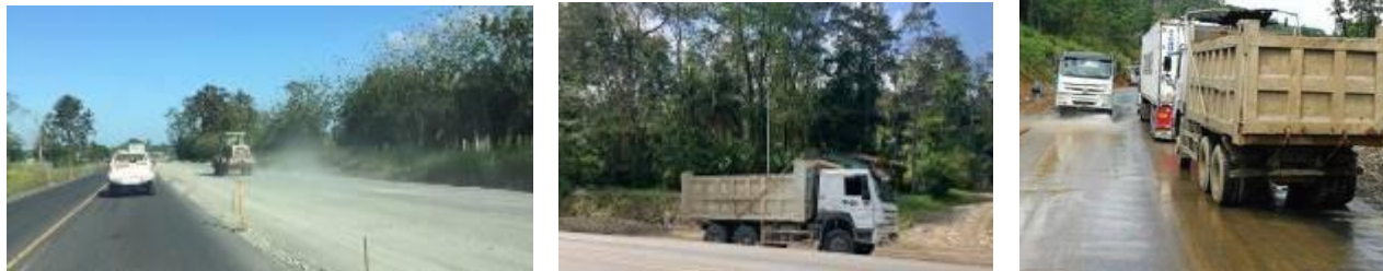
Fot. Generación de polvo en subrasantes, sistema mecánico de manteado en vagonetas, riego para el control de polvo.
