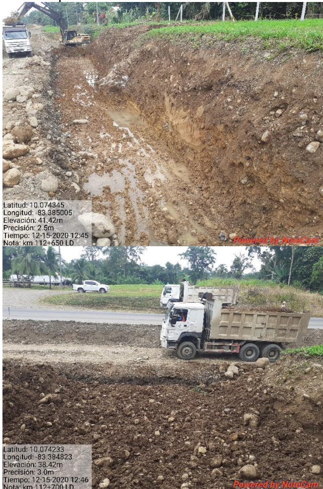
Figura 12. Excavación de lado derecho en el km 112.
