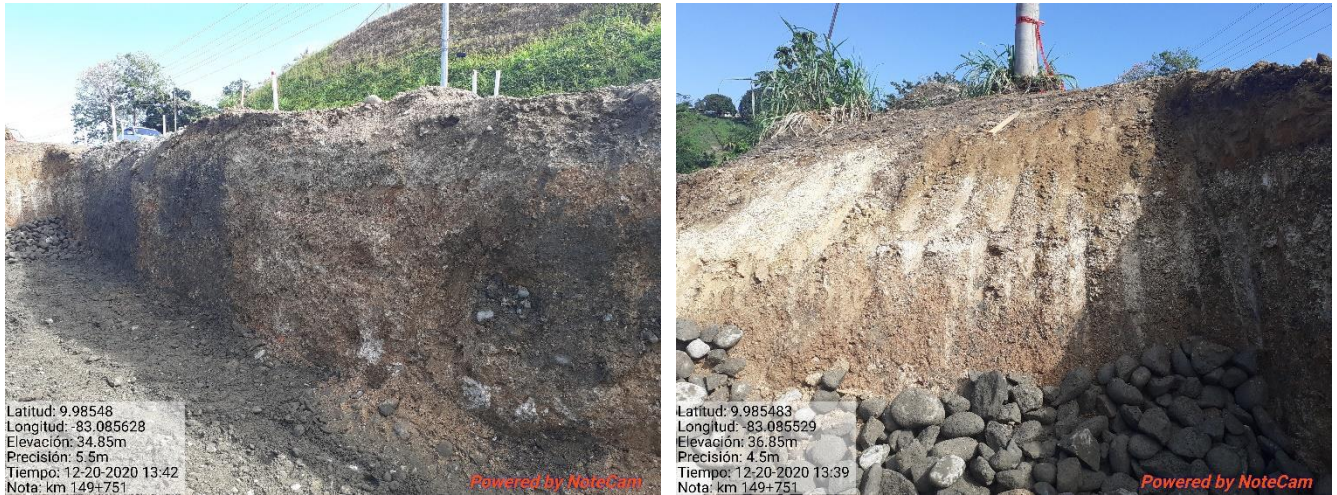
Figura 13. Trabajos de zanjeo para colocación de muro de gaviones.
