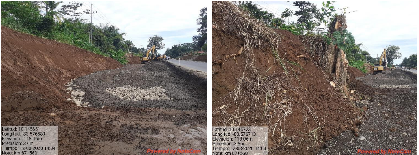
Figura 4. Conformación de vía provisional km 87+560.
