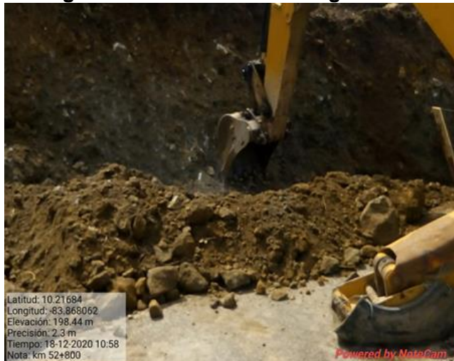
Figura 2. Excavaciones en algunos sectores para construcción de cunetas
