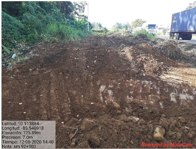
Figura 6. Limpieza y excavación en el Km 92+900.
