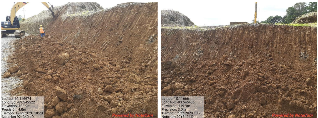
Figura 5. Limpieza del talud km 92+340
