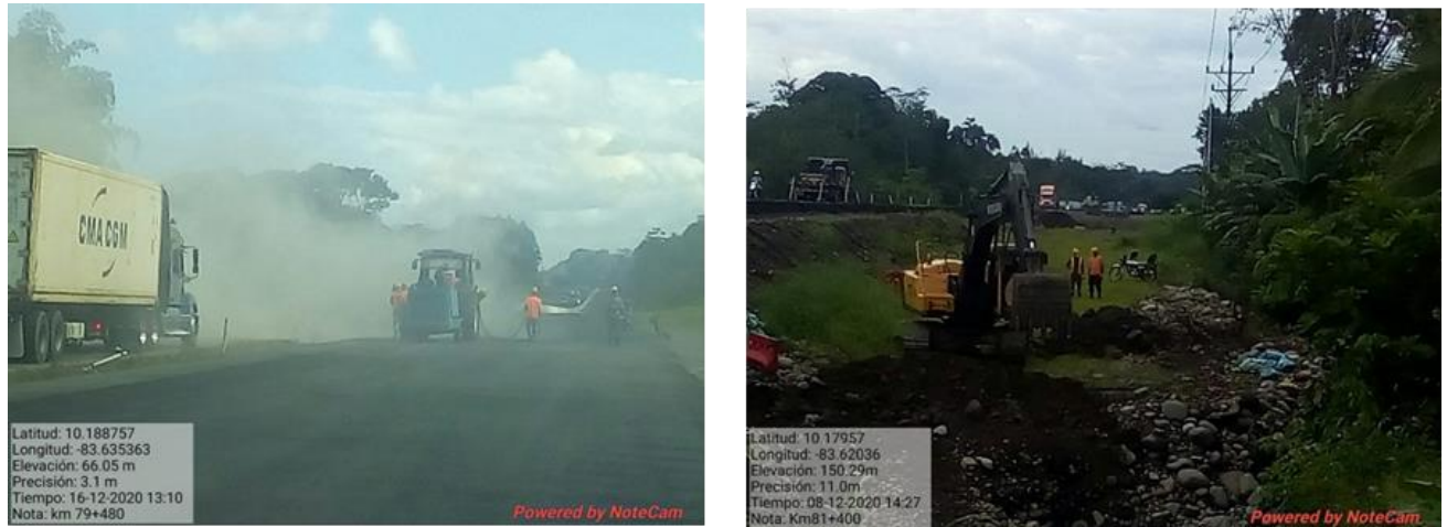
Figura 3. Obras en el km 79 y km 81
