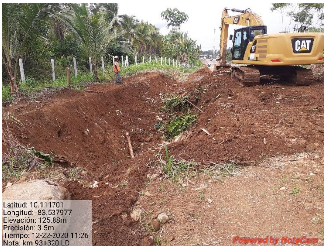
Figura 7. Excavación del derecho de vía en el km 93.
