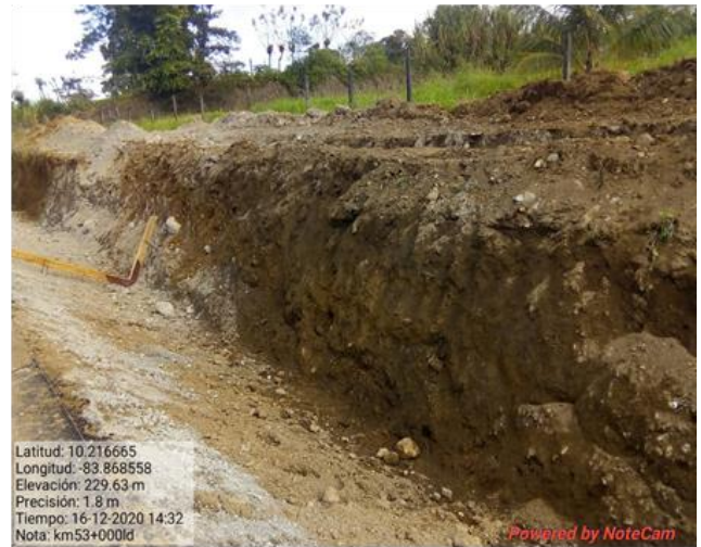
Figura 2. Excavaciones en algunos sectores para construcción de cunetas
