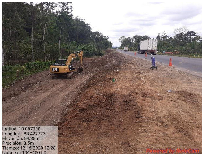
Figura 11. Trabajos de conformación de la vía en los km 106 y 107.
