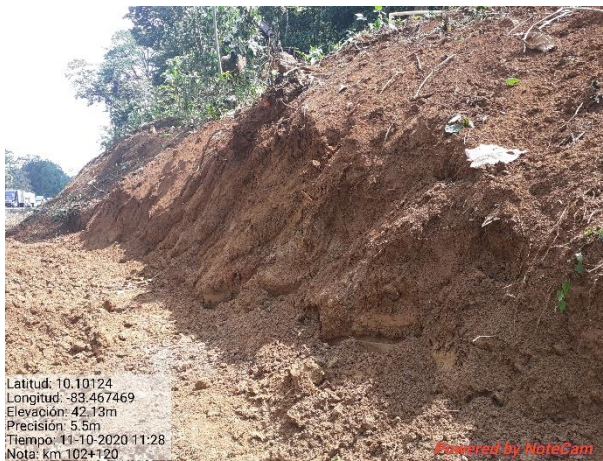
Figura 9. Limpieza y excavación en el km 102+120 al 130.
