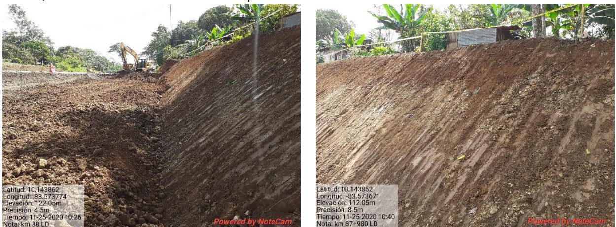
Figura 7. Excavaciones y conformación de talud km 87+900.
