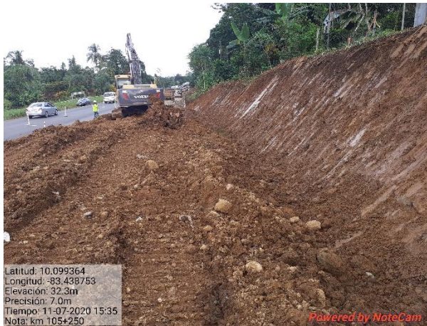
Figura 13. Conformación de los taludes entre el km 105+205 al +400.
