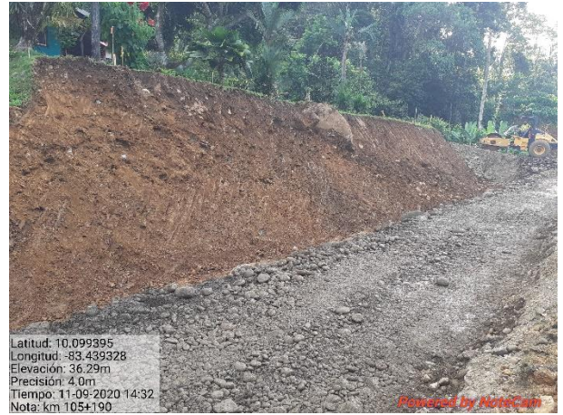
Figura 12. Excavación y relleno en el
