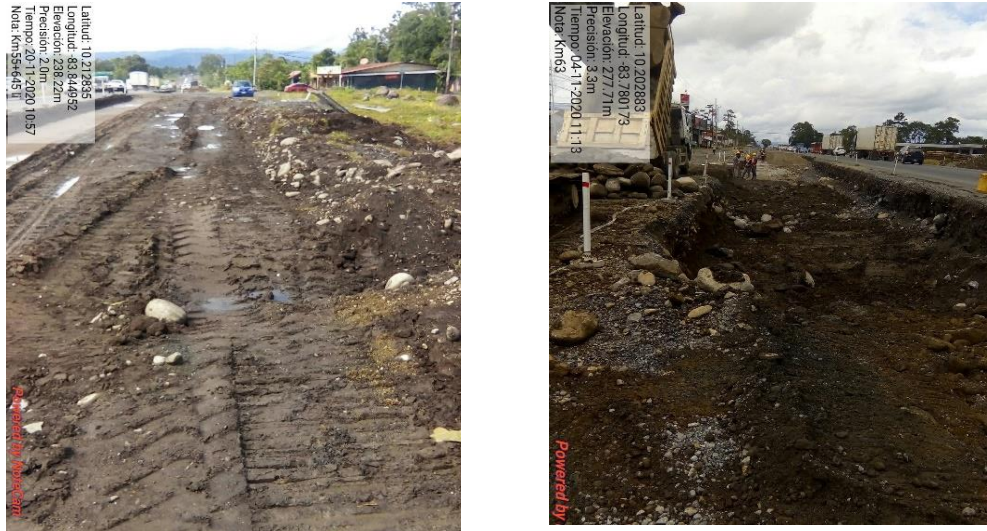
Figura 3. Diferentes momentos de excavación en puntos del Tramo 1.
