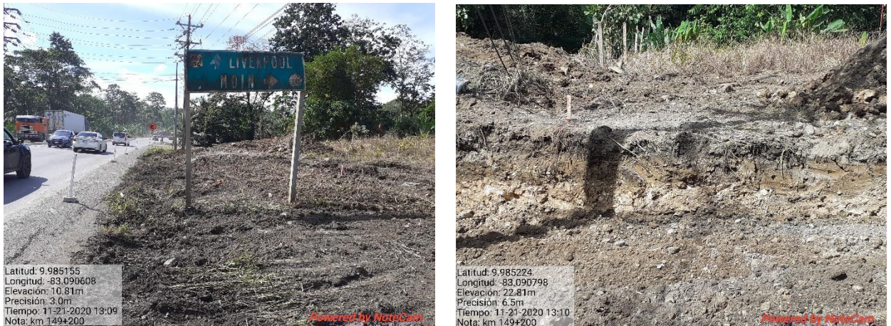
Figura 15. Limpieza de capa vegetal y nivelación de talud.
