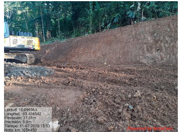
Figura 13. Conformación de los taludes entre el km 105+205 al +400.
