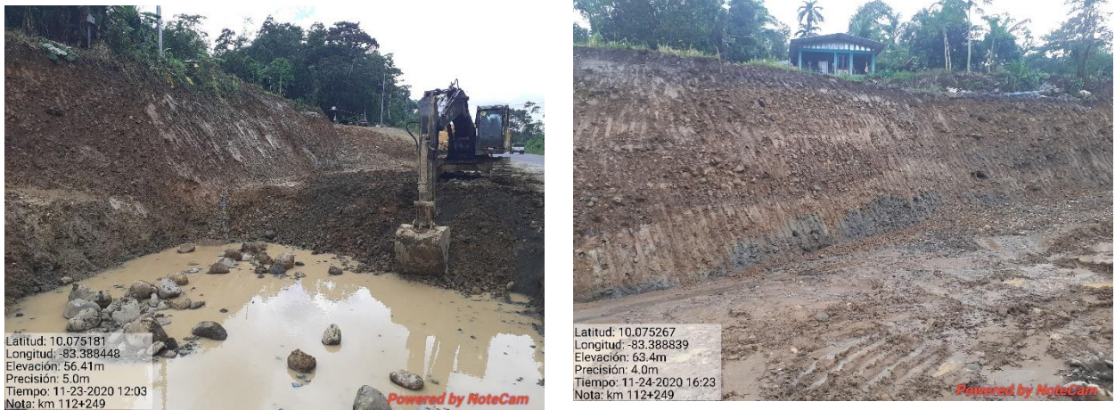
Figura 14. Excavación de lado derecho en el km 112.
