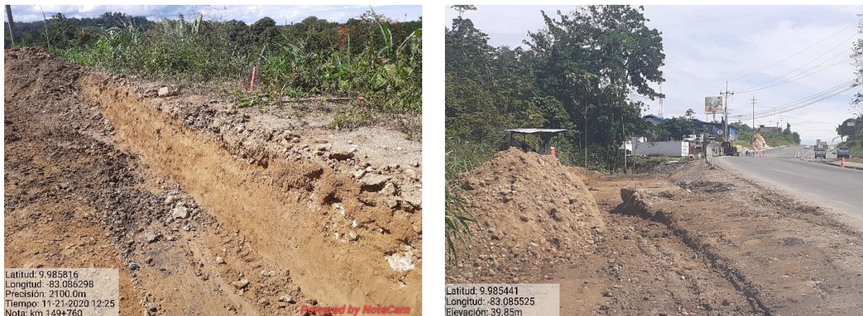
Figura 17. Trabajos nivelación en el km 149+700
