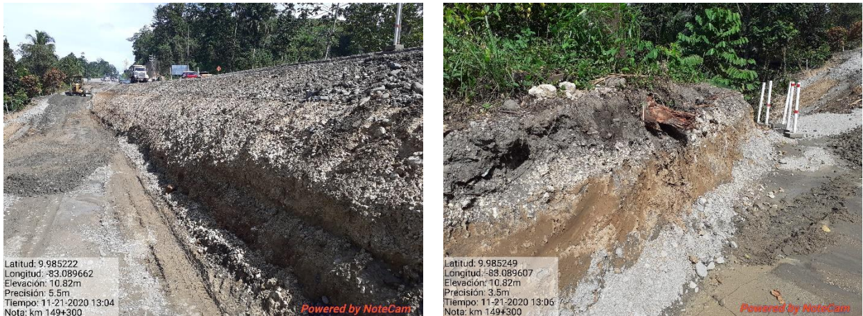
Figura 16. Trabajos de relleno en el km 149+300
