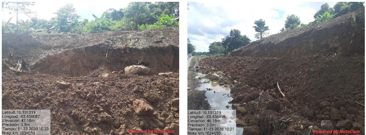
Figura 10. Excavación del perfil en el km 103+050
