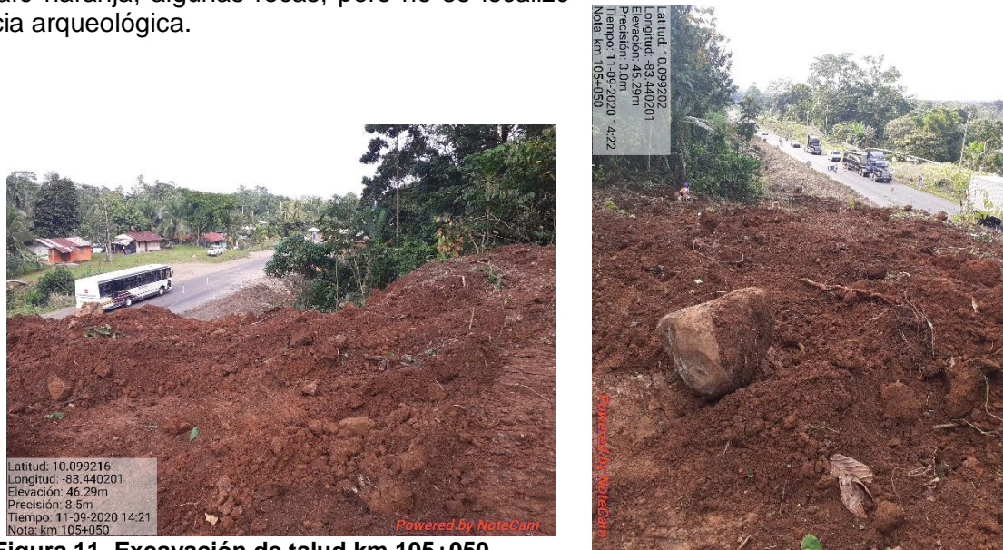
Figura 11. Excavación de talud km 105+050
