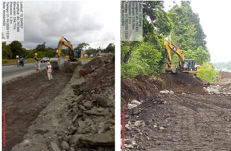
Figura 3. Extracción de asfalto/ excavación y colocación de material
