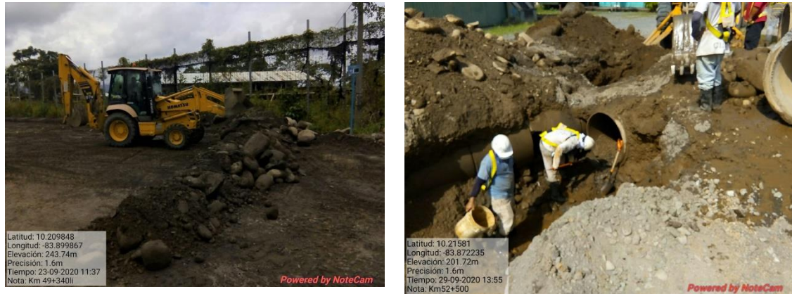
Figura 1. CODOCSA trabajando en km49+340 y km52+500 LI
