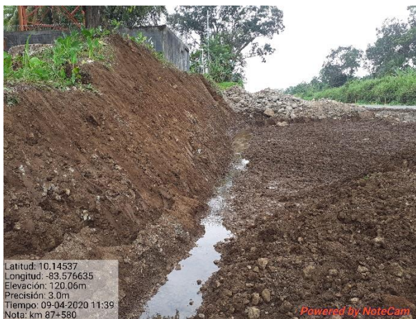
Figura 15. Excavaciones del perfil de la vía.
