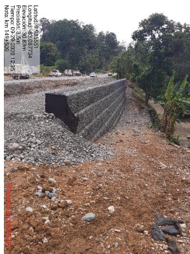
Figura 19. Excavación y colocación de muro de gaviones .
