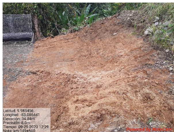
Figura 19. Excavación y colocación de muro de gaviones .
