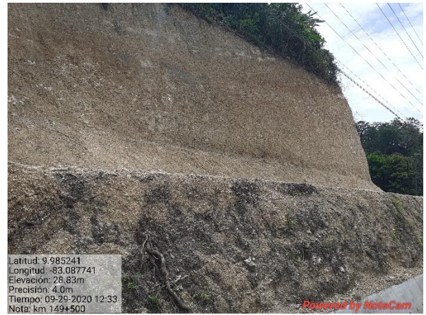
Figura 18. Excavación de talud.
