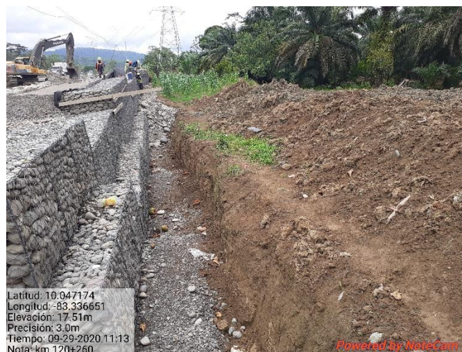
Figura 17. Excavación y colocación de muro de gaviones.
