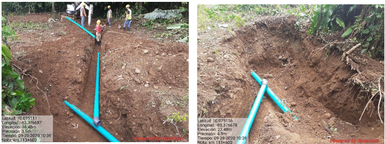
Figura 16. Excavación para colocación de servicios públicos.
